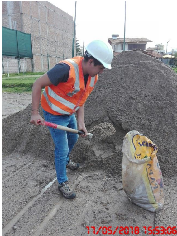
Fotografía 1: Extracción de material de la cantera Roca Fuerte
