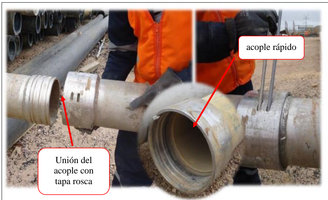
Figura N°10. Acople rápido para iniciar la instalación del pozo.
