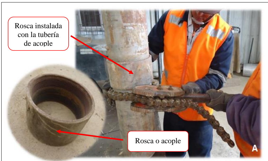
Figura N° 8. Enroscado de tubería de acople rápido para iniciar la instalación del pozo.
