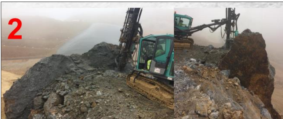
Figura 17. Etapas 1 y 2 de la tarea: Voladura Secundaria con Plasma
