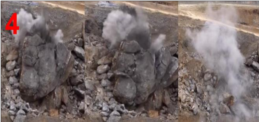
Figura 18. Etapas 3 y 4 de la tarea: Voladura Secundaria con Plasma
