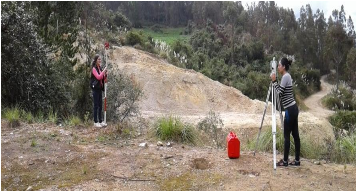
Figura 56. Levantamiento topográfico del terreno con la estación total.
