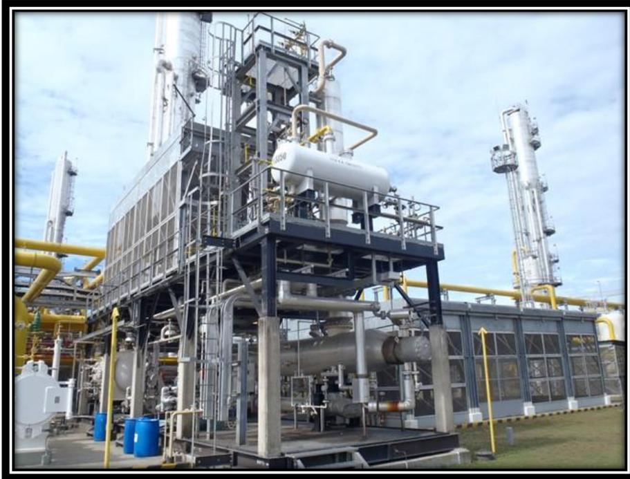
*Figura 26: Planta de Regeneración de Trietilenglicol*
