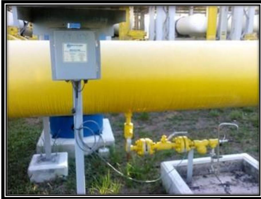
*Figura 31: Sistema de monitoreo de corrosión*
