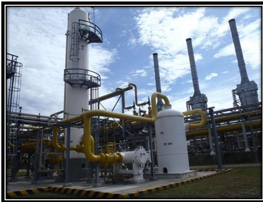
*Figura 25: Torre Contactora de Trietilenglicol*
