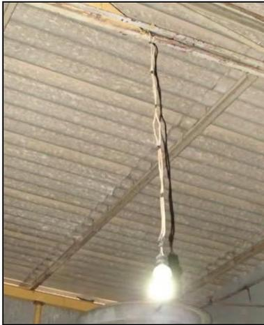
Figura 28: Instalación eléctrica riesgosa
