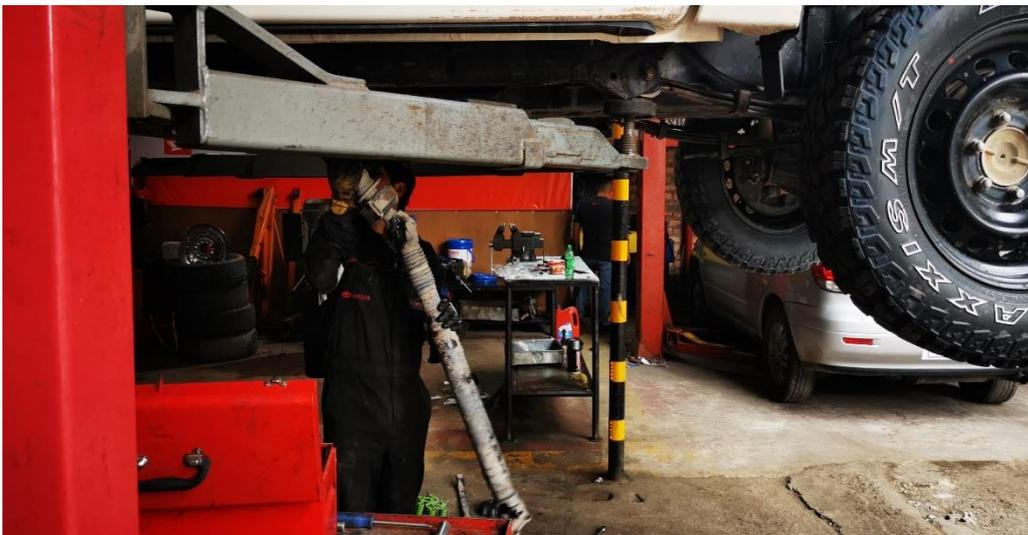
Figura 9. Mecánico retirando barra estabilizadora, para cambio de disco de embrague.
