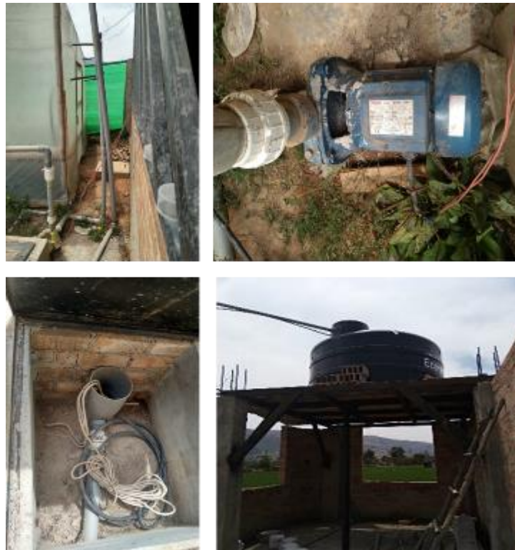
Figura 18: Instalación de la filtración de agua
