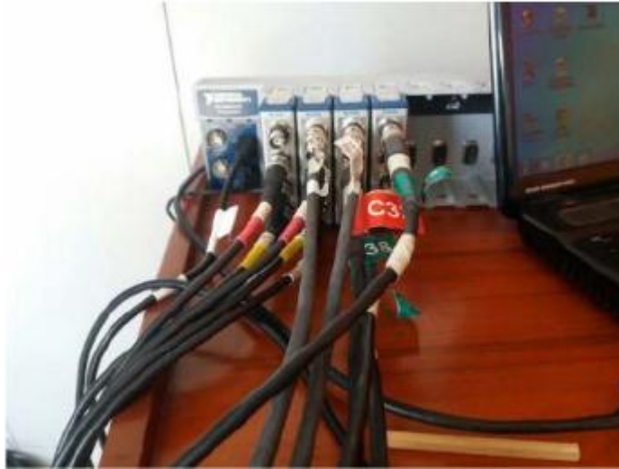
Figura 21. Instalación final con la unidad de toma de datos.
