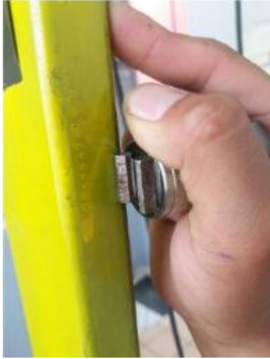
Figura 19. Instalación de acelerómetro.
