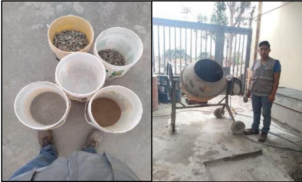
Figura. 41 Mezcla de los materiales para el concreto permeable
