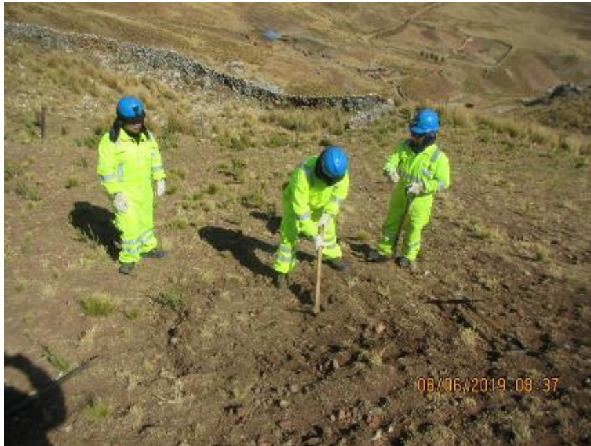
Inicio de excavación de calicata, DSB 1
