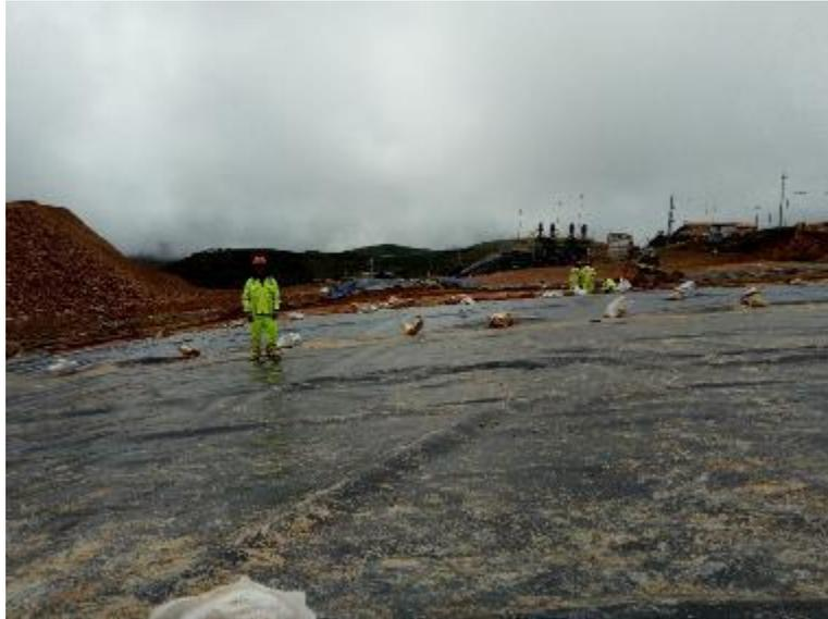
Fotografía 12: Construcción de la Plataforma de Lixiviación. Instalación de Geo-sintéticos.
