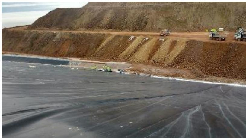
Fotografía 13: Transporte y descarga de mineral hacia la Plataforma de Lixiviación.
