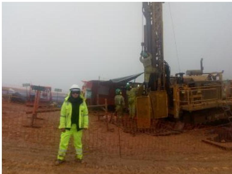
Fotografía 11: Perforación para instrumentación geotécnica.
