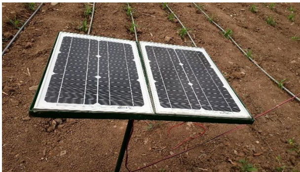
Figura 47: Implementación del generador de energía solar
