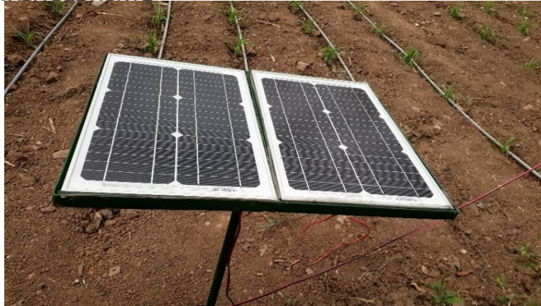
Figura 54: Instalación del generador de energía solar Fuente: Elaboración propia
