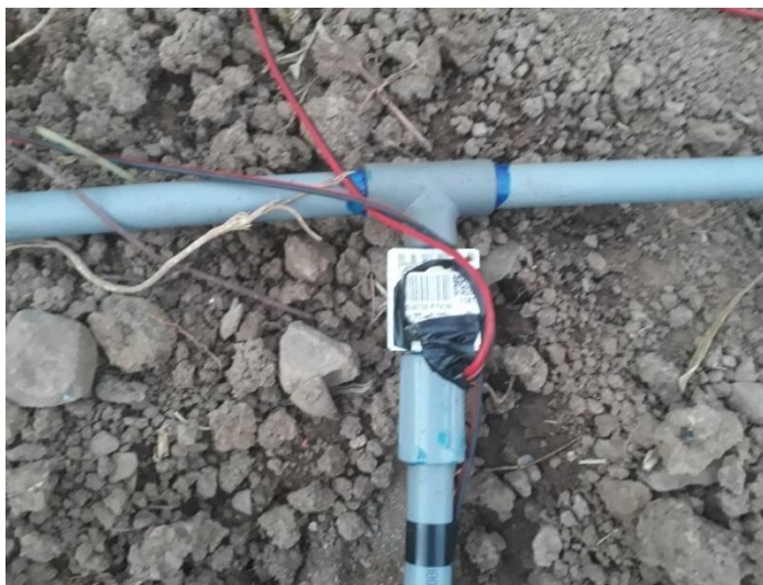
Figura 58: Instalación de electroválvulas Fuente: Elaboración propia
