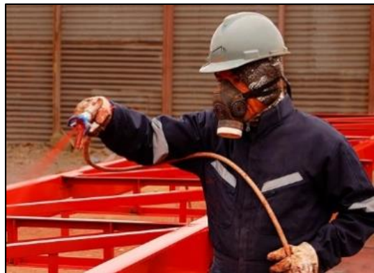
Figura 9: Proceso de aplicación de pintura
