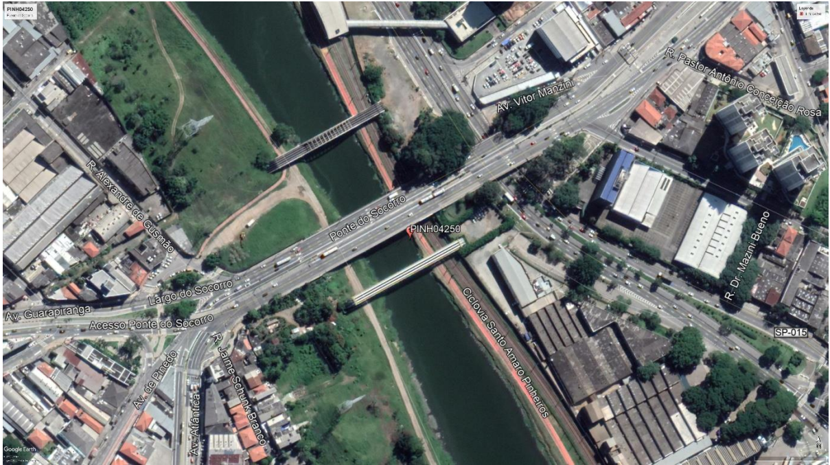
Figura 32. Puente Socorro (PINH04250) –Nota. Adecuado de Google Earth
