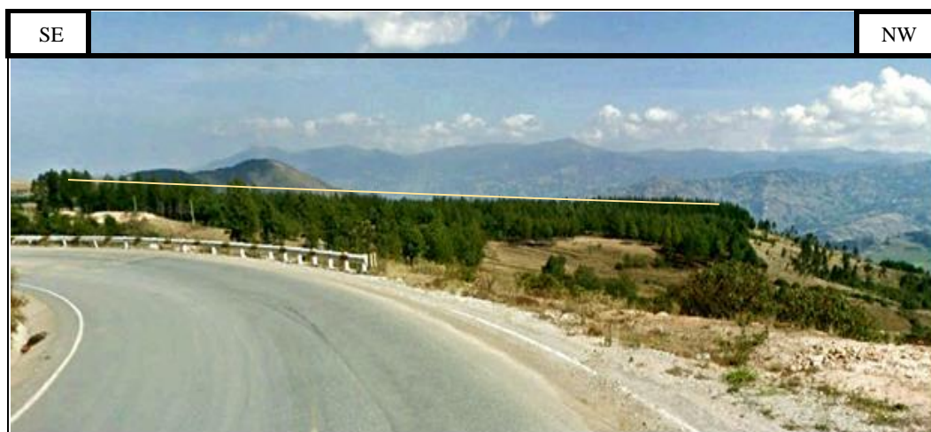
Figura 15: Lomada formada al noroeste de la carretera. N: 9220484 E: 746608
