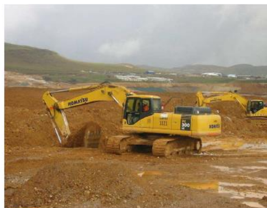
Ilustración 3: Fluffing ó batido del mineral con excavadoras Cat 330C y Komatsu PC 300.
