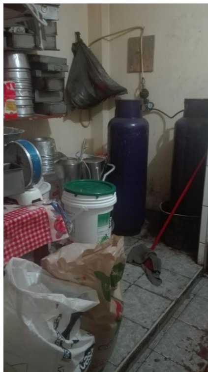
Figura 56. Gas utilizado por el horno industrial.
