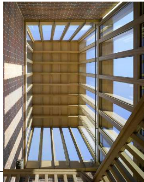
El uso de paneles de madera en fachada a manera de pantallas como estrategia de control acústico.
