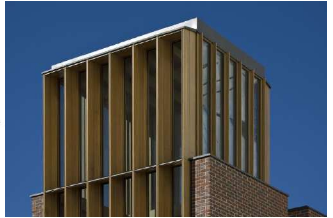
El uso de paneles de madera en fachada a manera de pantallas como estrategia de control acústico.
