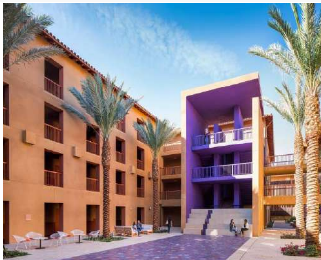
En el patio central, las fachadas se configuran a través de galerías.
