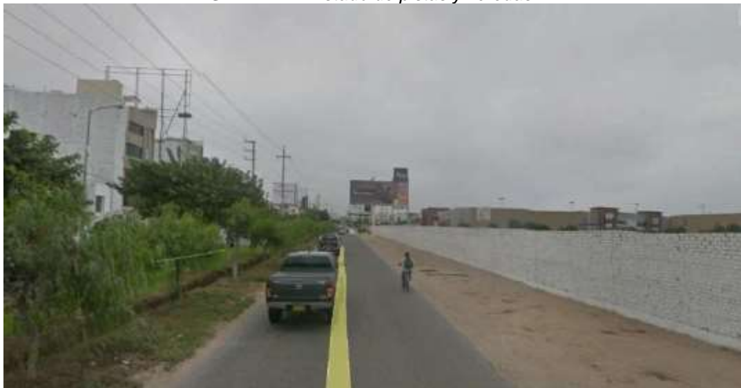
IMAGEN N° 41: Estado de pistas y veredas
