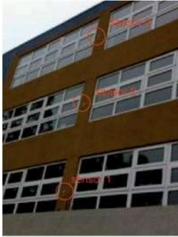
Figura 30: Sensores exteriores instalados en Colegio Almondale Valle Noble, Concepción.
