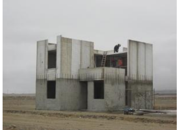
Vista del casco del primer nivel inyectado de la vivienda del sistema Emmedue-Las Terrazas de Huanchaco.
