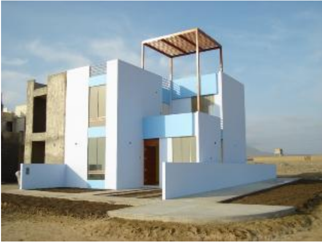
Vivienda típica de Emmedue – Las Terrazas de Huanchaco
