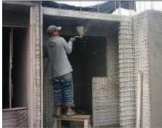
Figura 25: Lanzado del mortero en la cara inferior de la losa.
