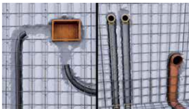
Figura 17: Instalación sanitaria y eléctrica.
