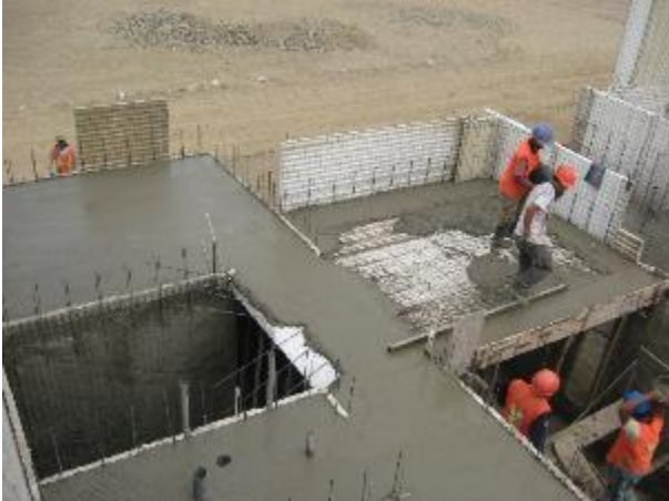
Vaciado de concreto en de losa de entrepiso de la vivienda de Emmedue- Las Terrazas de Huanchaco.
