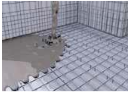
Figura 24: Vaciado de la losa superior del panel losa.
