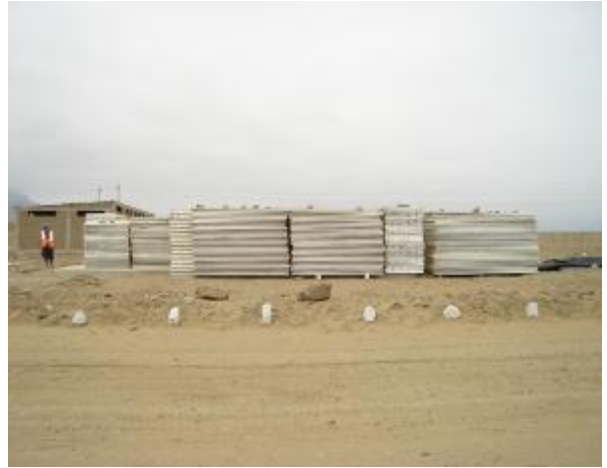
Vista de los paneles de Emmedue- Las Terrazas de Huanchaco
