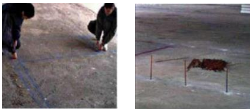
Figura 13: Trazado de replanteo y colocación de anclajes.
