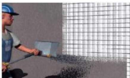
Figura 23: Inyección del mortero al panel.
