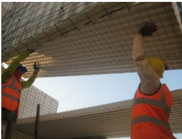
Montaje de paneles losa Emmedue- Las Terrazas de Huanchaco
