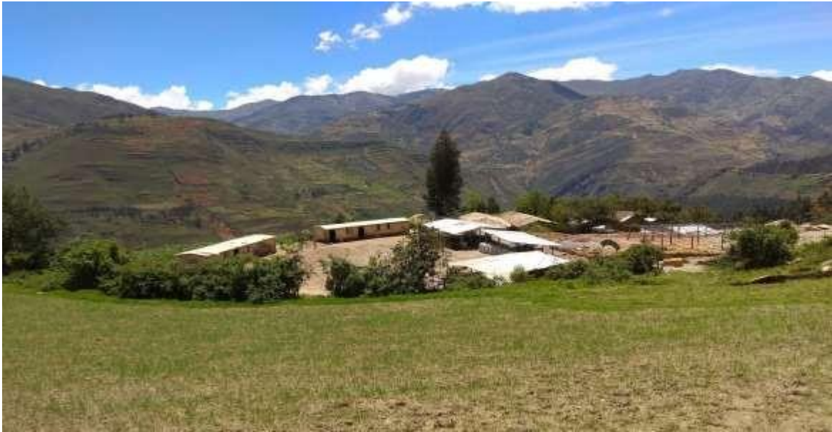
Fotografía 30: Vista panorámica de la Mina Nivel 2, Nueva Esperanza Trinidad.
