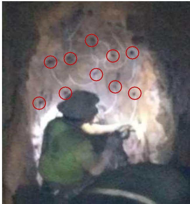
Fotografía 26: Personal realizando la distribución de los taladros. Fuente: Elaboración Propia.
