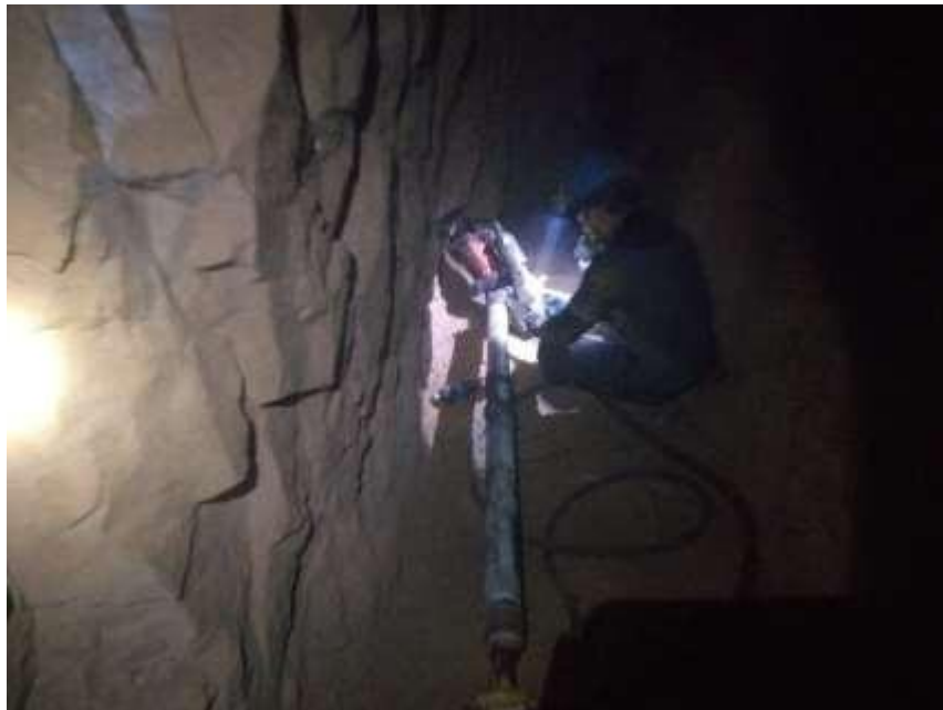
Fotografía 25: Personal en labores de Perforación.
