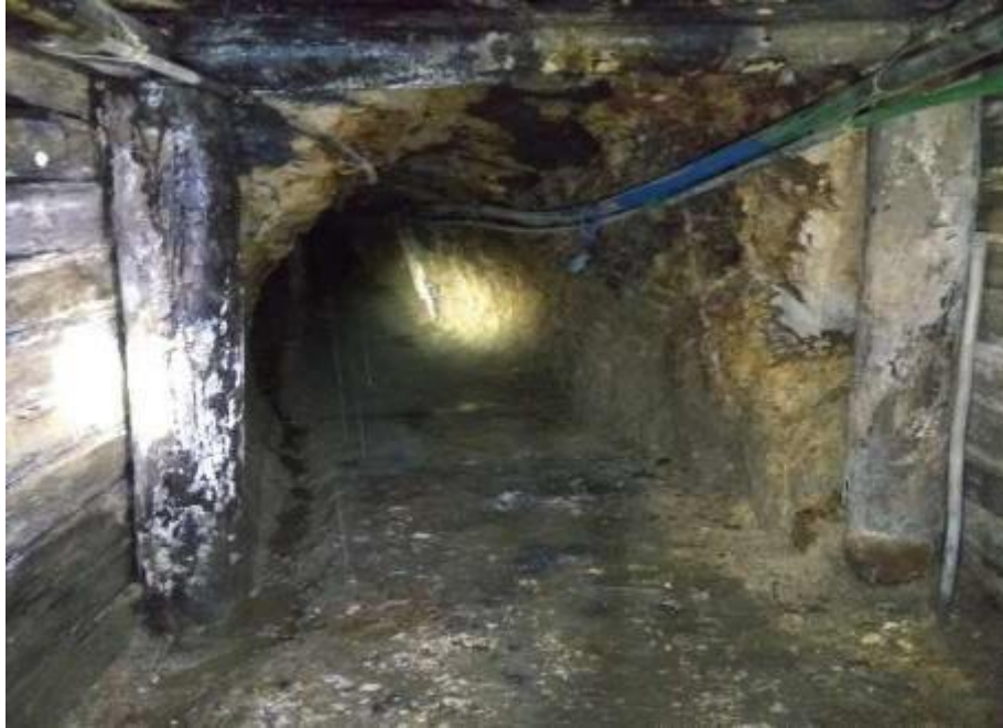
Fotografía 17: Galería de trabajo de la mina nivel 2, nueva esperanza trinidad. Fuente: Elaboración Propia.
