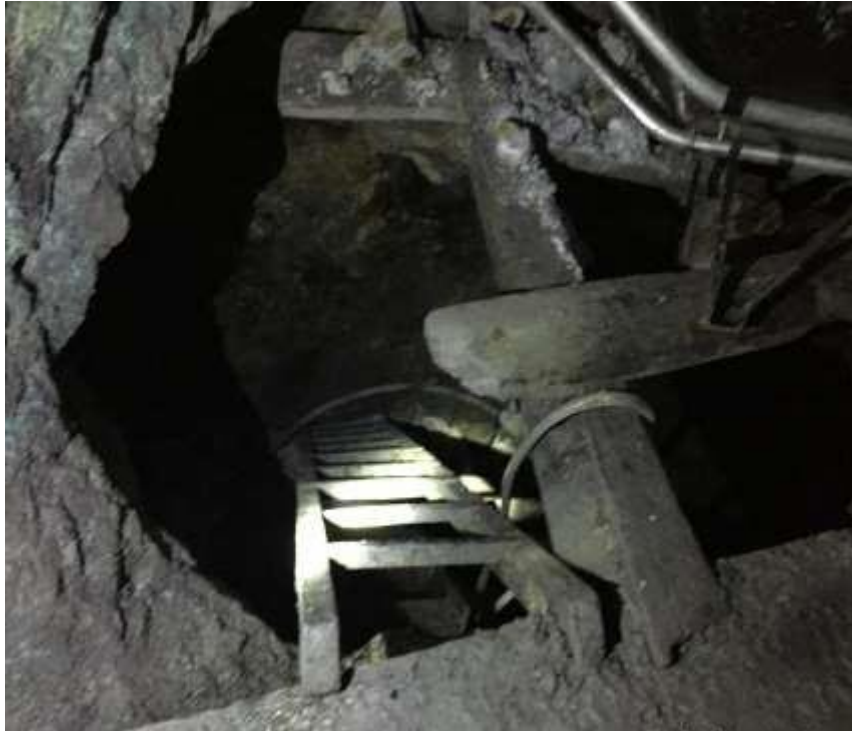
Fotografía 19: Pique de trabajo de la mina nivel 2, nueva esperanza trinidad.
