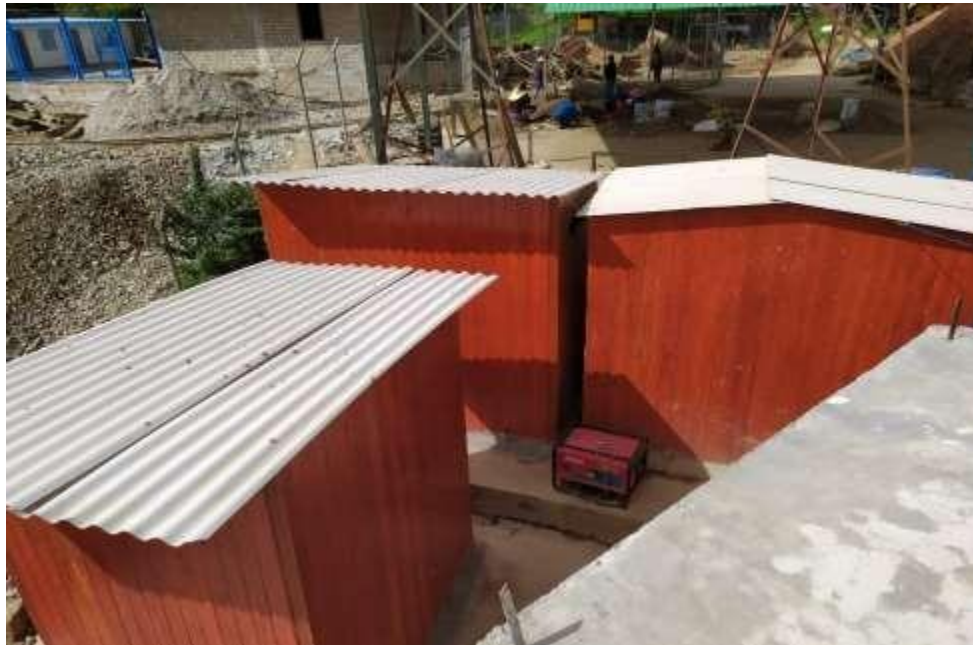
Fotografía 15: SSHH de la mina nivel 2, nueva esperanza trinidad. Fuente: Elaboración Propia.
