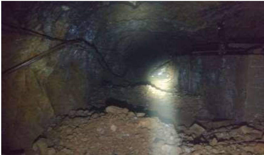
Fotografía 3: Galería de la mina nivel 2, nueva esperanza trinidad. Fuente: Elaboración Propia.
