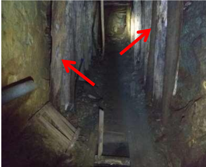
Fotografía 28: Tipo de sostenimientos con madera.
