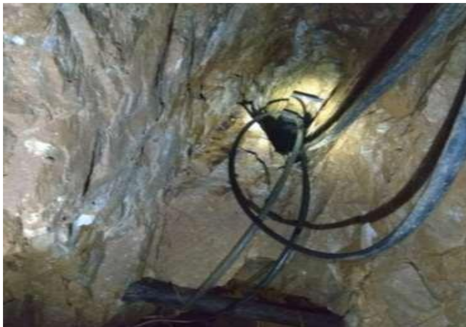
Fotografía 5: Chimenea 2 de la mina nivel 2, nueva esperanza trinidad. Fuente: Elaboración Propia.
