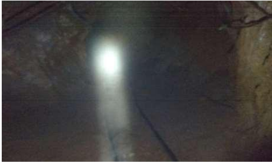
Fotografía 4: Chimenea 1 de la mina nivel 2, nueva esperanza trinidad. Fuente: Elaboración Propia.
