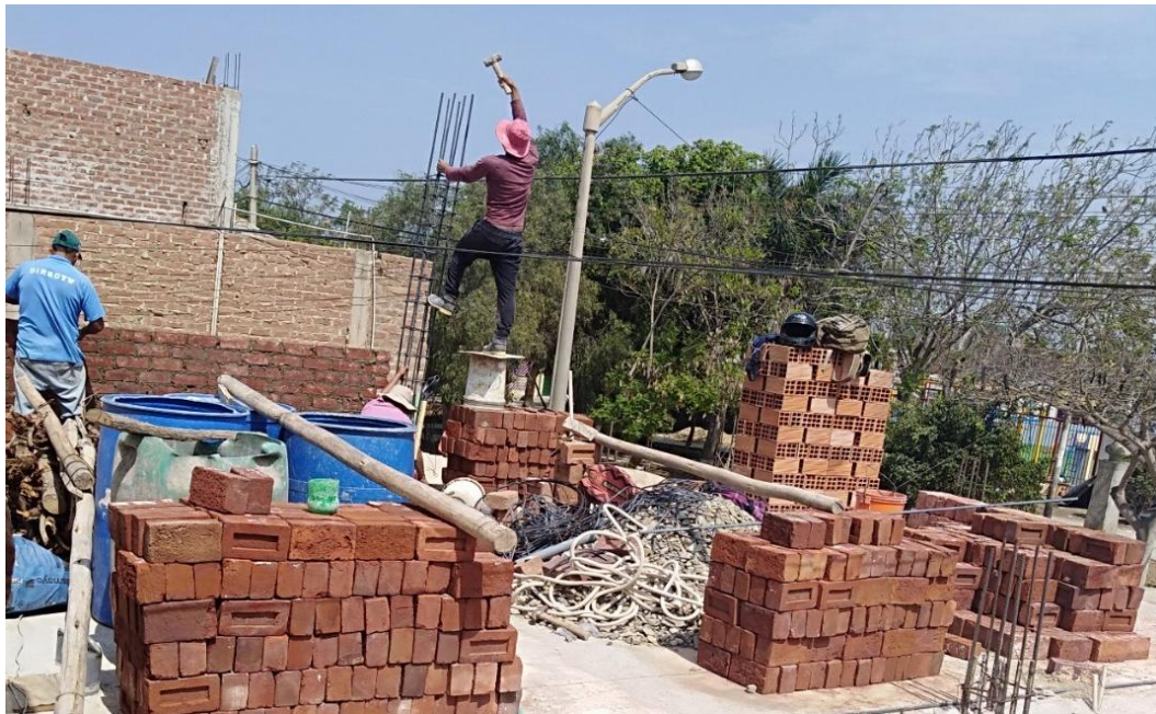
Ilustración 8. Construcción de un segundo nivel, en una vivienda informal, solo con un maestro empírico y sin ningún criterio técnico y de seguridad.
