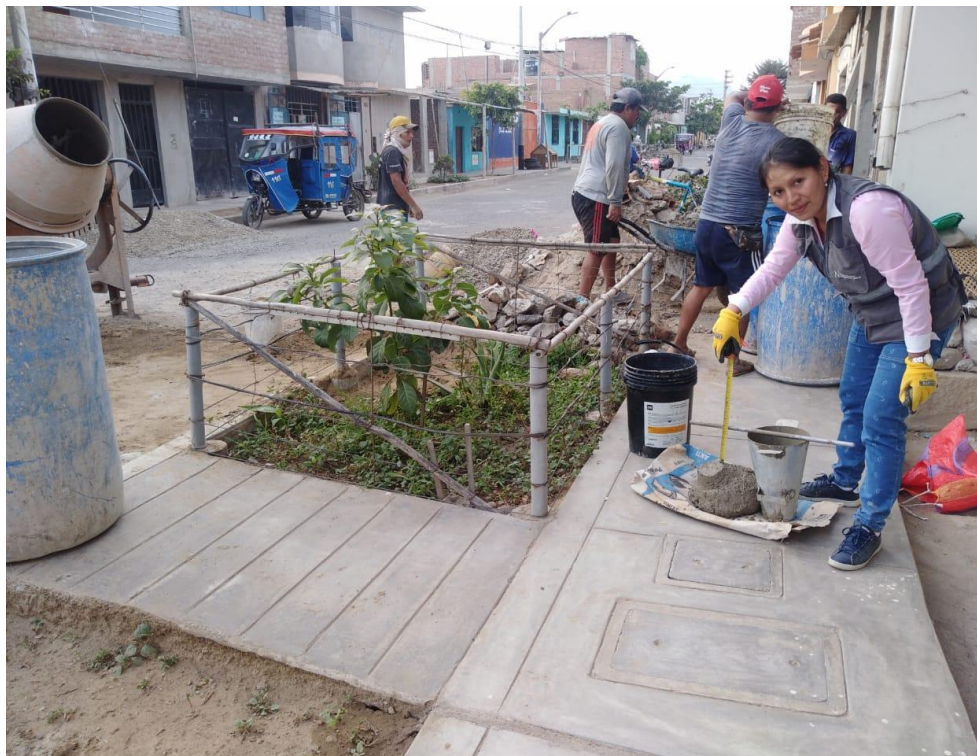
Foto. 6: Verificación de Slump, concreto para columnas en el sector Santa Verónica.
