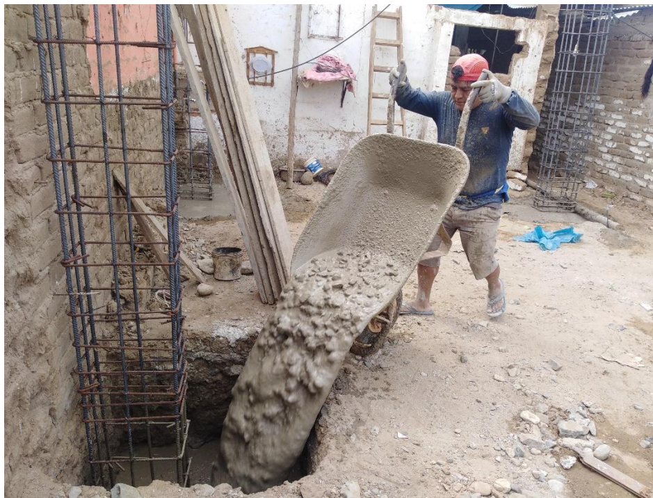
Foto. 4: Verificación de vaciado de zapatas con concreto muy fluido, con adición de piedra mediana.
