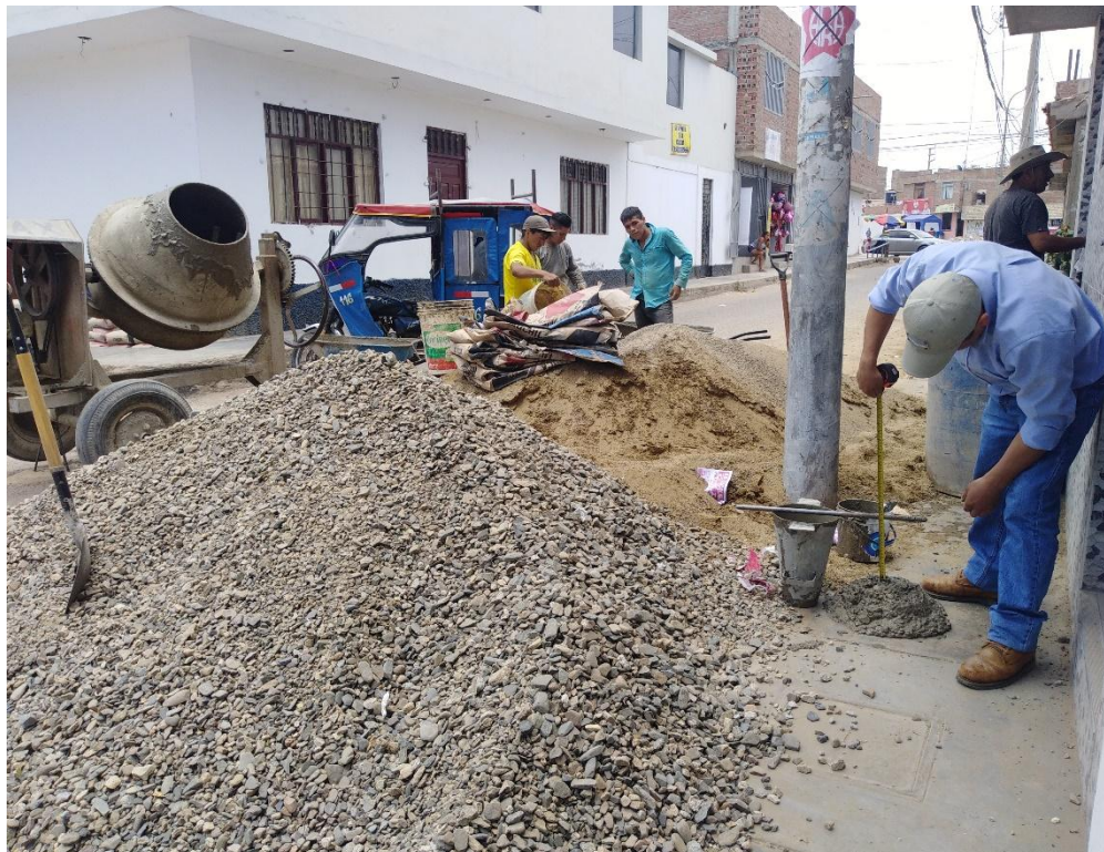
Foto. 2: Ensayo de concreto fresco en obra - P15
