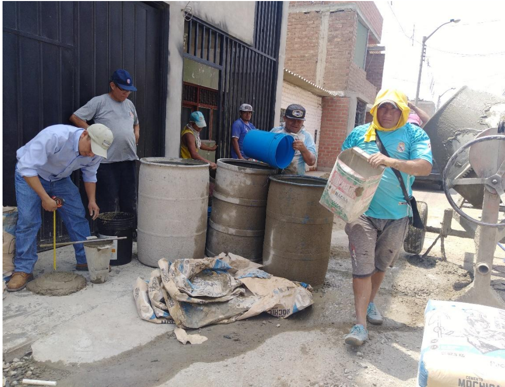
Foto. 1: Verificación de asentamiento, 8.25” en obra – P7
