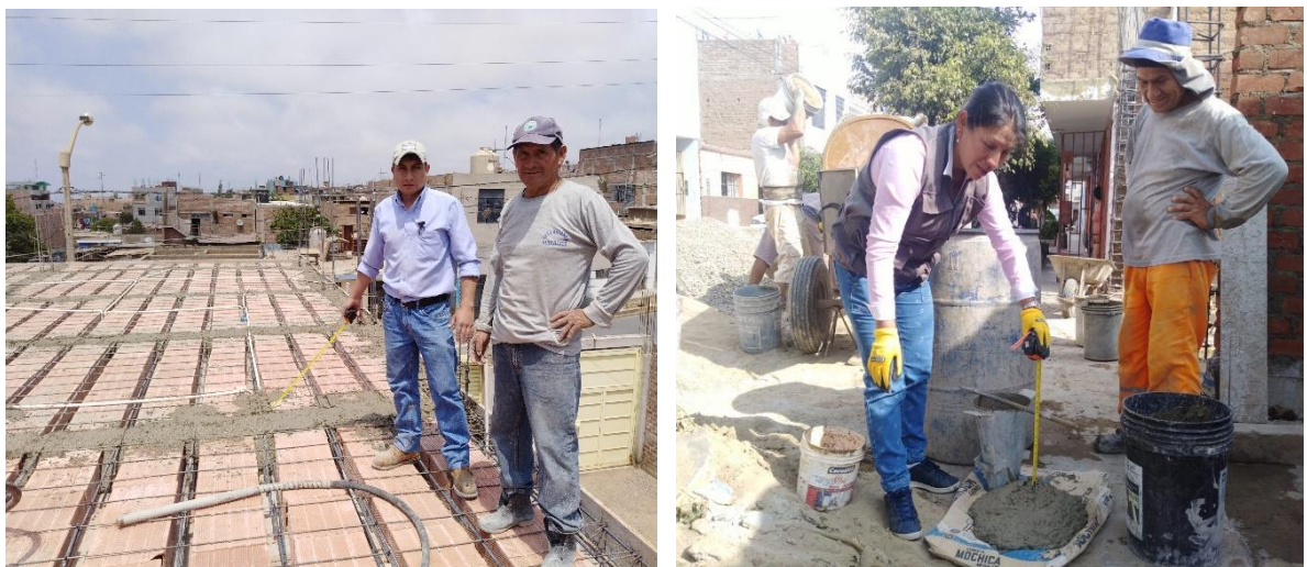
Ilustración 11. Verificación de vaciado de concreto en vigas y prueba de Slump.
