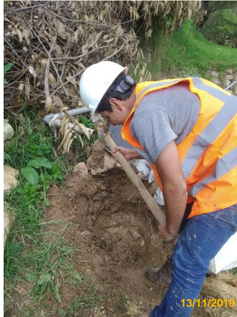
Figura 4. Excavación para instalación de filtro
