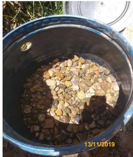
Figura 5. Capa de 0.20m de grava de 3/4”
