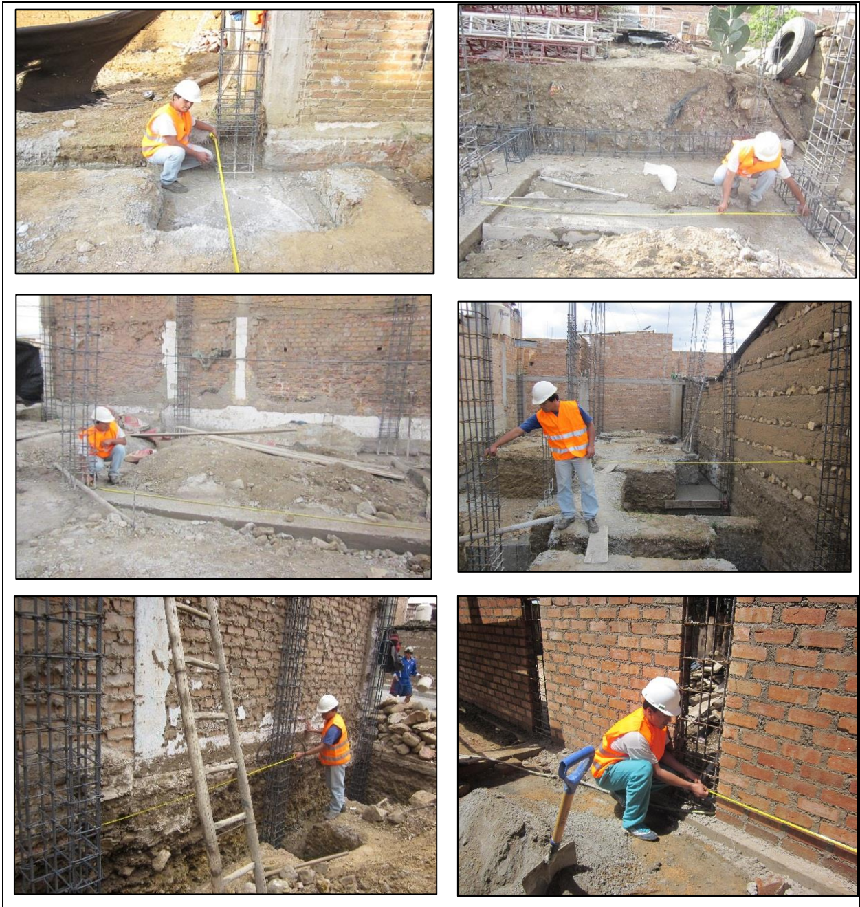
Figura 157. Toma de medidas entre columnas
