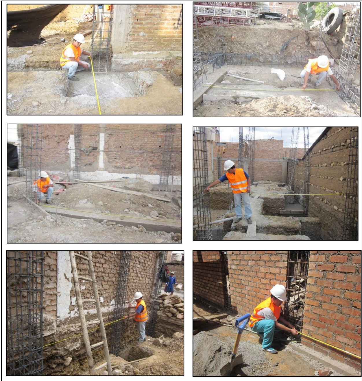
Figura 156. Toma de medidas entre columnas
