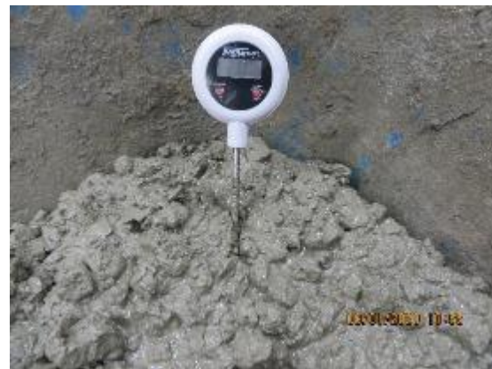
Fotografía n° 22. Control de temperatura del concreto antes de iniciar los ensayos de slump y peso unitario.
