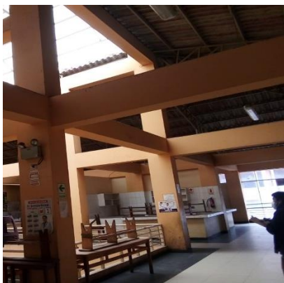
Figura 9. Medición de vigas y columnas
