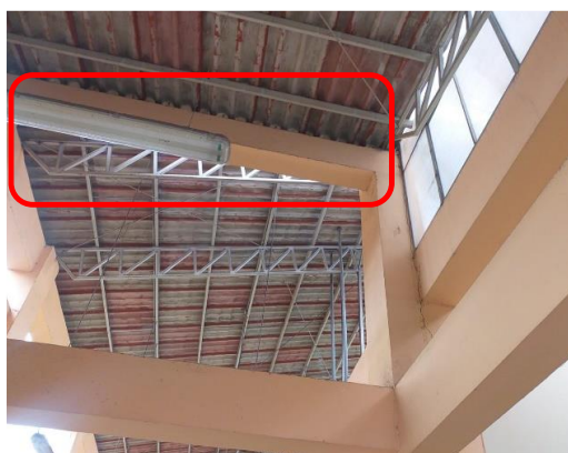
Figura 7. Vigas de concreto armado para el techo.
