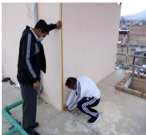
Figura 13. Inspección de la estructura del tanque.
