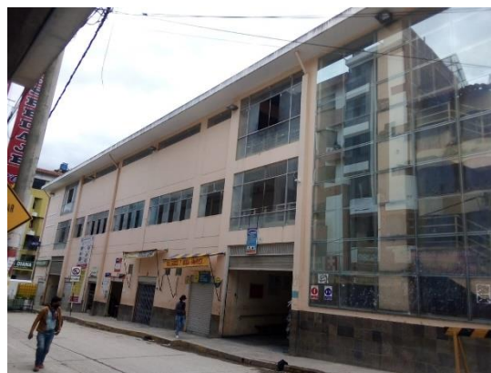
Figura 5. Vista del bloque A.
