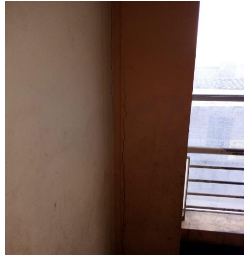
Figura 12. Inspección de Columna (Bloque B)
