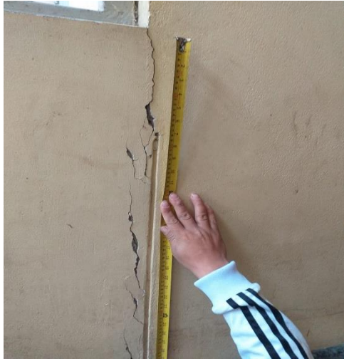
Figura 11. Inspección de Columna (Bloque A).
