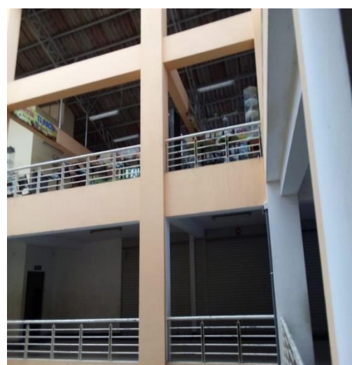
Figura 10. Bloque B: Vista interna.
