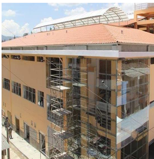
Figura 7. Bloque A: Vista externa.
