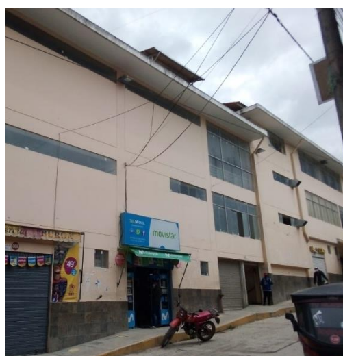
Figura 9. Bloque B: Vista externa.
