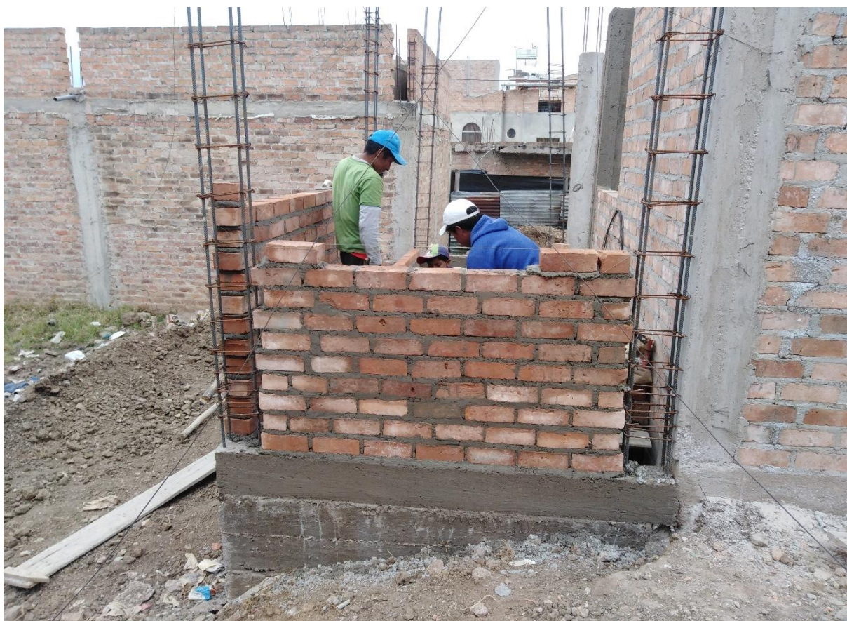
Figura 7. Se observa los muros de albañería – Vivienda N° 01.
