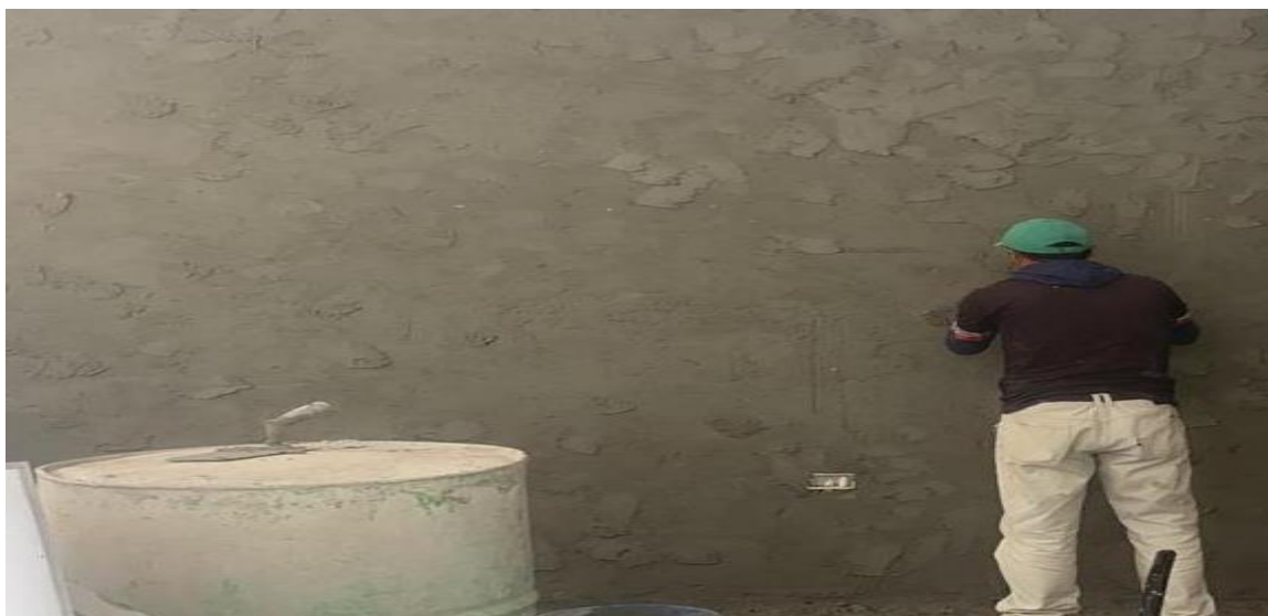
Figura 19. Se observa la colocación de mezcla en muro de interiores – Vivienda N° 02
