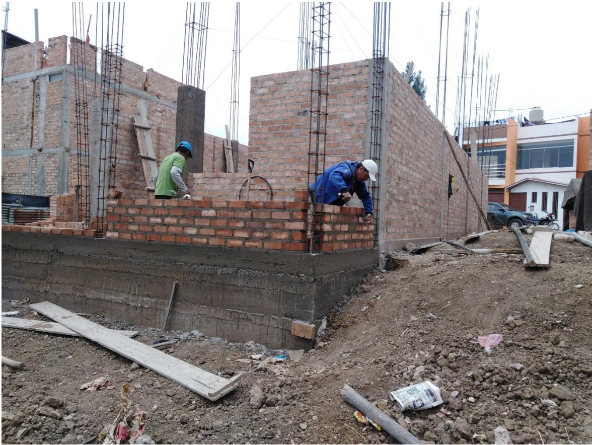
Figura 41. Verificación de acentado de ladrillo vivienda N° 2.
