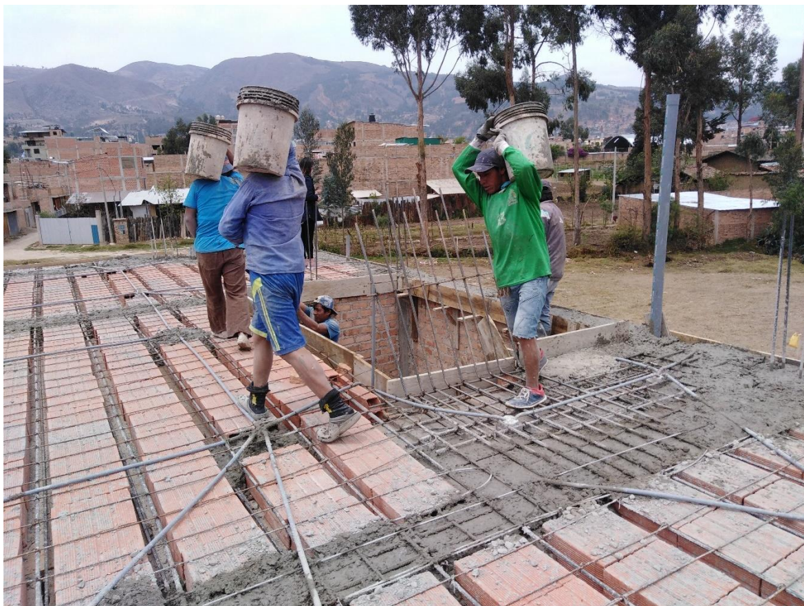
Figura 34. Traslado de mezcla de concreto en losa aligerada vivienda N° 2.
