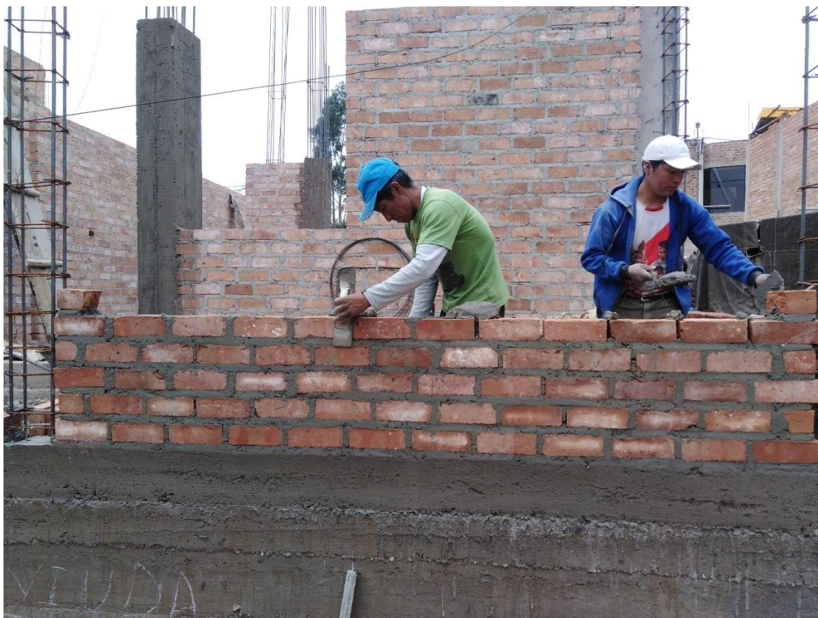
Figura 39. Acentado de ladrillo vivienda N° 2.
