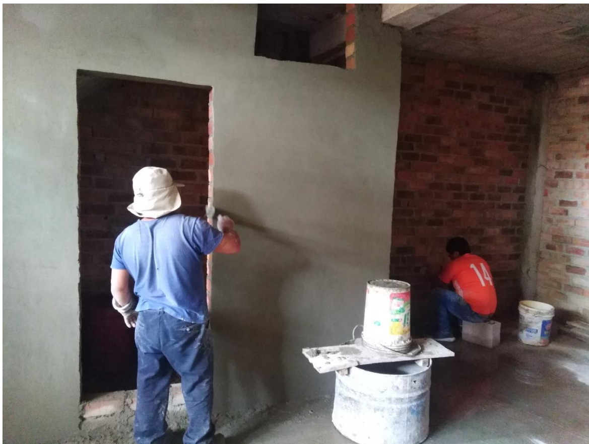
Figura 47. Acabado en muro de interiores vivienda N° 01.
