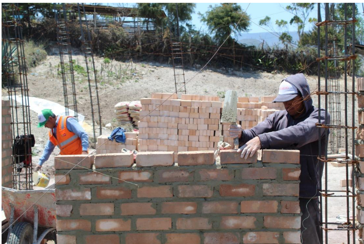
Figura 43. Enplantillado de ladrillo vivienda N° 3
