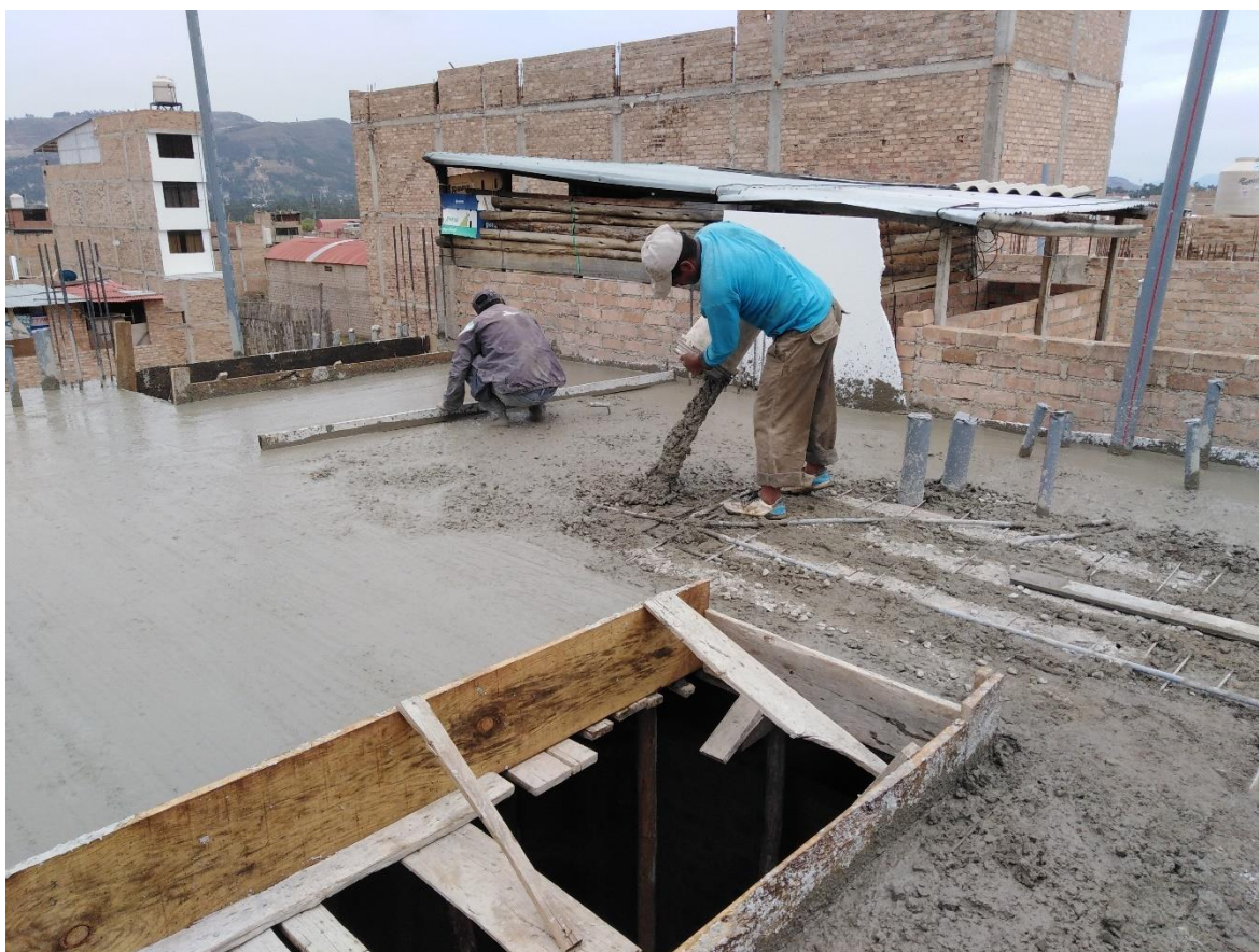
Figura 35. Vaciado de mezcla vivienda N° 3.
