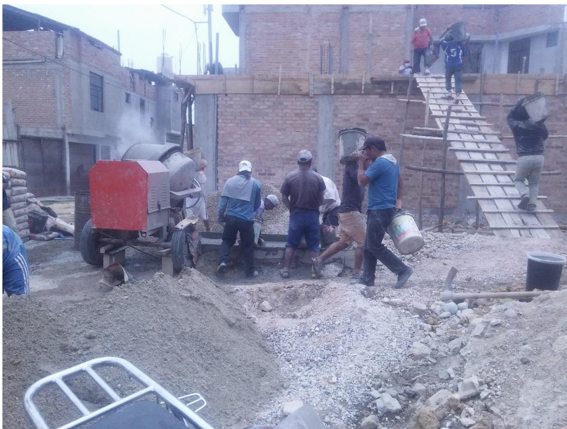
Figura 36. Preparación y traslado de mezcla vivienda N° 2.
