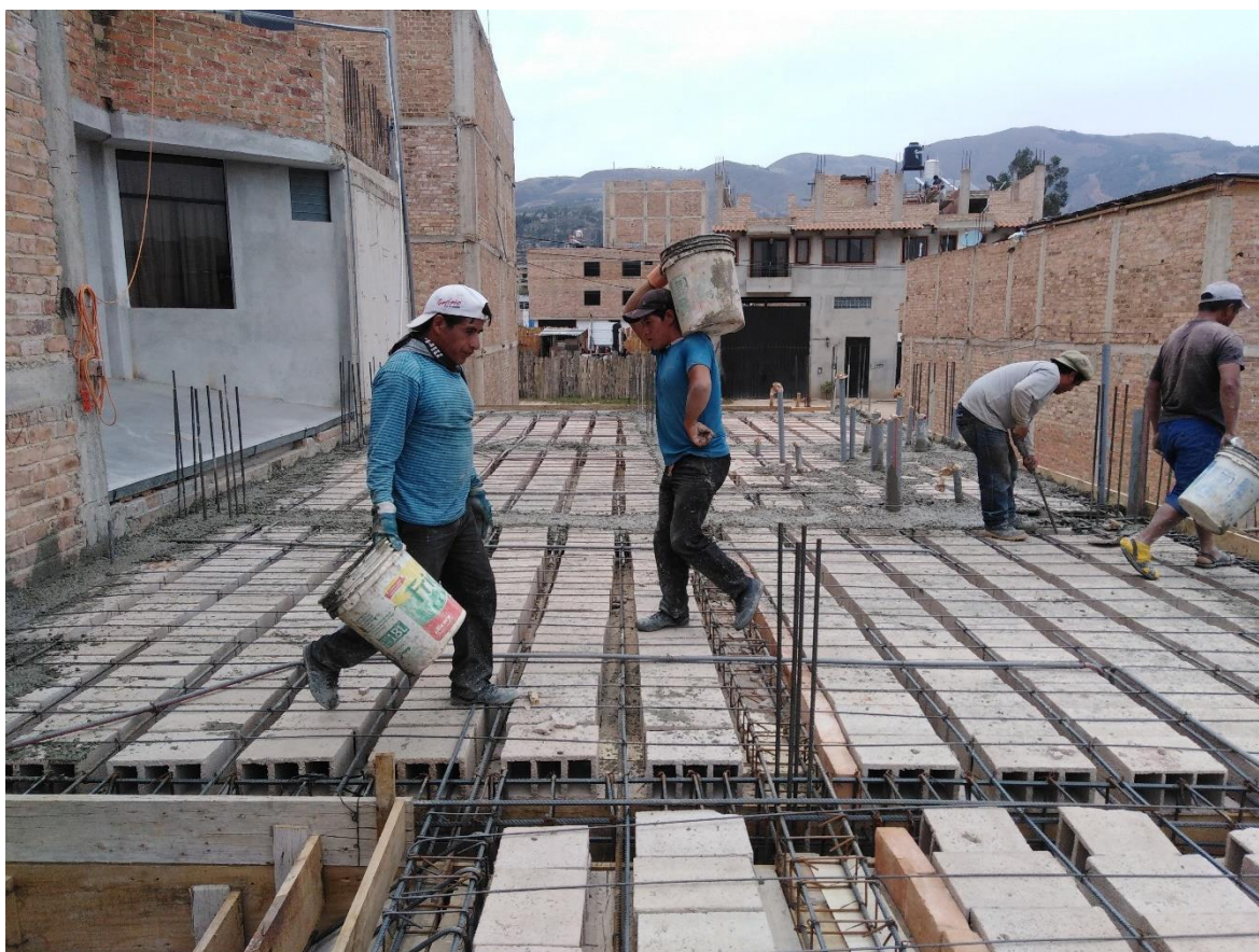
Figura 38. Vaciado de concreto en losa aligerada en la vivienda N° 3.
