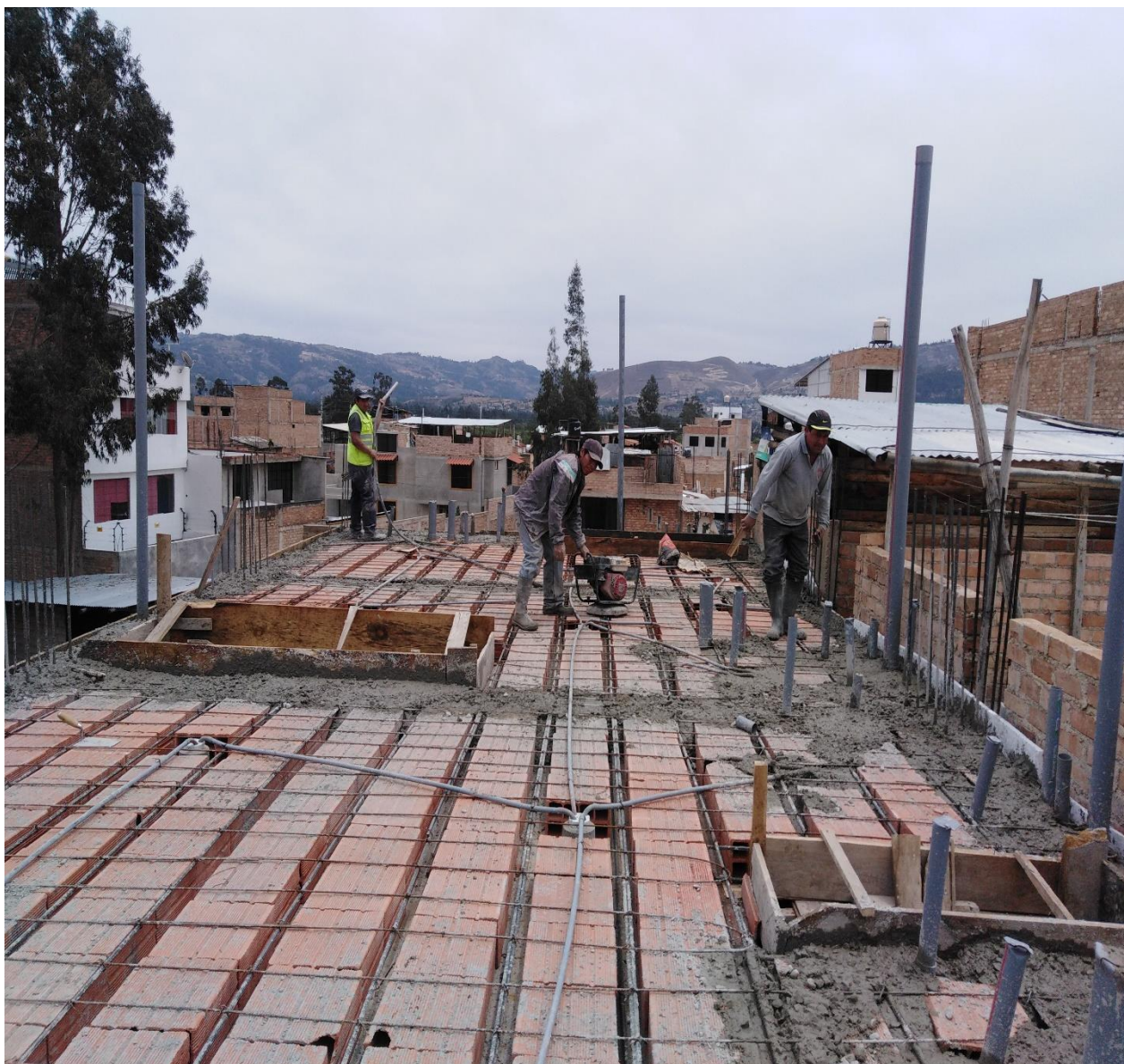
Figura 4. Se observa el vaciado de concreto en losa aligerada – Vivienda N° 01.
