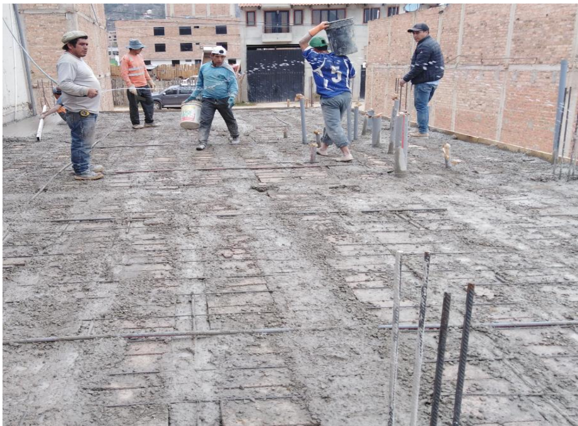
Figura 22. Se observa el vaciado de concreto en losa aligerada – Vivienda N° 03.
