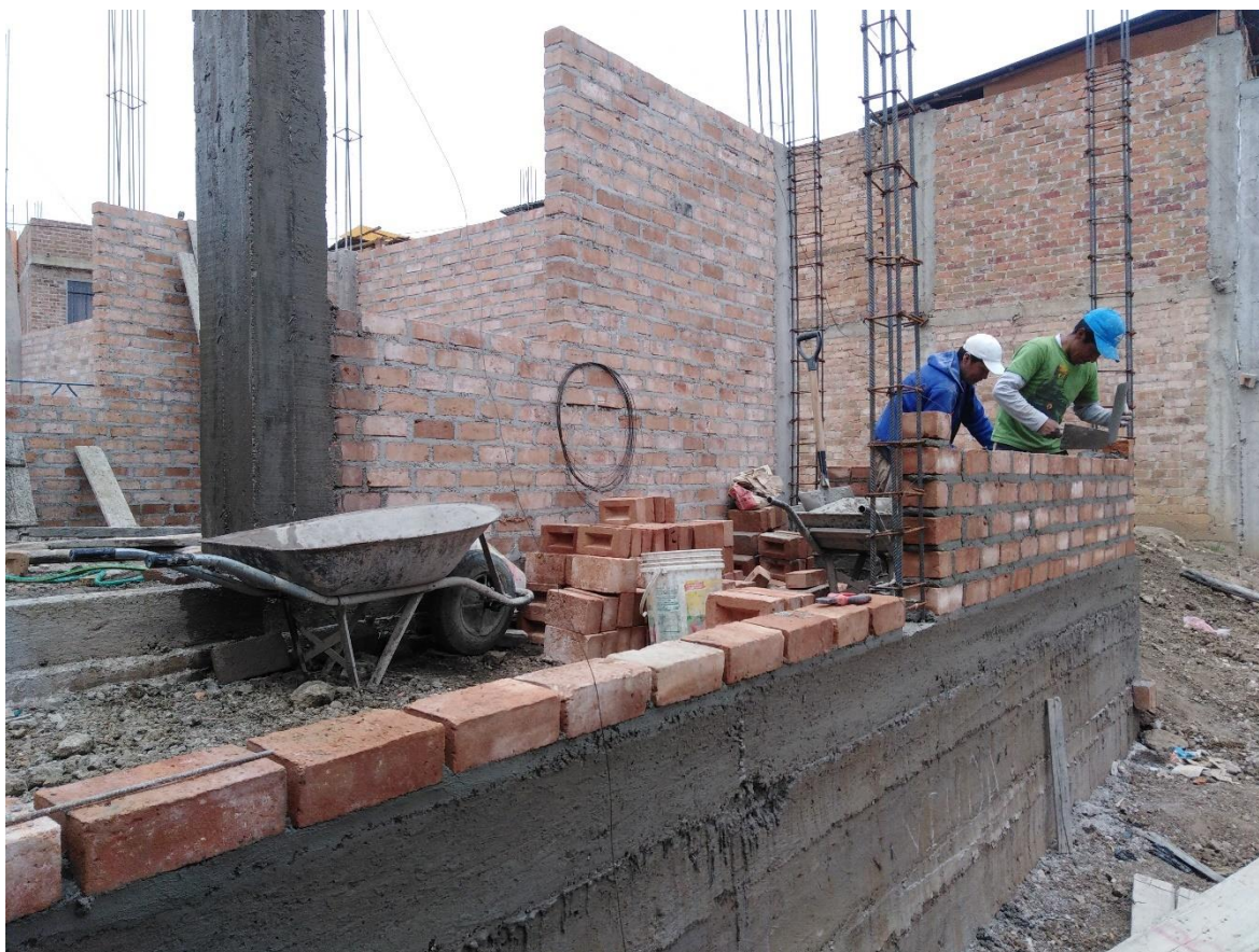
Figura 40. Plantillado de ladrillo vivienda N° 2.
