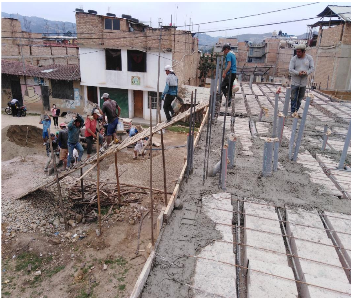
Figura 13. Se observa el vaciado de concreto en losa aligerada – Vivienda N° 02.
