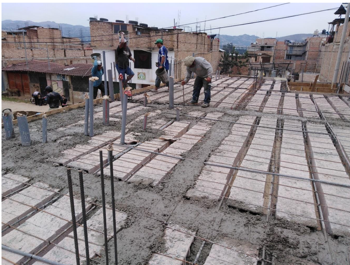
Figura 37. Traslado de mezcla y chuzado de concreto en la vivienda N° 3.
