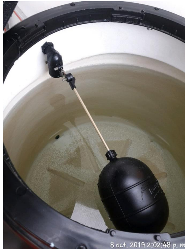
Figura 67. Interior del tanque con superficie limpia. El flotador funciona correctamente y la tapa hermética es segura. Correspondiente a la Sra. María Huamán – Mercado Modelo
