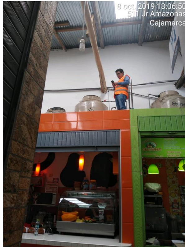
Figura 57. Inspección a los tanques de almacenamiento de agua correspondiente a los puestos de las Sras. Elizabeth Sánchez y Delia Cerdán. Se verifica espacio para la O&M.
