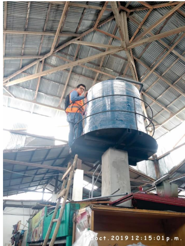
Figura 49. Inspección a la instalación del sistema de almacenamiento de agua, correspondiente al puesto 01 de la Sra. María Tafur Mosqueira – Mercado Central
