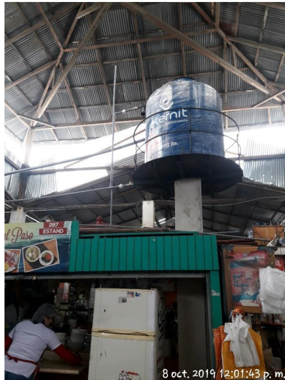
Figura 47. Ubicación de tanque elevado con adecuada área para la O&M, correspondiente al puesto 01 de la Sra. María Tafur Mosqueira –Mercado Central
