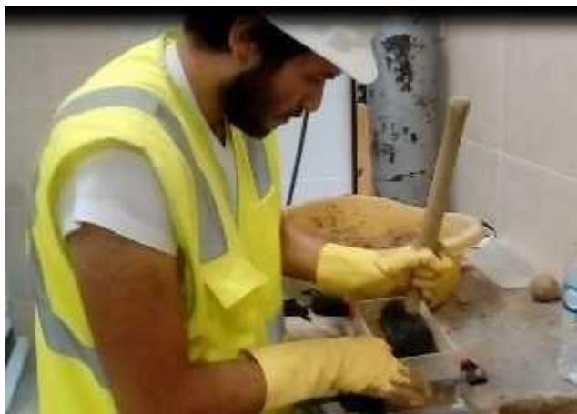
Figura 33: Compactado de la arena en 3 capas
