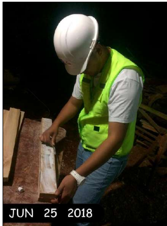
Fotografía 13. Encolado láminas de madera
