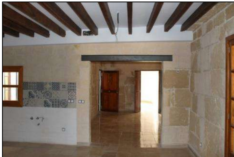
Fotografía 1. Vigas de madera en vivienda.
