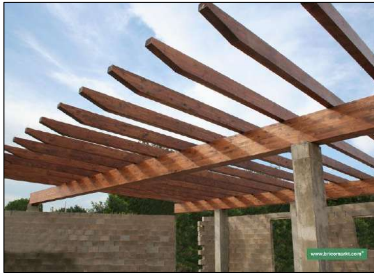
Fotografía 7. Vigas de madera laminada
