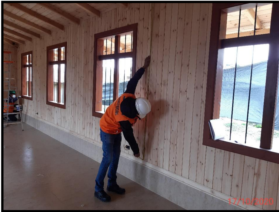
Fotografía 7: Verificando medidas de alturas del Módulo.
