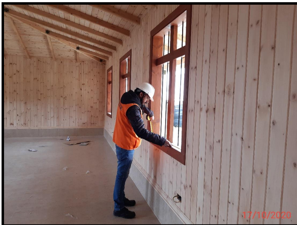
Fotografía 6: Verificando Medidas de marcos y ventanas.
