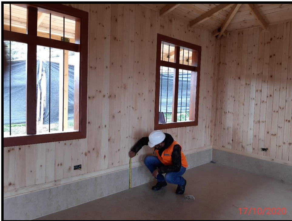
Fotografía 8: Verificando medidas del Sobrecimiento del Muros.
