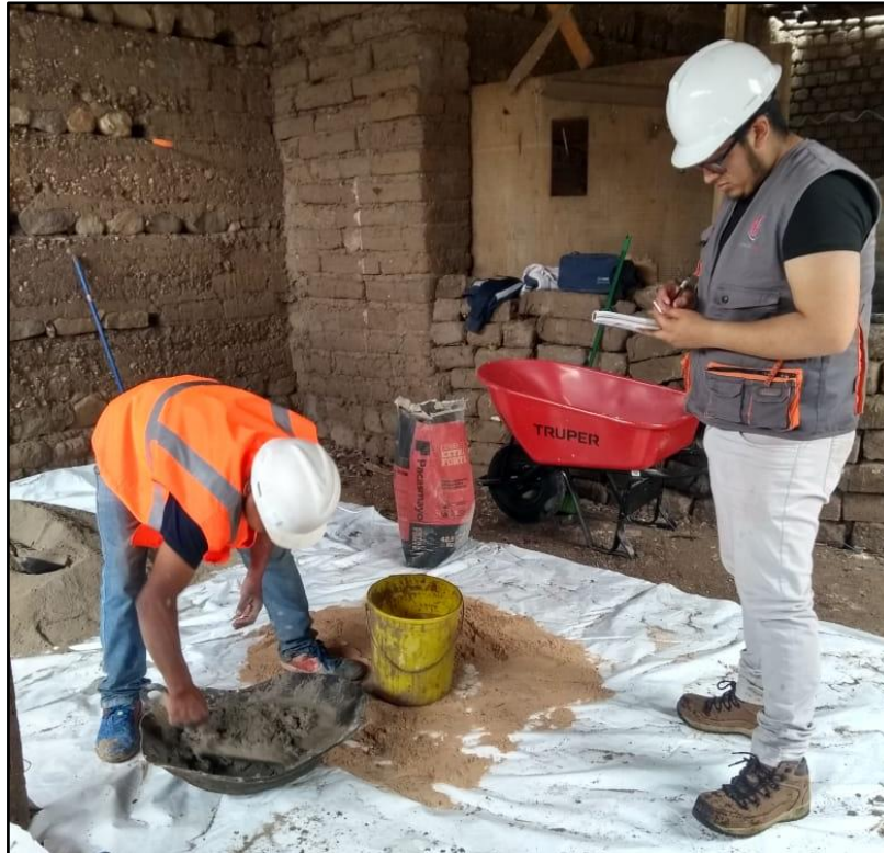
Fotografía 5: Mezclado de mortero.
