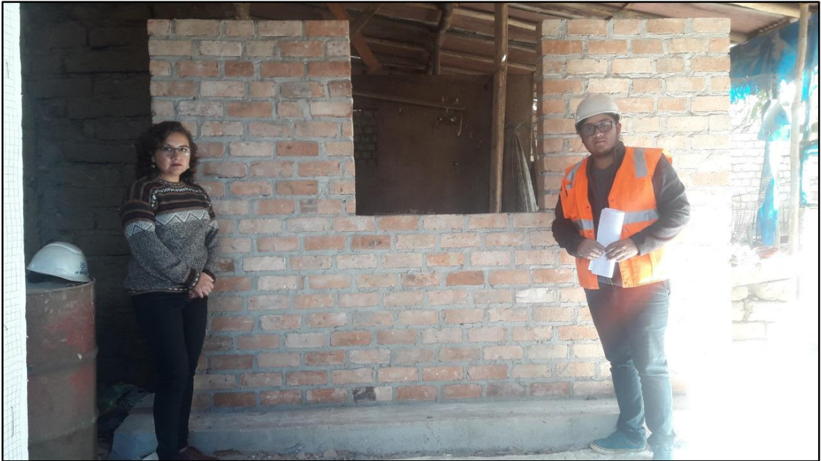
Fotografía 25: Supervisión de muro número 5.
