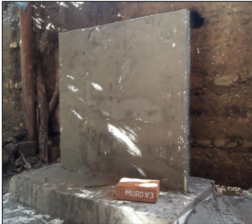
Fotografía 21: Termino de construcción del muro número 3.
