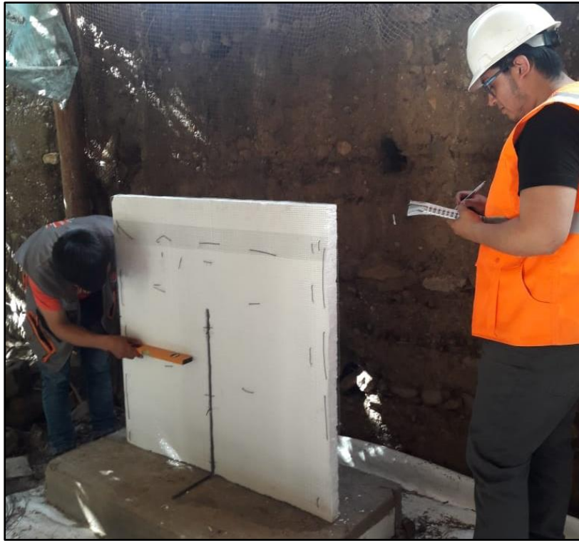
Fotografía 17: Verificación de verticalidad de muro número 3.
