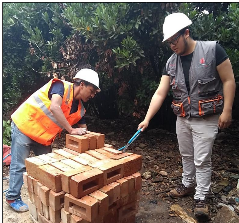
Fotografía 4: Hidratación de ladrillo de arcilla 2.
