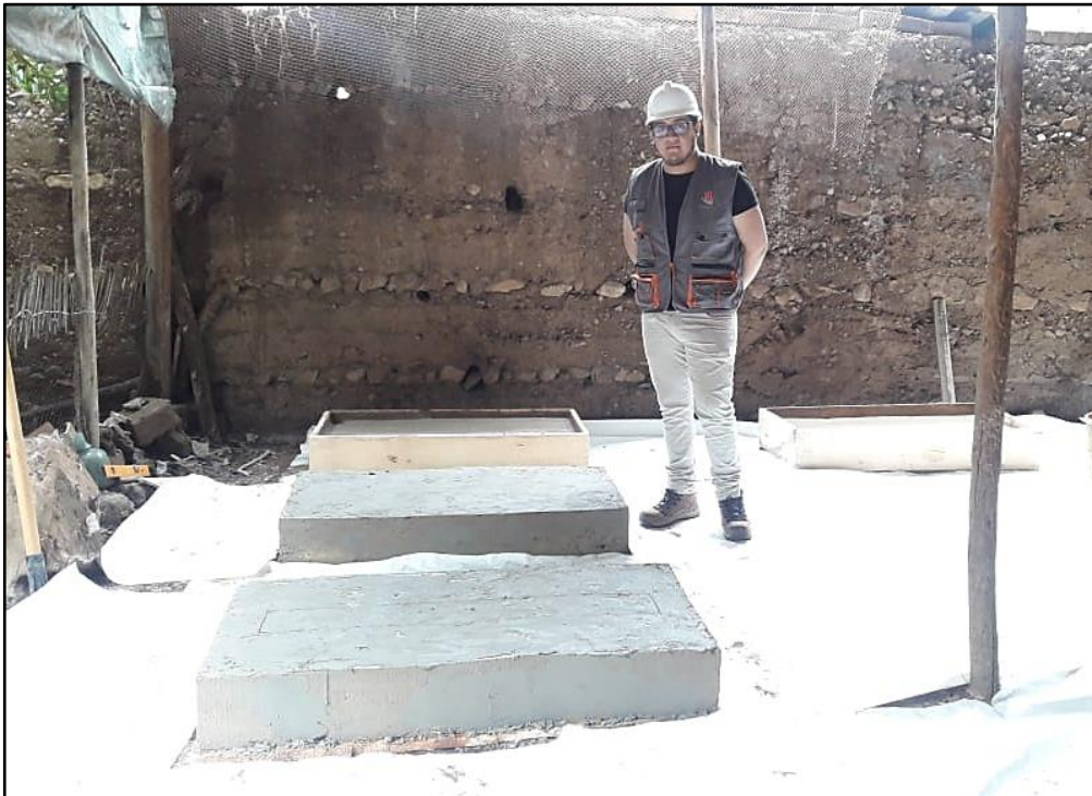
Fotografía 1: Culminación de las bases de construcción.
