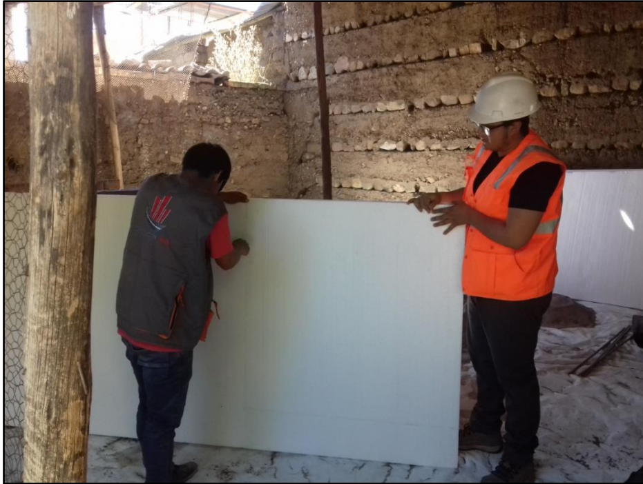
Fotografía 15: Corte de tecnopor de muro número 3.
