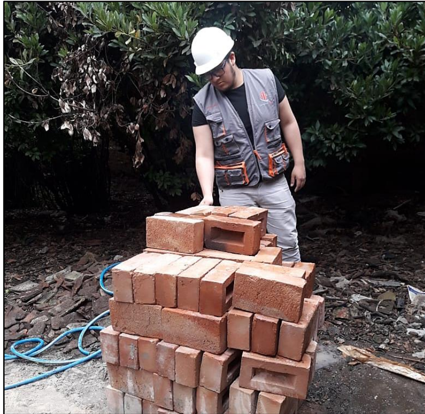
Fotografía 3: Hidratación de ladrillo de arcilla 1.
