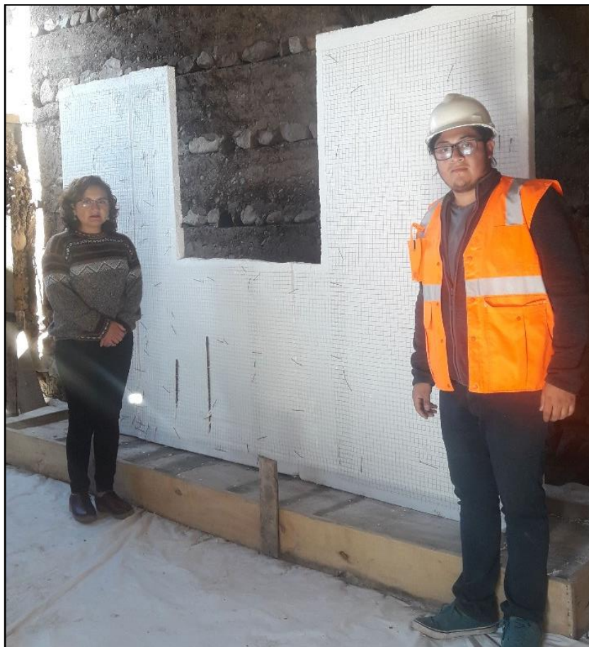
Fotografía 26: Supervisión de muro número 6.
