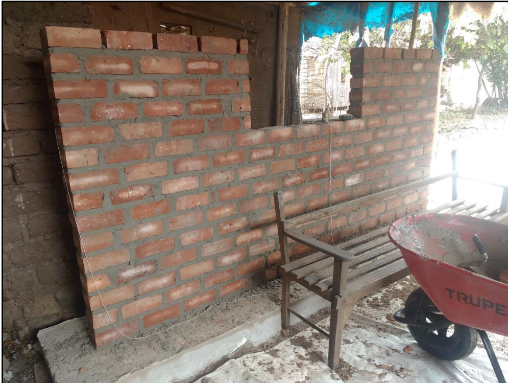
Fotografía 23: Construcción de muro número 5.
