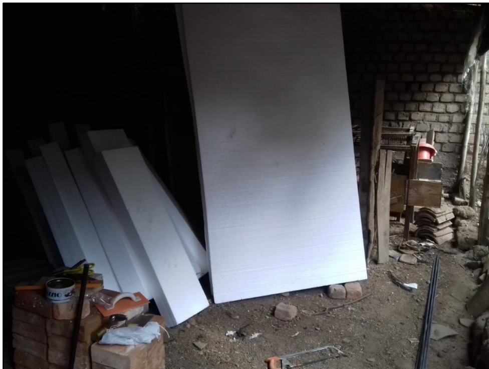
Fotografía 12: Almacenamiento de material.
