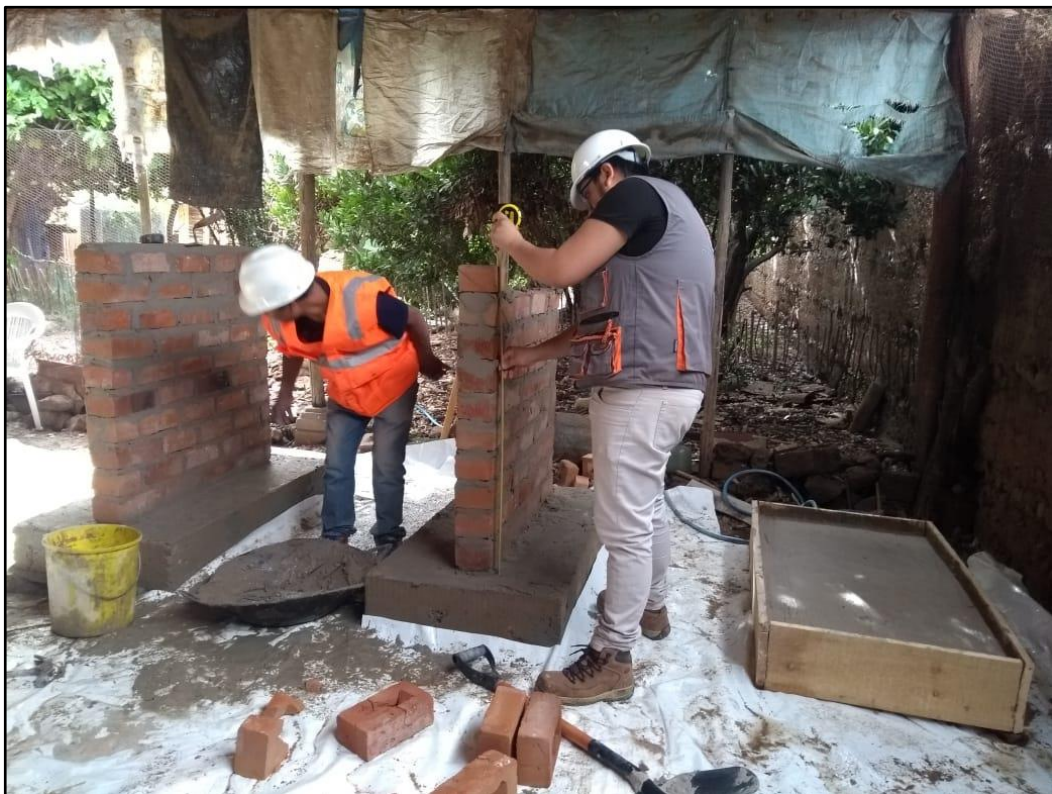
Fotografía 10: Medición de muro 2.
