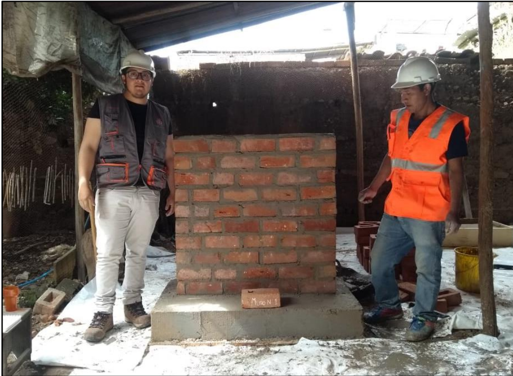
Fotografía 9: Termino de construcción del muro número 1.
