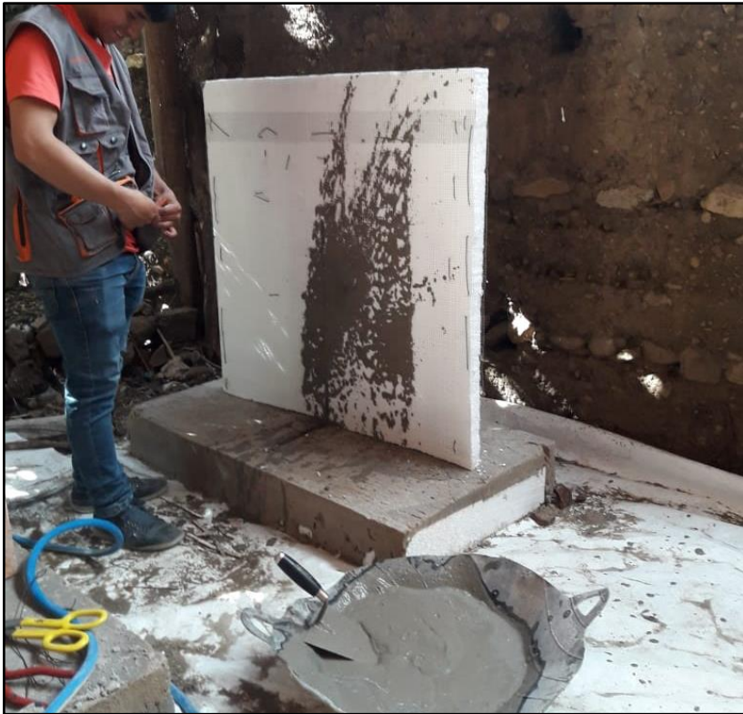
Fotografía 19: Chicoteo manual de la colocación de grout.
