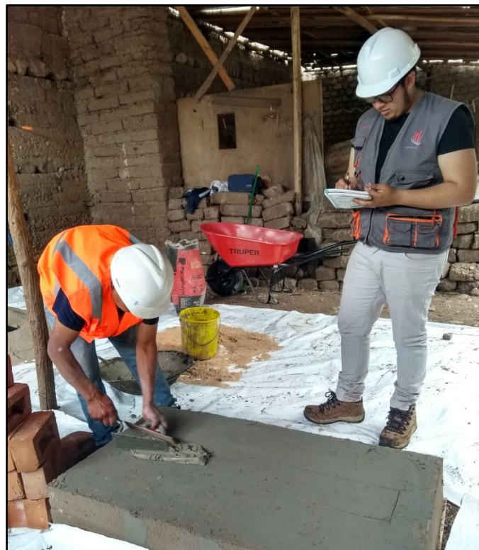
Fotografía 6: Inicio de construcción de muro 1.
