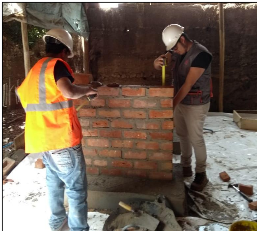
Fotografía 8: Medición de muro 1.
