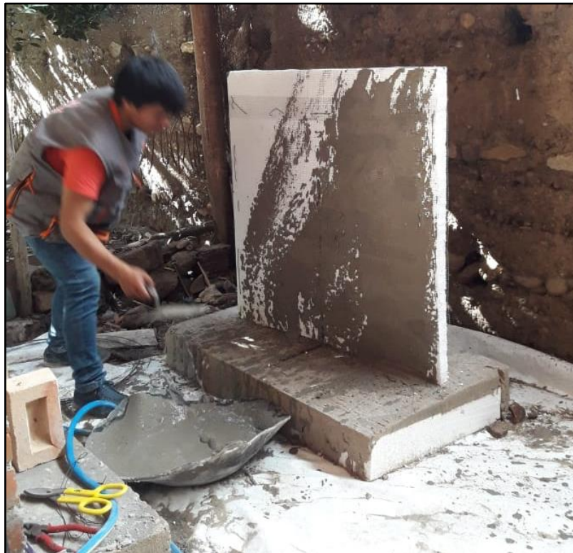
Fotografía 20: Colocación de concreto liquido en muro 3.
