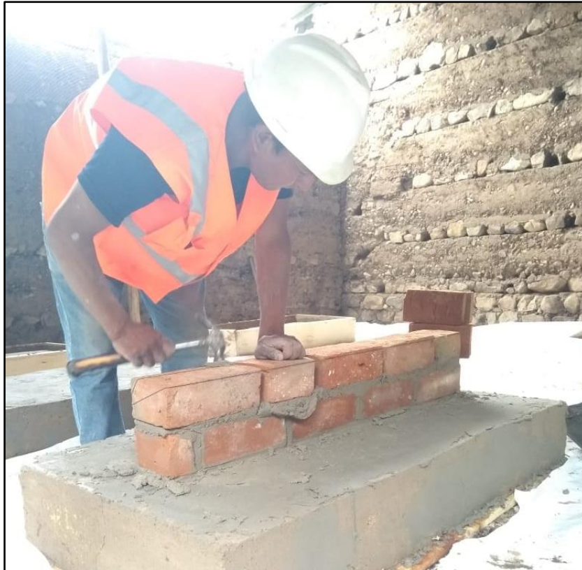
Fotografía 7: Proceso constructivo de muro 1.
