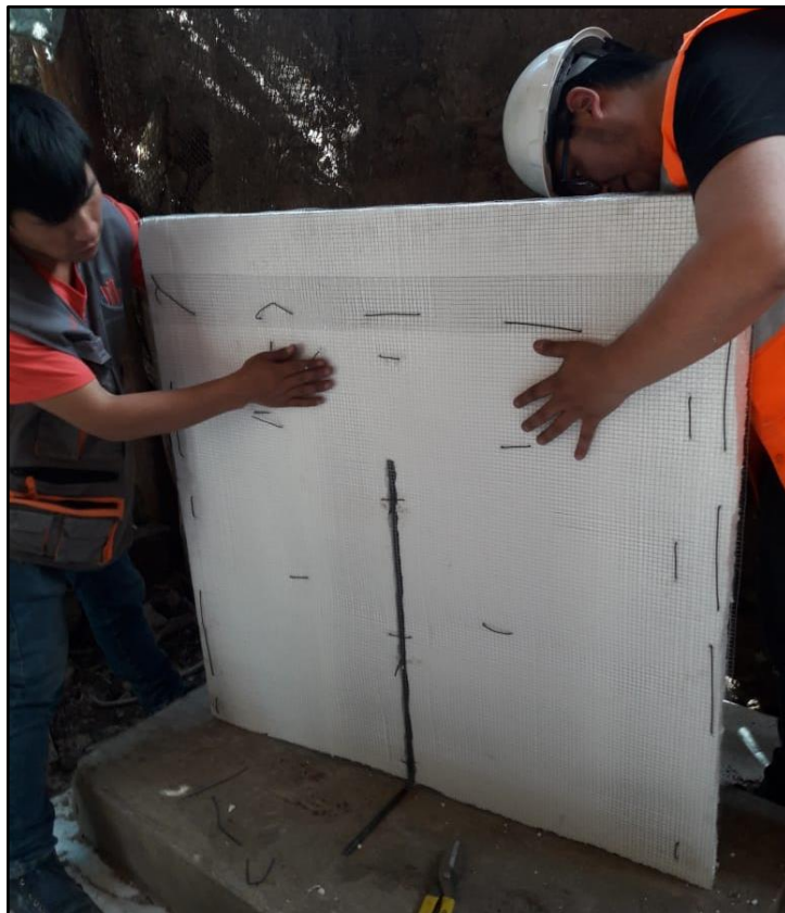
Fotografía 16: Fijación de primera placa teacon.
