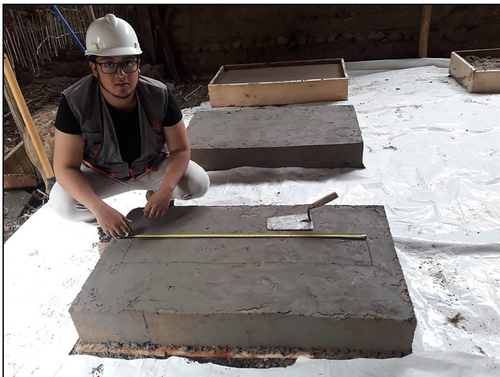
Fotografía 2: Delimitación de construcción.
