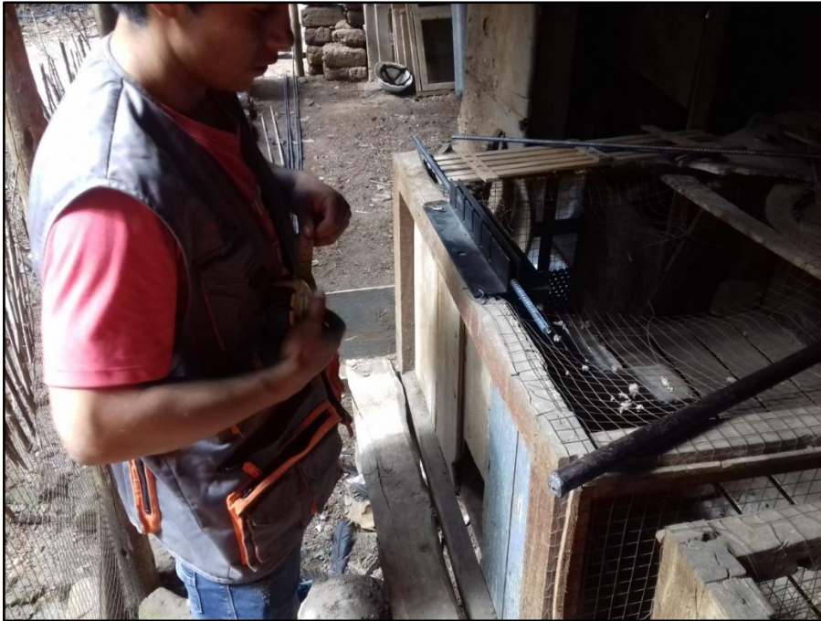
Fotografía 13: Habilidad de acero para muro número 3.
