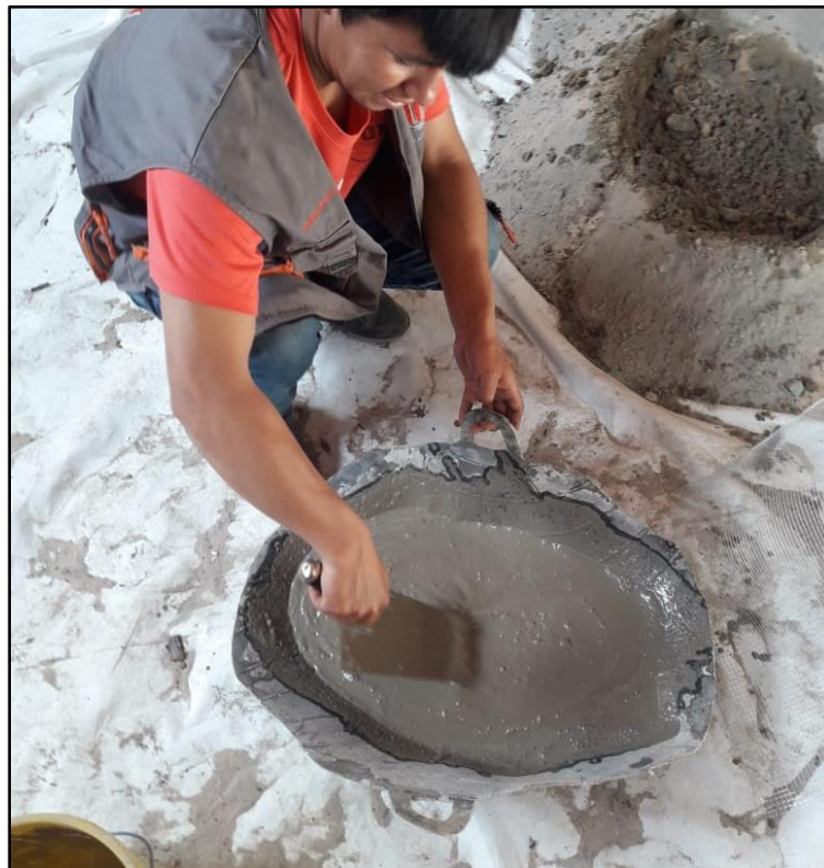
Fotografía 18: Mezclado de grout.
