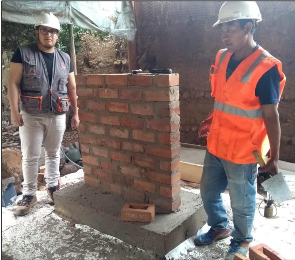
Fotografía 11: Termino de construcción del muro número 2.
