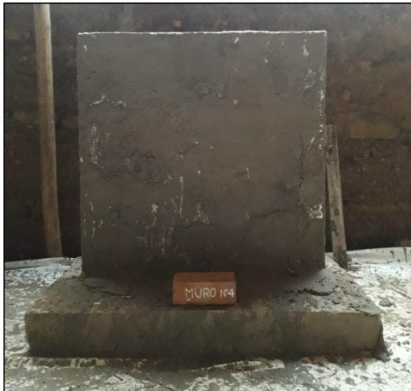
Fotografía 22: Termino de construcción del muro número 4.
