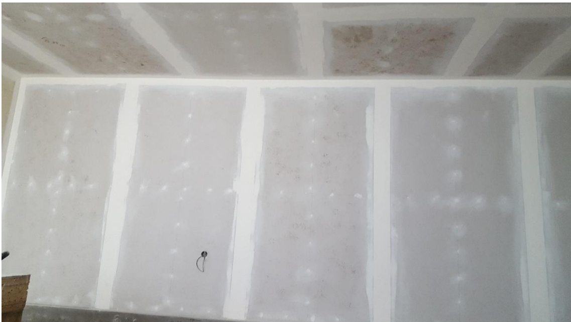
Figura 30 Avance de obra civil, Paredes y techo 19 de mayo de 2018
