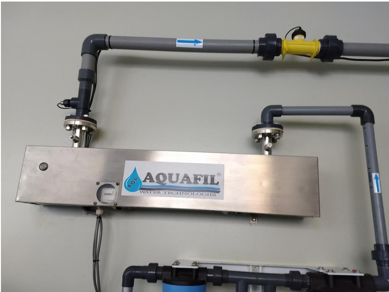
Figura 13 Lámpara ultravioleta de 10 GPM
