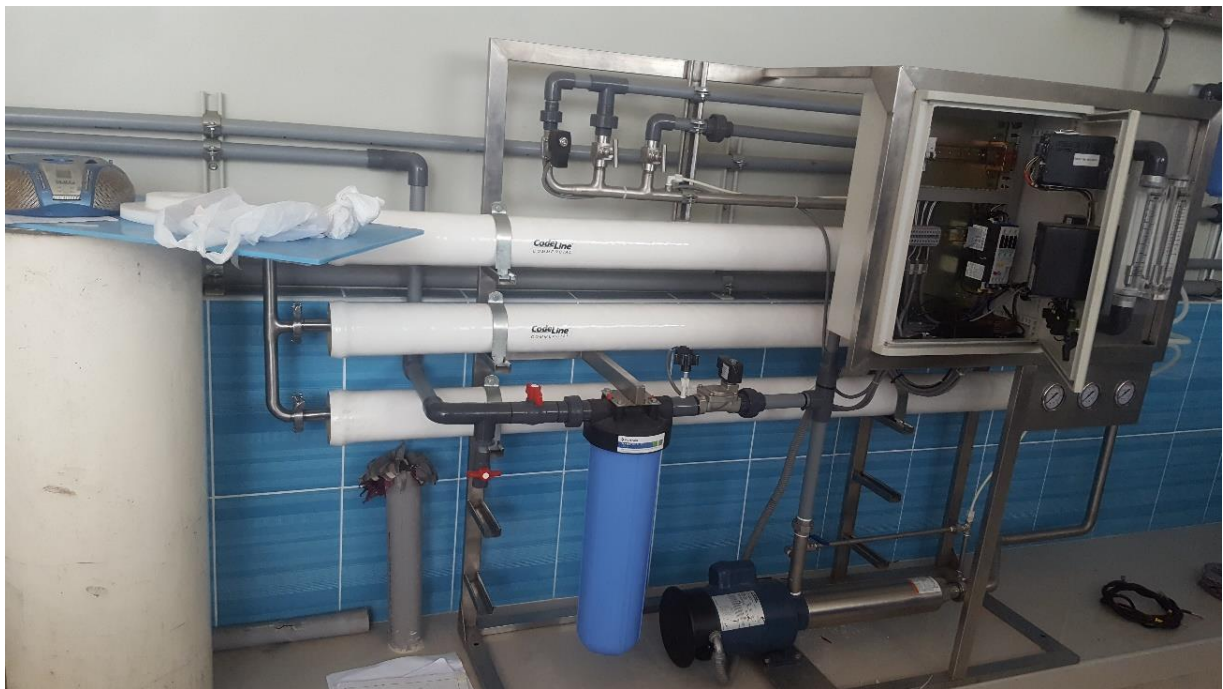
Figura 34 Instalación de tablero eléctrico de Osmosis Inversa
