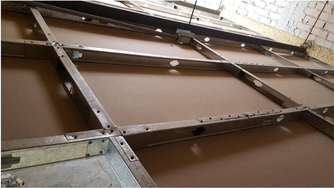
Figura 29 Inicio de Obra Civil 16 de mayo de 2018
