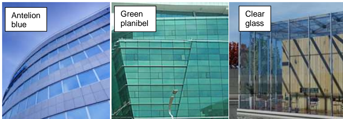
Figura n° 36: Aplicación de tipo de acristalamiento antelion blue, green planibel y clear glass.
