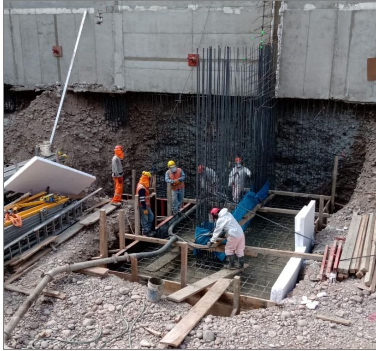
Figura 7. Montaje de Armadura obra "Proyecto Eres - Fase I". Fuente Ferralia Perú. Montaje de zapata y placa PI-A1; y muro pantalla del 5to anillo de la semana 37.
