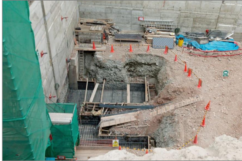
Figura 18. Obra: Multifamiliar Elant - Instalación del Refuerzo Inferior - Zapata - Sector C. Fuente Ferralia Perú.
