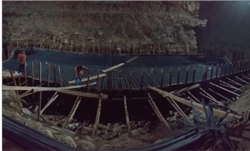
Figura 8. Montaje de armadura de la obra “Mejoramiento de los servicios de transitabilidad del Puente Esteban Pavletich, creación de los servicios de transitabilidad del Puente Circunvalación y Accesos en la Av. Colectora, distrito de Amarilis”. Montaje de zapata lado izquierdo correspondiente a la semana 1. Fuente Ferralia Perú
