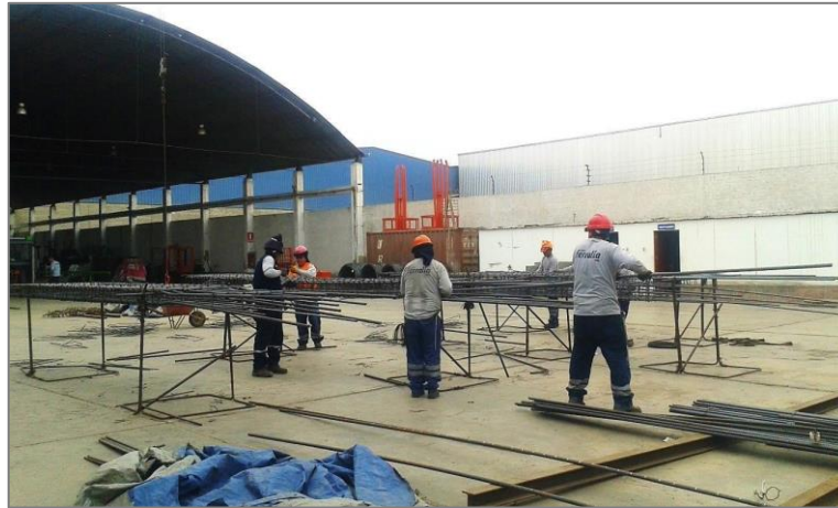
Figura 3. Área de armado en el taller Ferralia Perú. Fuente: Habilitación y colocación del acero-Ferralia Perú.
