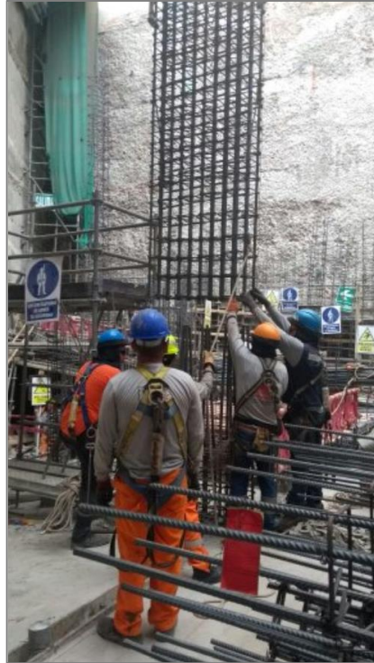
Figura 22. Izaje de Núcleo 1 -2 del sótano 2 (Armado). Fuente Ferralia Perú.
