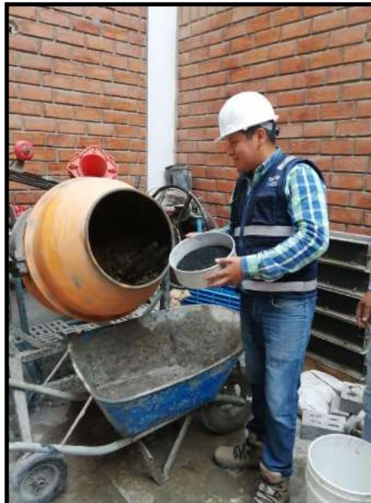
Fotografía N° 24: Vaciado de mezcla al bugguie.
