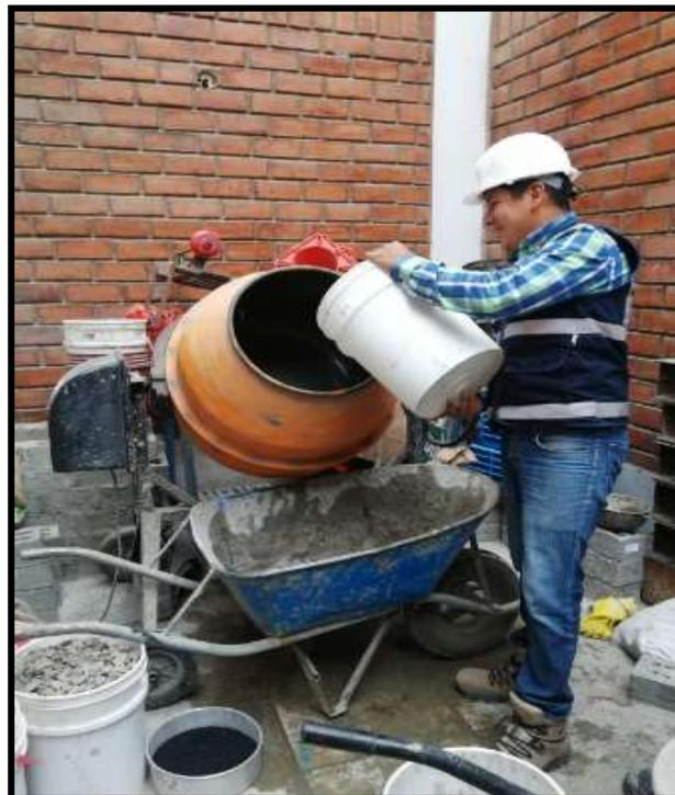
Fotografía N° 22: Preparación de la mezcla
