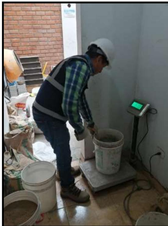
Fotografía N° 16: Pesaje de cantidad de caucho granulado según diseño.
