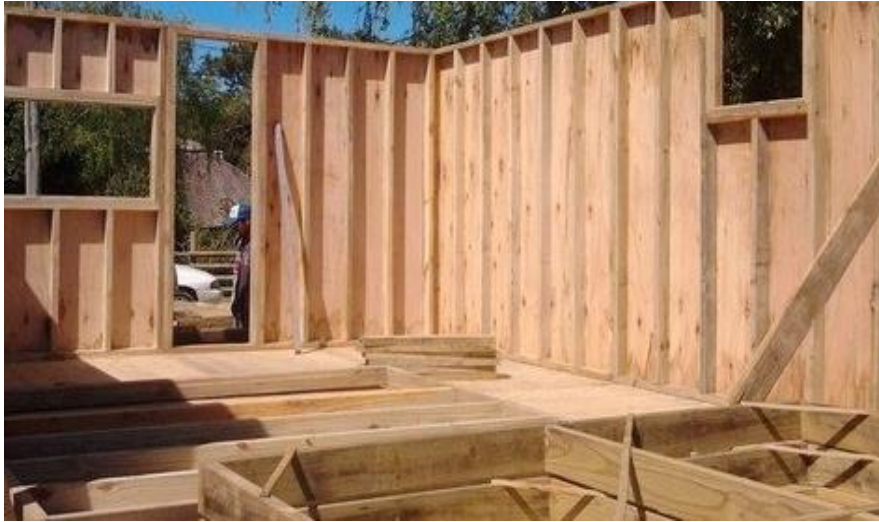
Figura 28: Tabiquería de soporte en la vivienda
