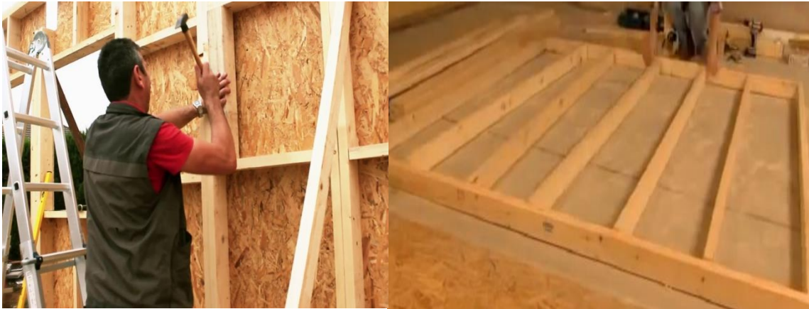
Figura 24 : Armado y montaje de los tabiques y uniones de los elementos.
