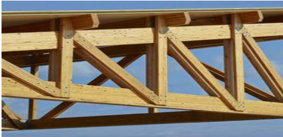
Figura 34 : Techo montado de vivienda.
