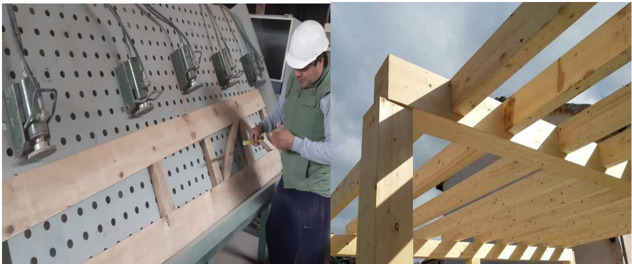
Figura 23 : verificacion de Tijerales de madera fabricados en taller y en obra
