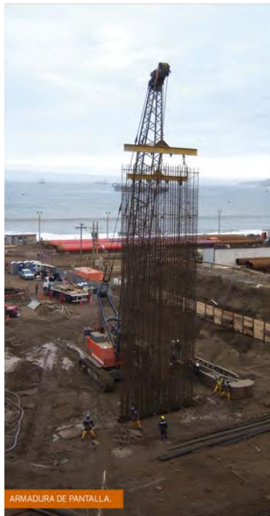
Figura 3: Instalación de jaula de armadura. Fuente: Pilotes Terratest Terra Foundations
