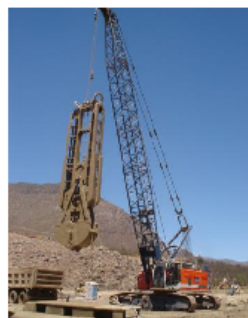
Figura 1: Cuchara para excavación de pantallas.
