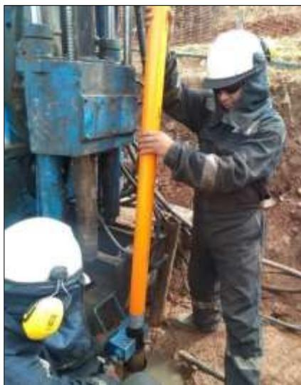
Figura N° 46 Introducción de tubería inclinométrica
