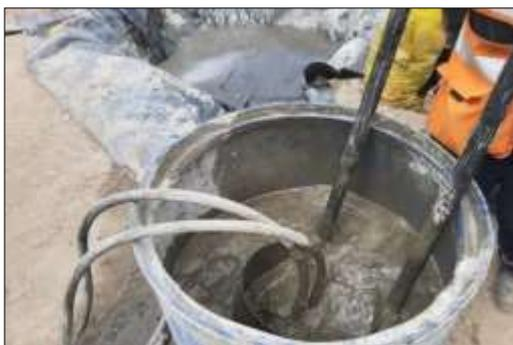
Figura N° 51 Dosificación de cemento más bentonita mezclado en el agitador
