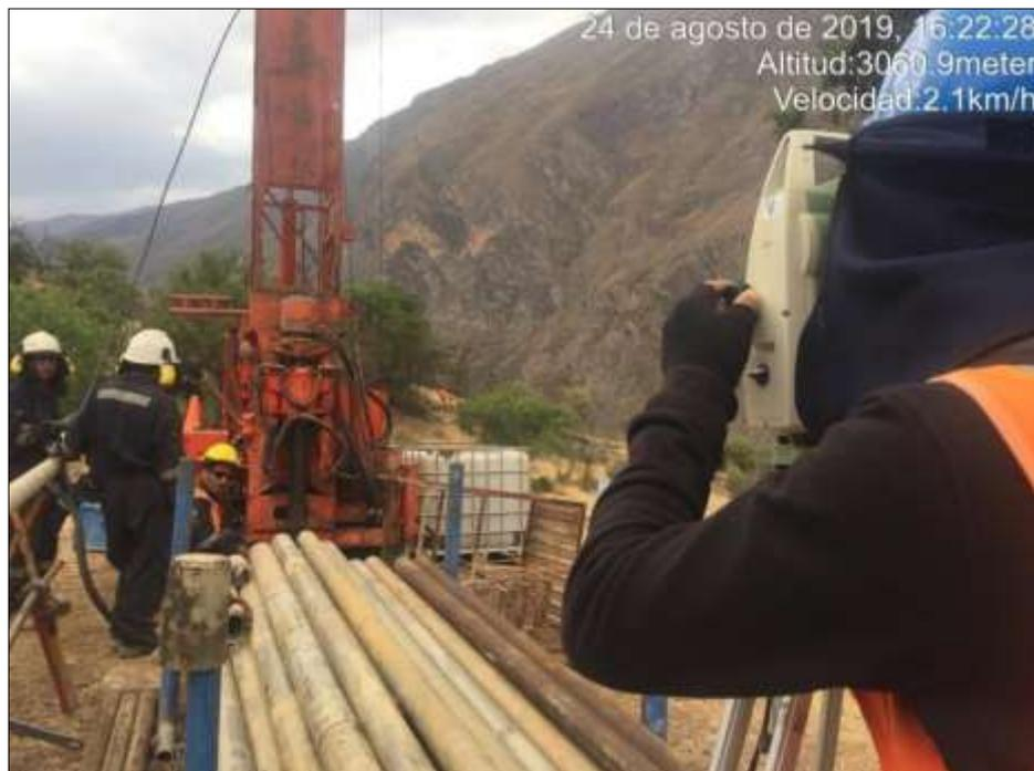
*Figura N° 29* Control Topográfico de verticalidad en la perforación para piezómetros de cuerda vibrante y en especial para inclinómetros verticales
