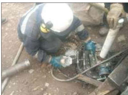
*Figura N° 42* Vertido de bentonita granulada
