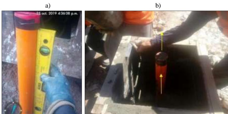
Figura N° 53 Verifica verticalidad y orientación al termino de inyección y construcción de caja de protección.
