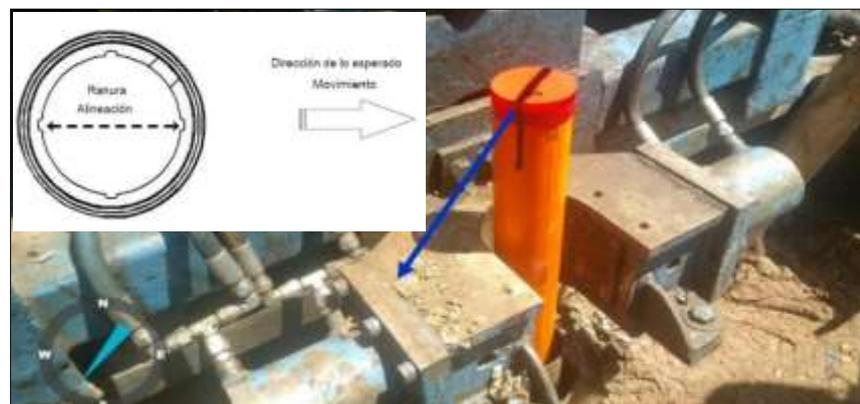
Figura N° 50 Ranuras orientadas y tubería centrada
