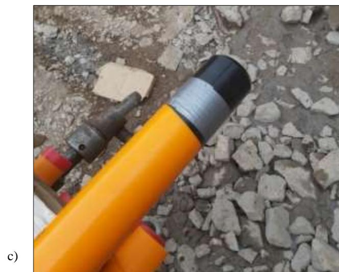
Figura N° 44 a), b) y c) Colocación de tapa de fondo de tubería inclinométrica
