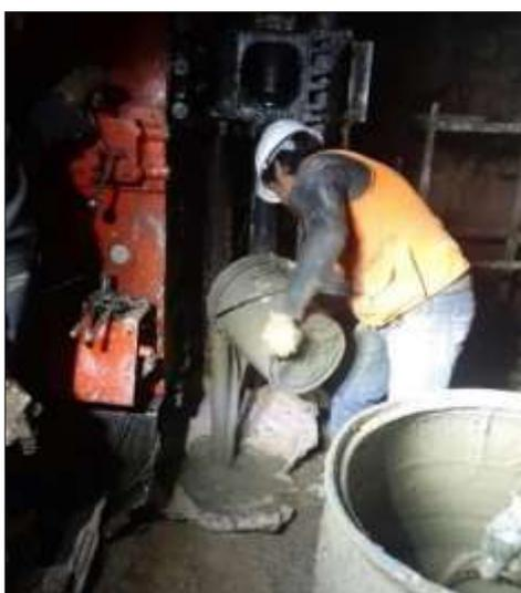
Figura N° 52 Se debe verificar siempre que la tubería inclinométrica se encuentre centrada y con la lechada cemento-agua bentonita hasta el nivel de superficie.
