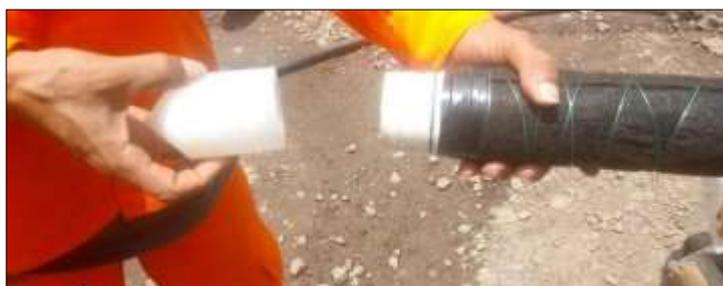
Figura N° 40 Tubería ranurada con geotextil y tapa de fondo
