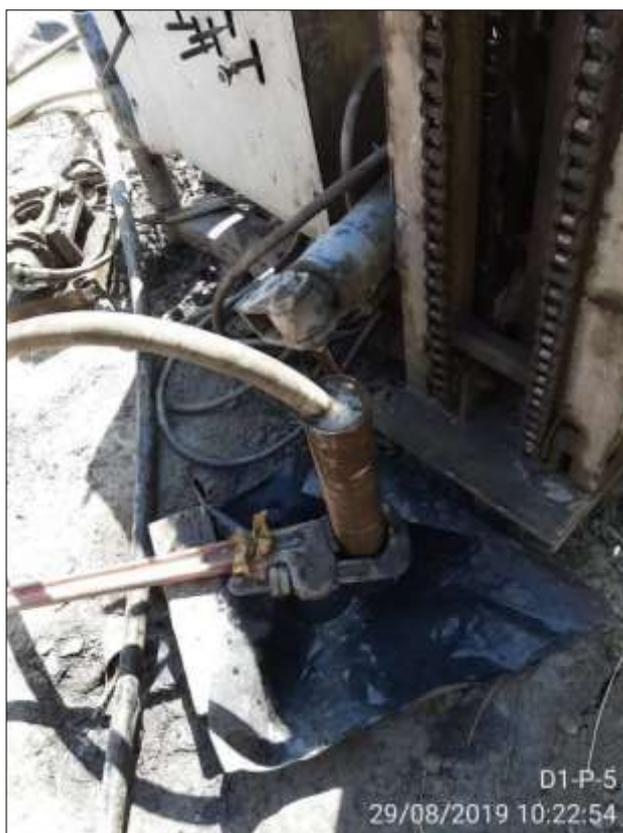
Figura N° 32 Llenando de agua al interior de tubería de casing de acero en pozo perforado
