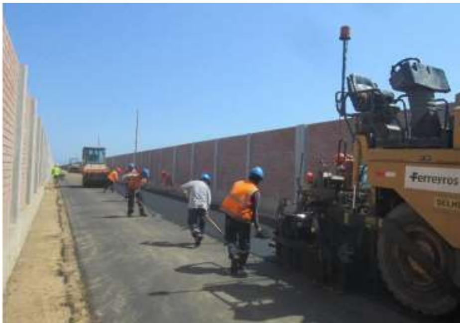
**Figura n.º 78.** Cerco perimetral y pavimentación en vía de acceso Senasa-Oporsa (fotografía propia.)
