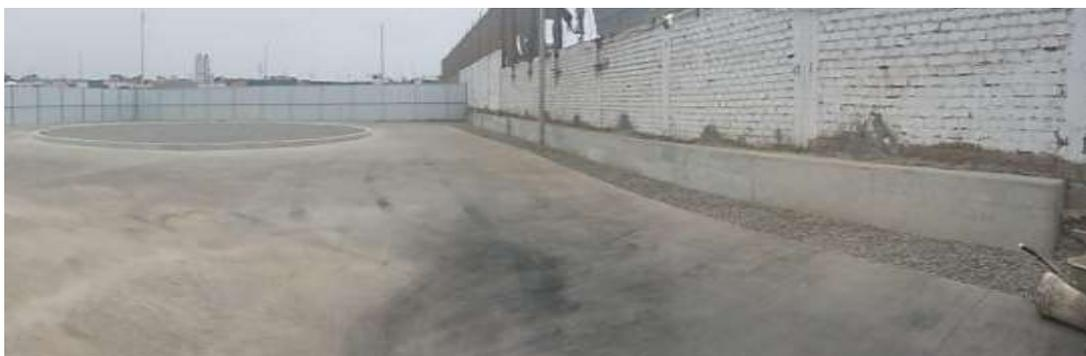
**Figura n.º 83.** Construcción de calzada y sardinel en patio de maniobra - Lima Hub (fotografía propia).
