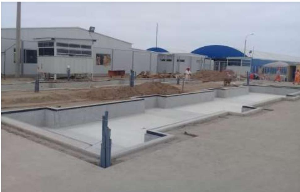
*Figura n.º 80.* Construcción de balanza vehicular-almacén Senasa (fotografía propia).
