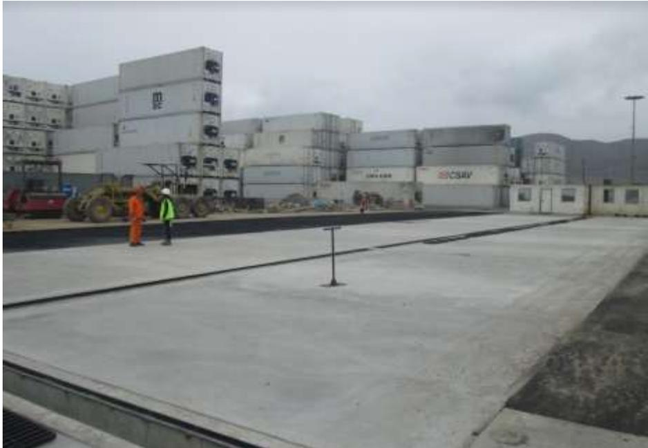
*Figura n.º 79.* Construcción de canaleta y obras complementarias–almacén Ex Oceánica (fotografía propia).
