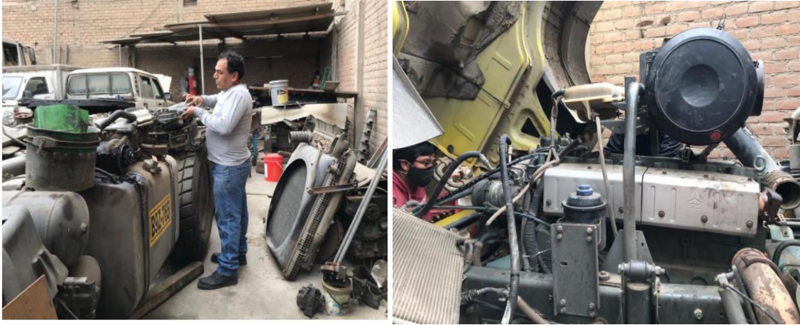
Figura 5 Desarrollo de los trabajos de mantenimiento preventivo
