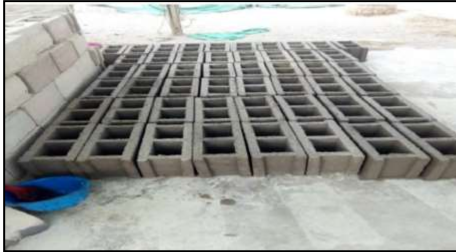
Figura 33: Proceso de fraguado de los bloques de concreto elaborados
