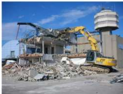
Figura 1: Residuos de demolición
