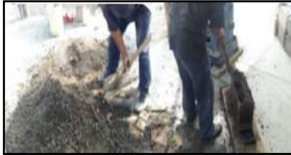
Figura 30. Proceso de integrado de materiales en seco.
