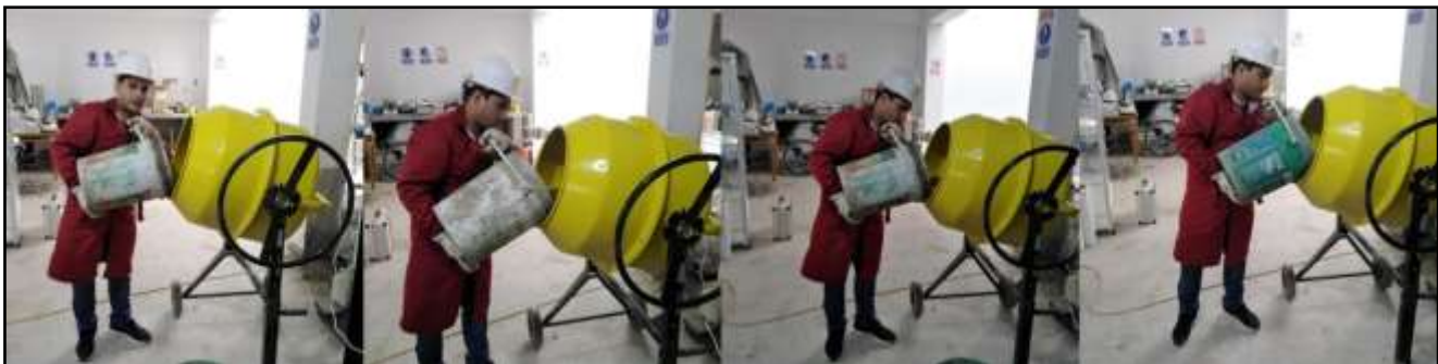
Figura 31. Incorporación de agua, arena, cemento y piedra para la mezcla
