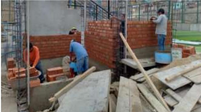
Posterior a la partida de sobre cimientos, se ejecuta el levantamiento de muros de ladrillo, con el fin de encofrar las columnas y posteriormente llenarlas.
