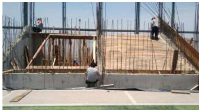
Posteriormente a los trabajos de zapatas, columnas, placas y vigas; realizamos el encofrado de la gradería respetando lo detallado en los planos del expediente técnico.
