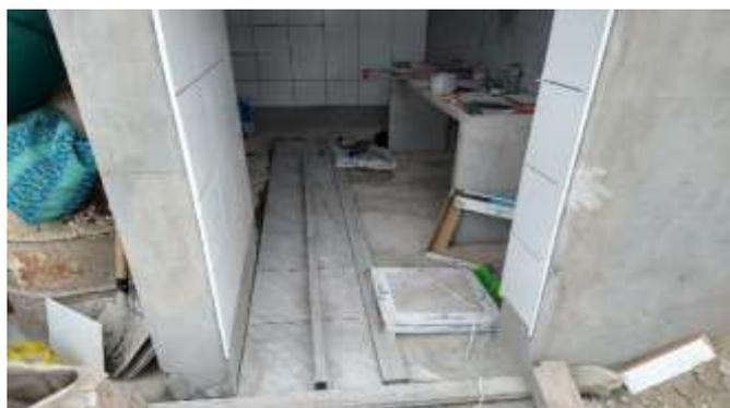
Se realizó la colocación de las cerámicas, verificando las dimensiones y colores para cada tipo de cerámica a colocar.
