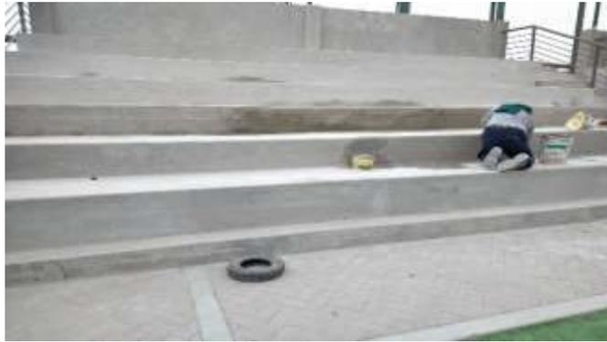
Se realizaron los acabados en la gradería, posteriormente a la construcción de los parapetos en las mismas, comenzamos con el solaqueo en las gradas para la próxima colocación de sus respectivos asientos.
