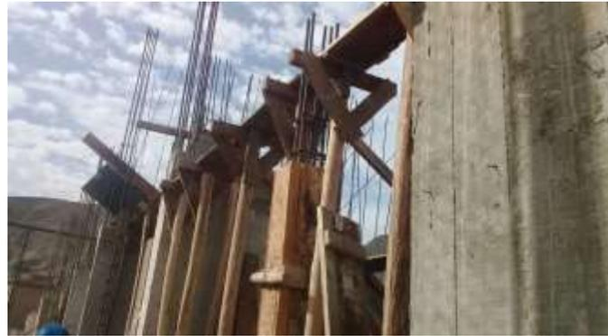
Realizamos la ejecución de la partida mencionada con la finalidad de encofrar las vigas de las tribunas, realizando el curado del concreto respectivo.
