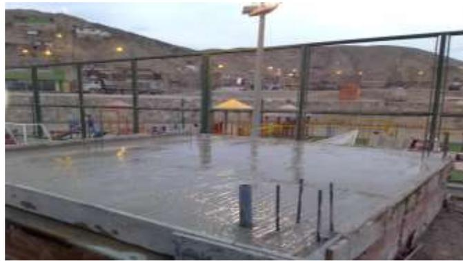
Se ejecutó la partida respetando los detalles de amarre en losa pertenecientes al expediente técnico de adicional de obra N°01, realizamos los trabajos con concreto  $f'c = 210 \text{ kg/cm}^2$ .
