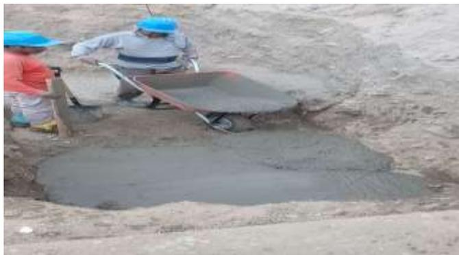
Posterior a la excavación manual, se realiza la colocación del solado  $f'c=100 \text{ kg/cm}^2$ ,  $e=0.10 \text{ m}$ , con el fin de nivelar la superficie, asegurando una buena adherencia con el piso definitivo.
