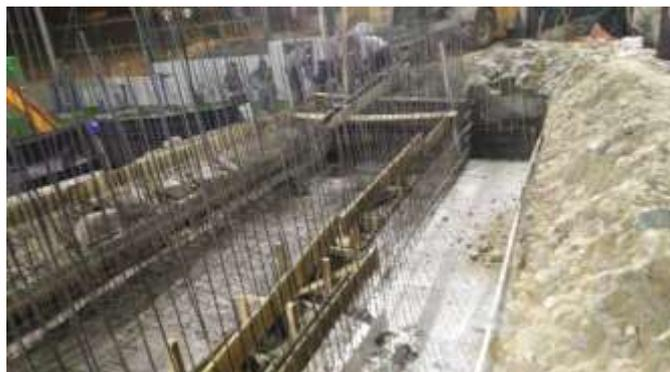
Se colocan los fierros debidamente detallados en los planos del expediente técnico de obra.
