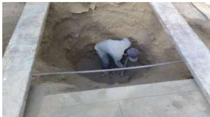
Realizamos la excavación previa a la colocación del biodigestor, dejamos los accesos de entrada de agua, como la salida de desechos.
