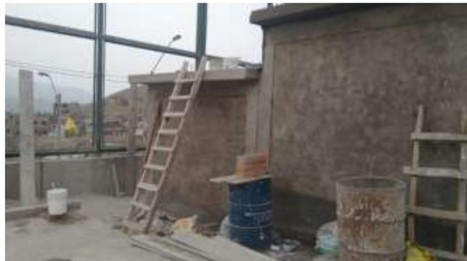
Se tarrajeo en muros interiores y exteriores con su respectivo bruñado, en columnas, en vigas y en derrame.
