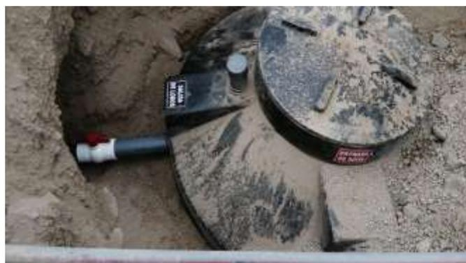
Realizamos la colocación del biodigestor, a su vez, revisando su funcionamiento.
