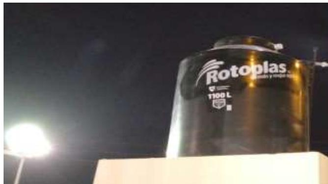
Culminando con los trabajos de pintura en la caseta construida, procedemos a colocar el tanque elevado.
