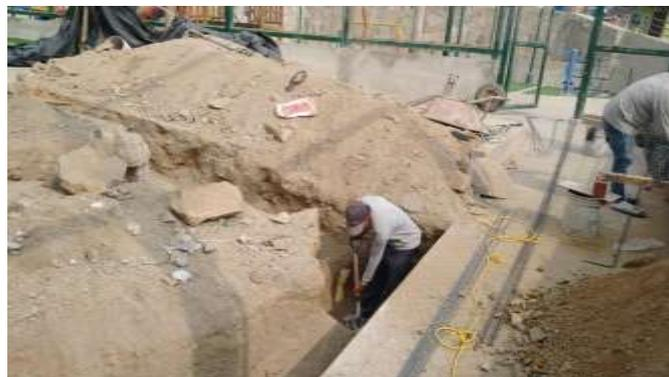
Posterior al trazado preliminar, procedemos a la excavación manual para los cimientos de las casetas a ejecutar.
