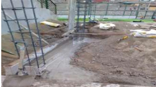
Se ejecutaron las partidas de concreto simple, posterior a ello, y previa colocación de los fierros en zapatas y columnas, se procede al llenado de concreto en zapatas.
