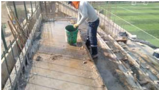
Se realiza el curado de las gradas, haciendo posas de agua con arena para alcanzar la resistencia óptima y evitar las patologías.
