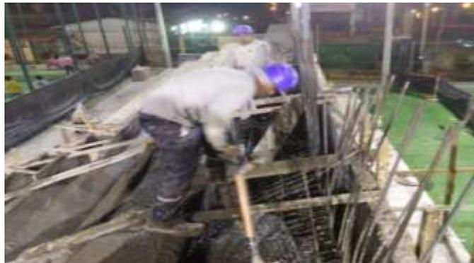
Se procede al llenado de gradas tomando los testigos respectivos para someterlos a ensayos de compresión.
