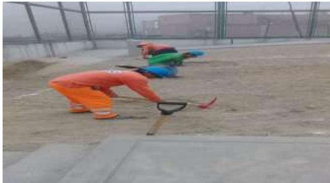
Posterior al trazo y replanteo de la obra, se realiza la excavación manual con el fin de dar una capa de falso piso de concreto, para continuar con la cimentación.
