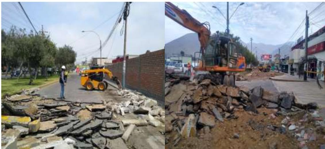
En la actualidad soy parte del equipo de residencia en los trabajos de pavimentación en la Avenida la Molina, se adjunta las fotografías de corte y demolición que se vienen ejecutando momentáneamente.
