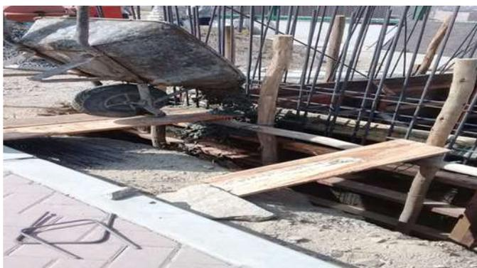
Se realiza el llenado por niveles tomando los testigos para su próxima rotura con fines de verificar la resistencia del concreto.
