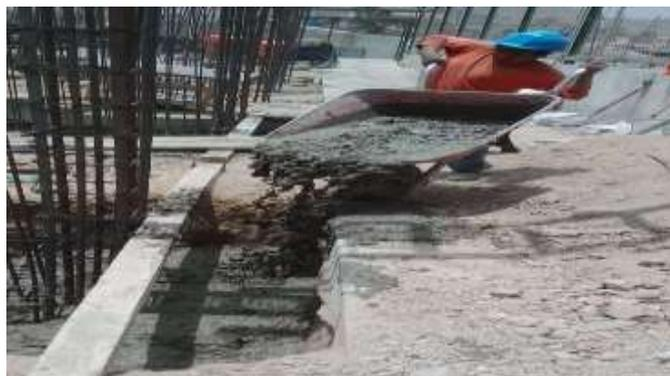
Debido al poco acceso para poder recibir la mezcla de concreto, el personal transportaba el material con carretilla, siendo un factor que nos retrasaba al momento de hacer los trabajos con concreto.
