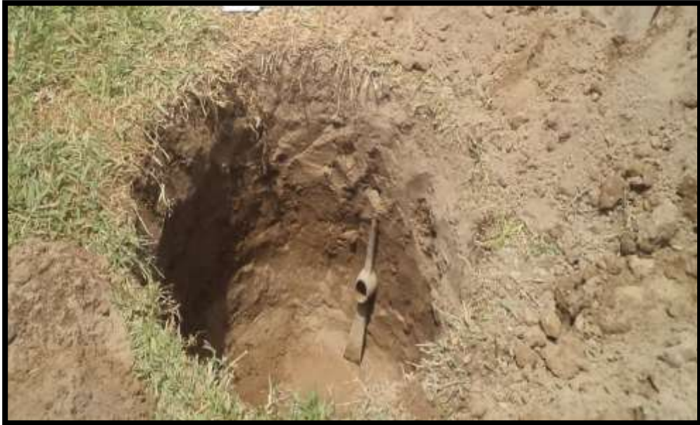
Vista panorámica de la calicata a analizar
