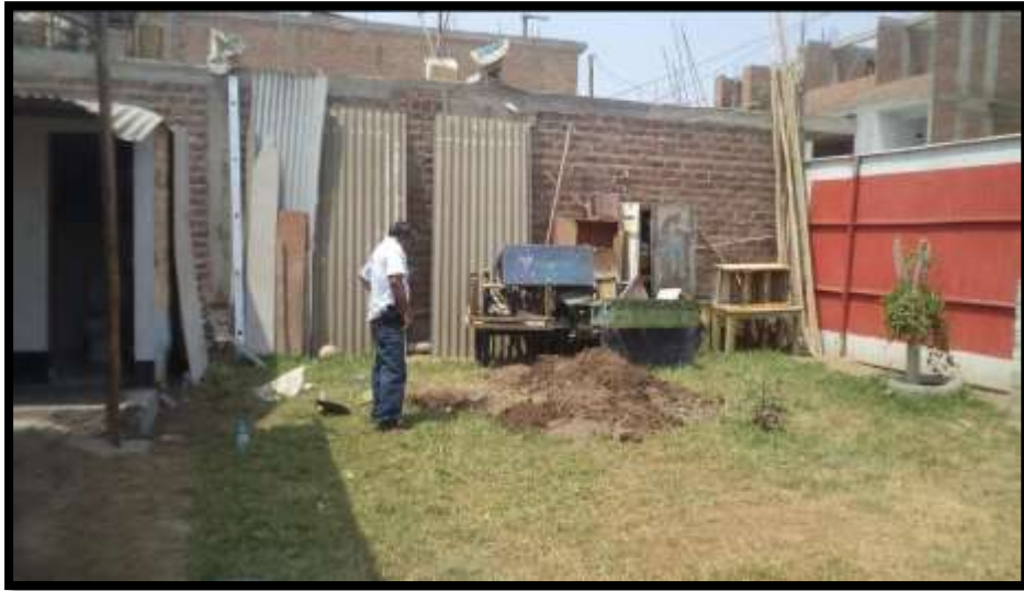
Figura 16. Calicata al interior de un terreno
