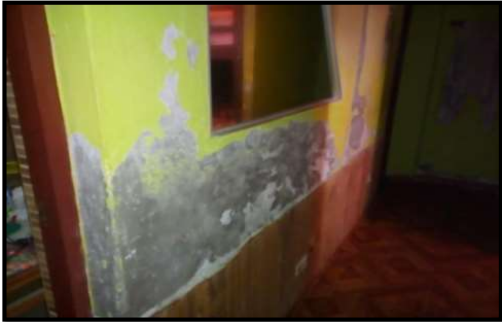
Figura 34. Visualización del interior de la vivienda
