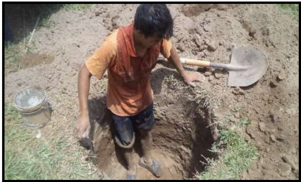
Figura 15. Excavación de la calicata
