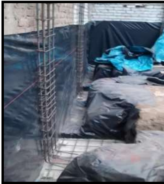
Figura 23. Foto de polietileno colocado en Urb. La Floresta – Los Olivos.
