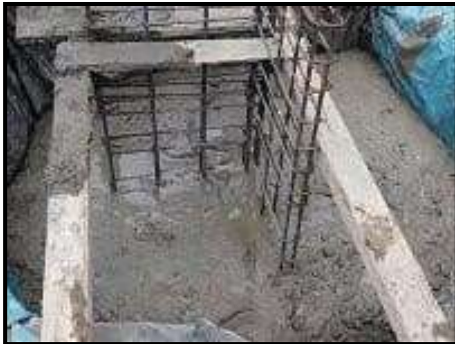
Cimiento vaciado y protegido con polietileno en Urb. La Floresta – Los Olivos
