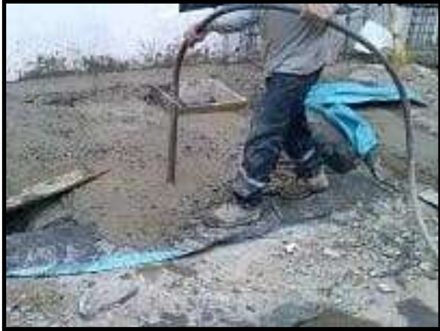
Vaciado y vibrado de concreto para cimientos protegidos con polietileno en Urb.
