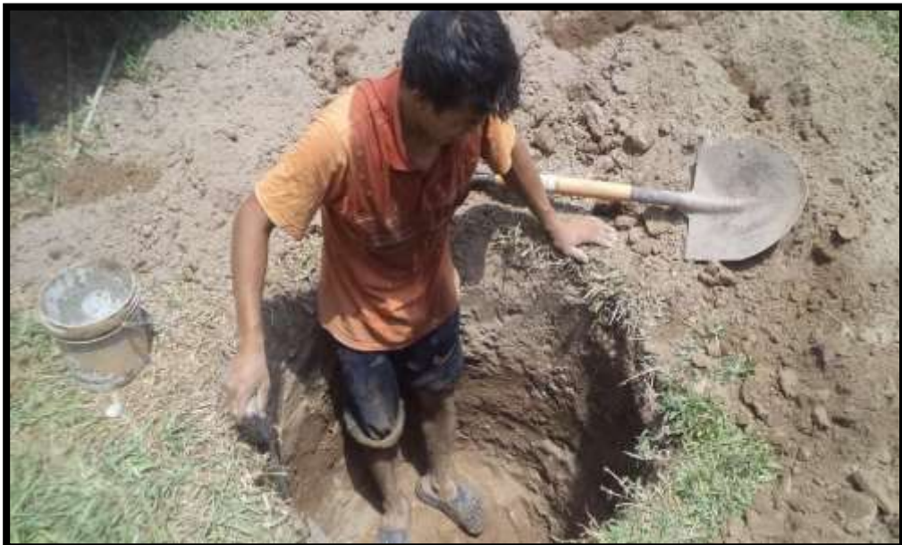
Excavación de la calicata
