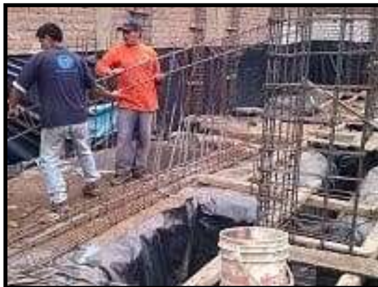
Figura 24. Foto de polietileno colocado en cimientos Urb. La Floresta – Los Olivos.
