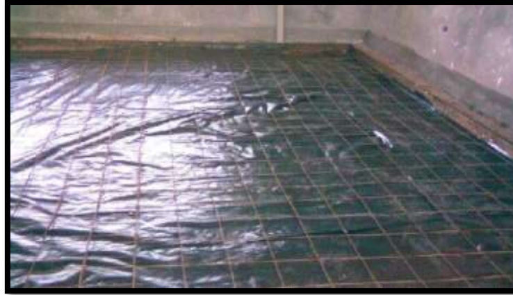
Figura 21. Prevención contra la humedad con polietileno
