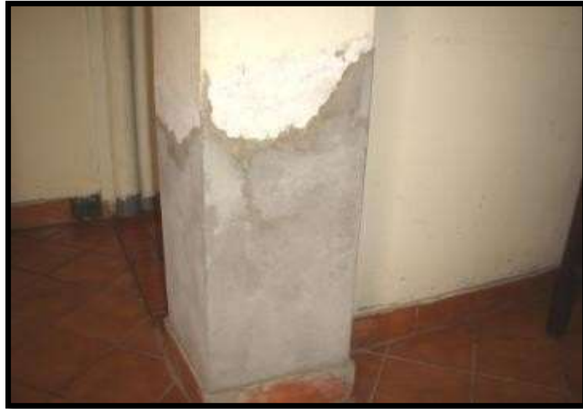
Figura 26. Reparación de la zona afectada debido a la humedad
