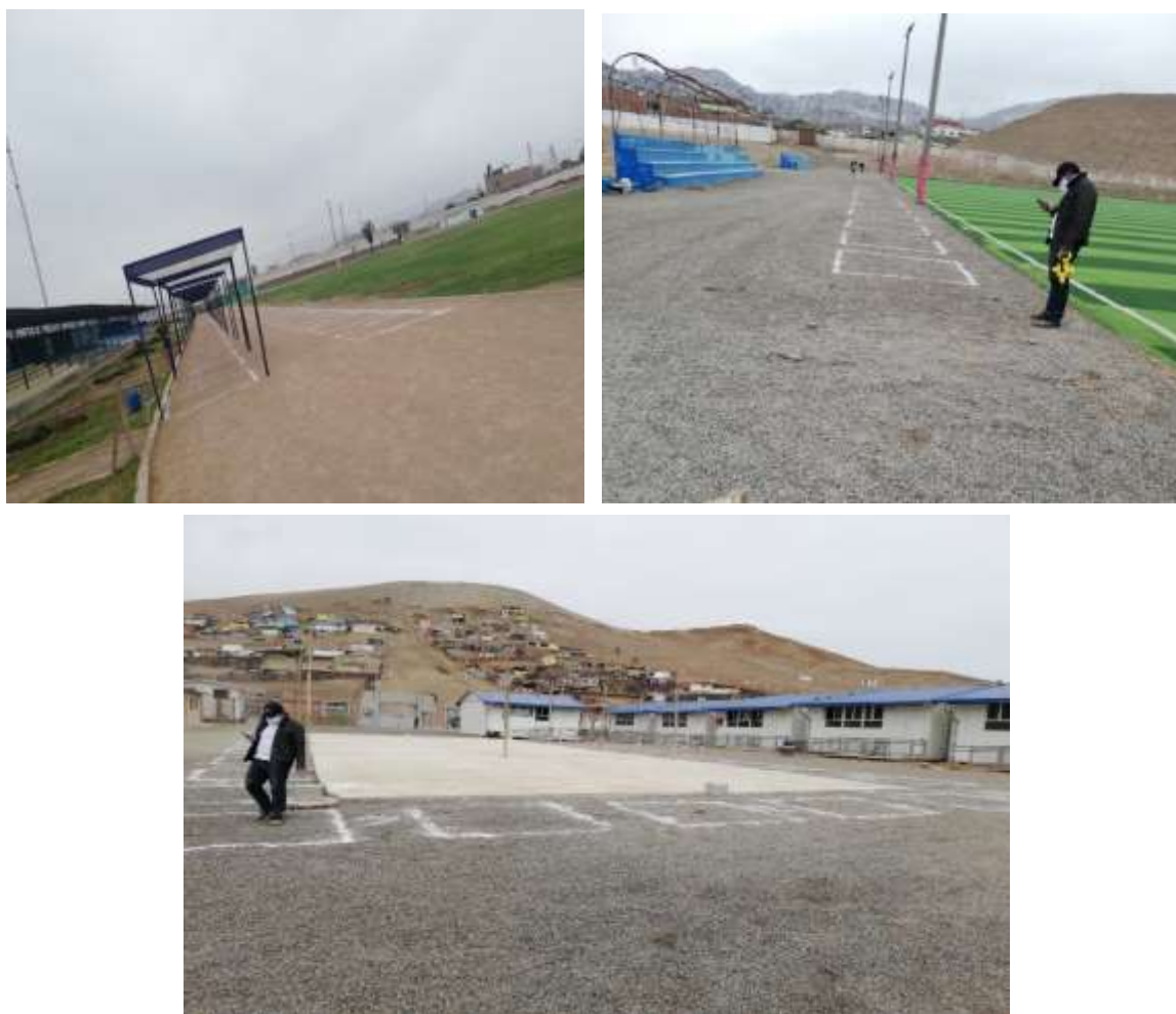
Figura 31: Trazado y colocación de toldos para los módulos del mercado itinerario ubicado en los tres sectores del distrito de Ancón.
