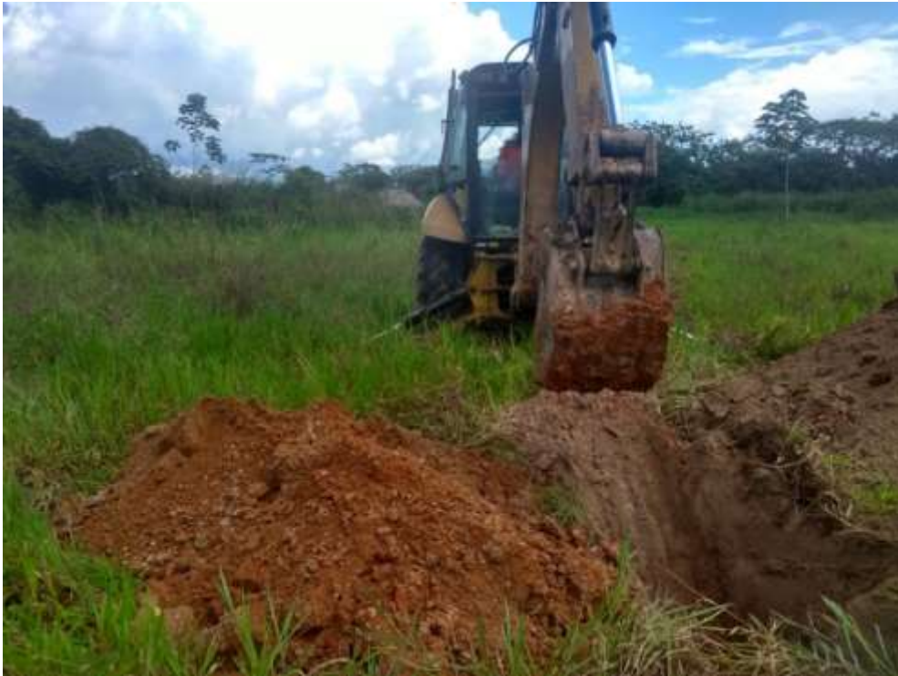
Figura 30. Excavación con Retroexcavadora en la Cantera San José
