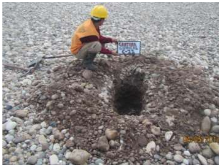
Figura 34. Vista del material de la calicata en la Cantera Guimeal
