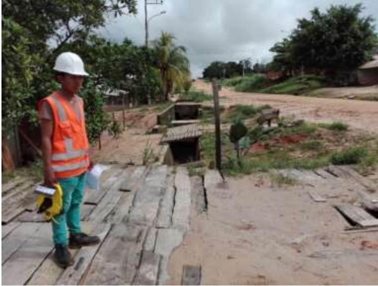
Figura 49. Mediciones y reporte de inicio de la obra
