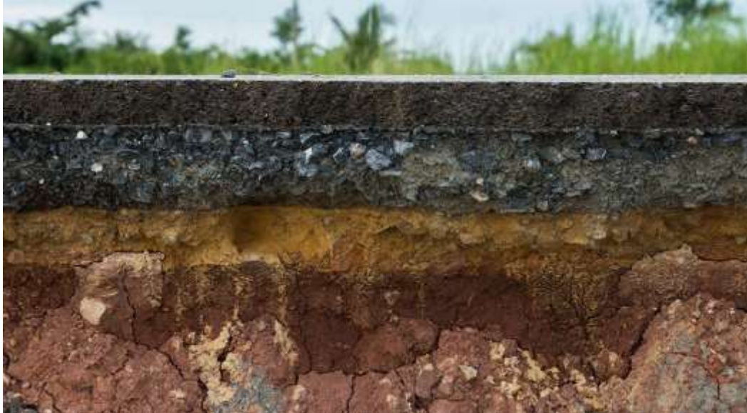
Figura 7. Capas por niveles de la subrasante del suelo Fuente: Revista de Ingeniería de Suelos en las Vías Terrestres
