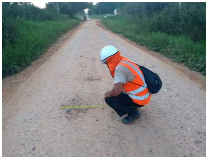
Figura 48. Presencia de baches con un nivel de severidad alto en los suelos.
