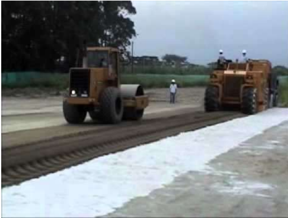
Figura 14. Estabilizadores Químicos en el suelo.
