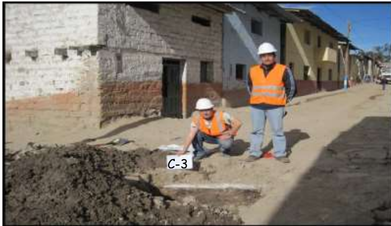
Figura 51. Ensayos de calicatas efectuadas en la parte laterales de las vías.
