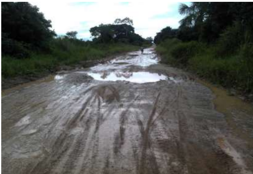
Figura 46. Carretera de la vía inundada por agua – Factor Climático
