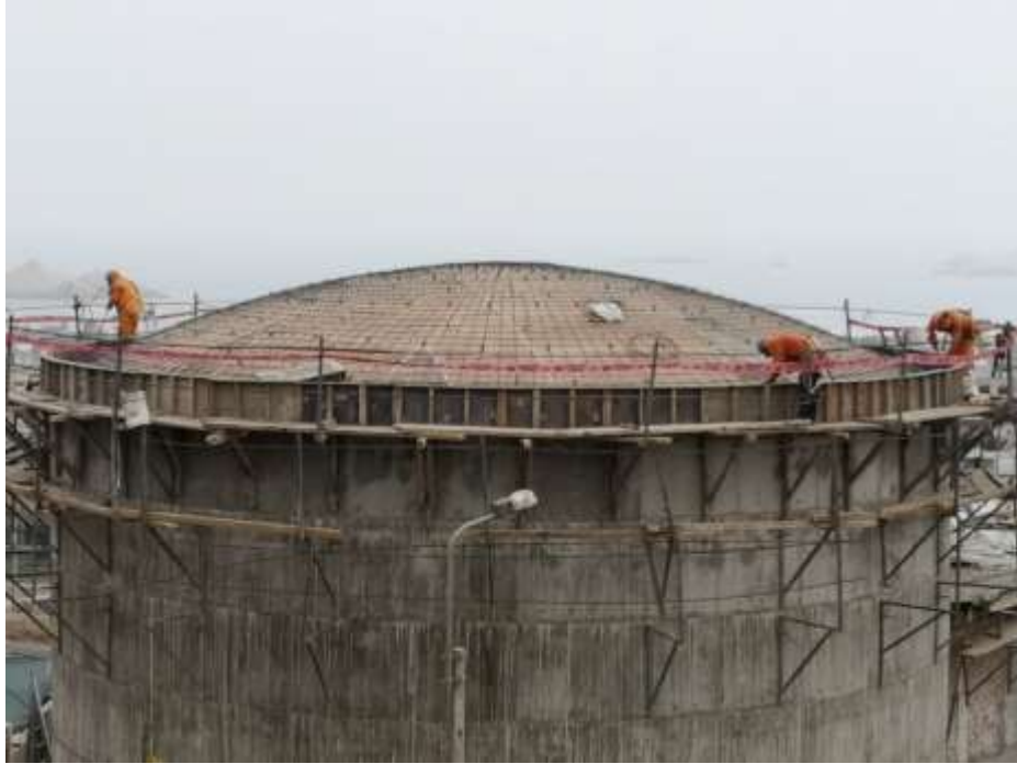
Figura 41 Colocación de encofrado externo de viga collarín
