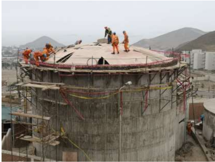
Figura 37 Colocación de paneles de triplay
