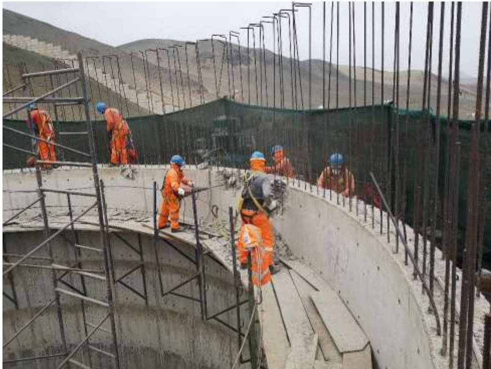
Figura 29 Inicio de demolición, anillo 6
