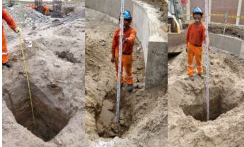
Figura 9 Calicatas para exploración del terreno
