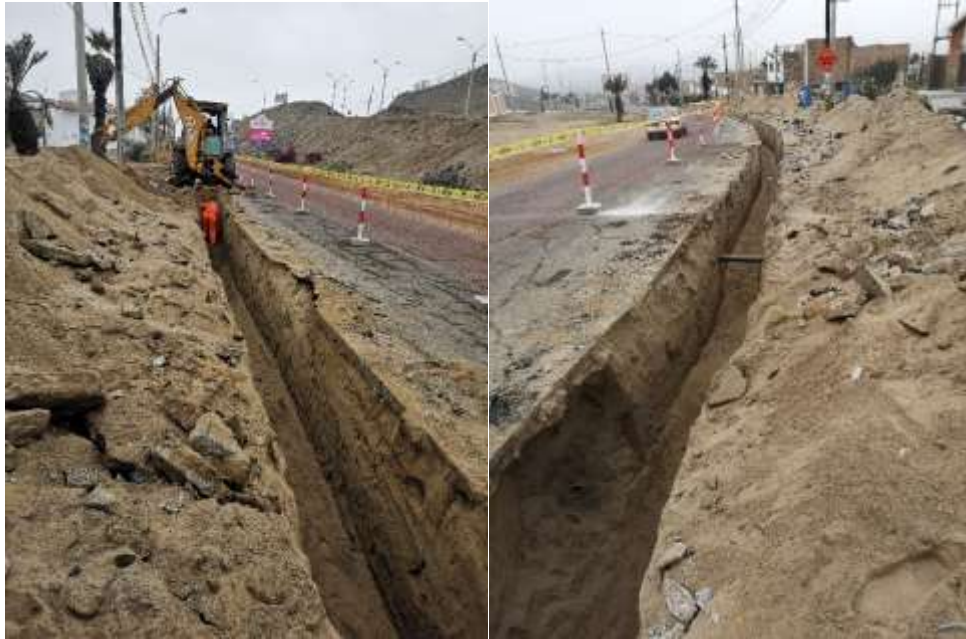
Figura 79 Excavación de línea de impulsión
