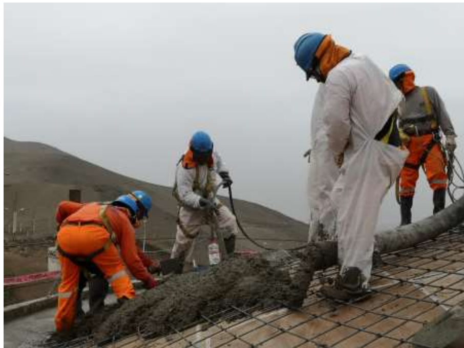
Figura 42 Vaciado de losa y viga collarín
