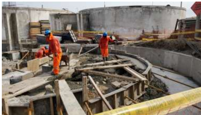
Figura 13 Vaciado del solado de reservorio
