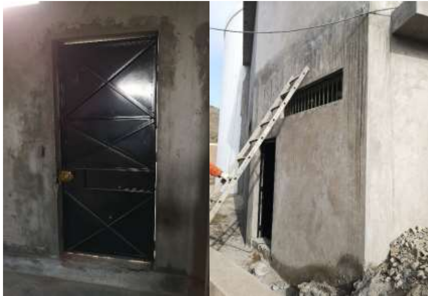
Figura 60 Colocación de puerta y ventanas en caseta de válvulas
