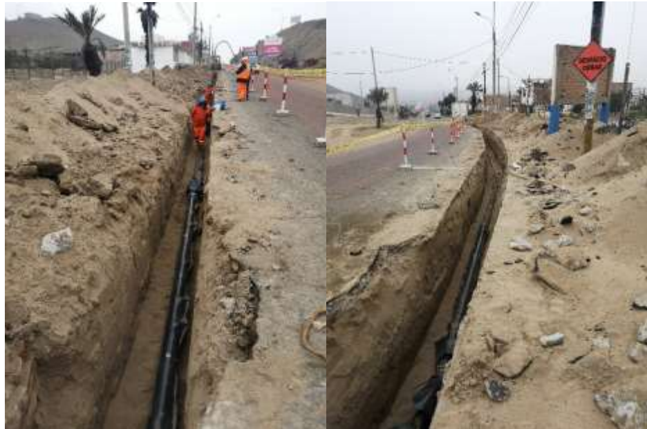
Figura 80 Instalación de tubería para línea de impulsión
