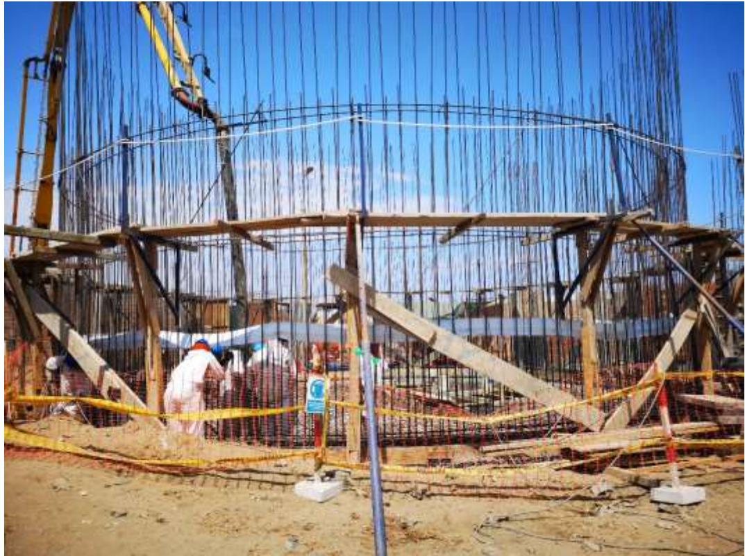
Figura 19 Vaciado del cimiento y losa más colocación de waterstop
