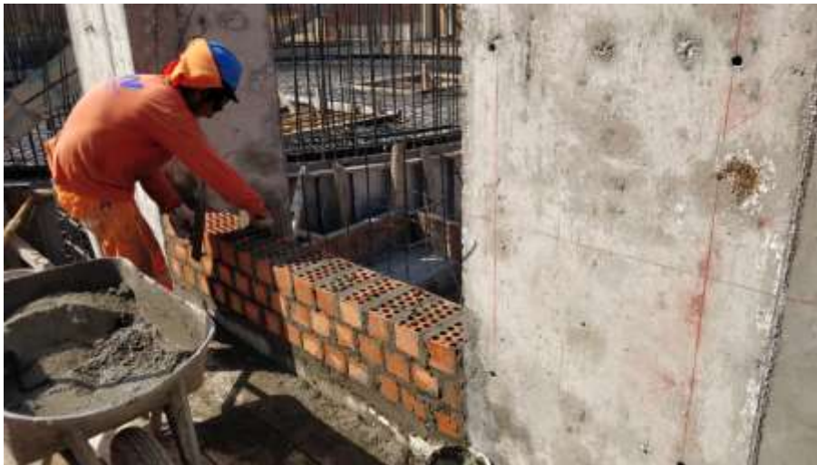
Figura 53 Colocación de mampostería
