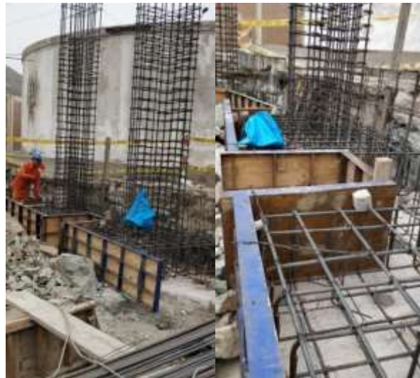
Figura 49 Colocación de encofrado de la zapata aislada
