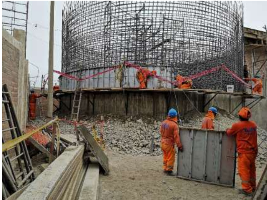
Figura 31 Encofrado del anillo 3
