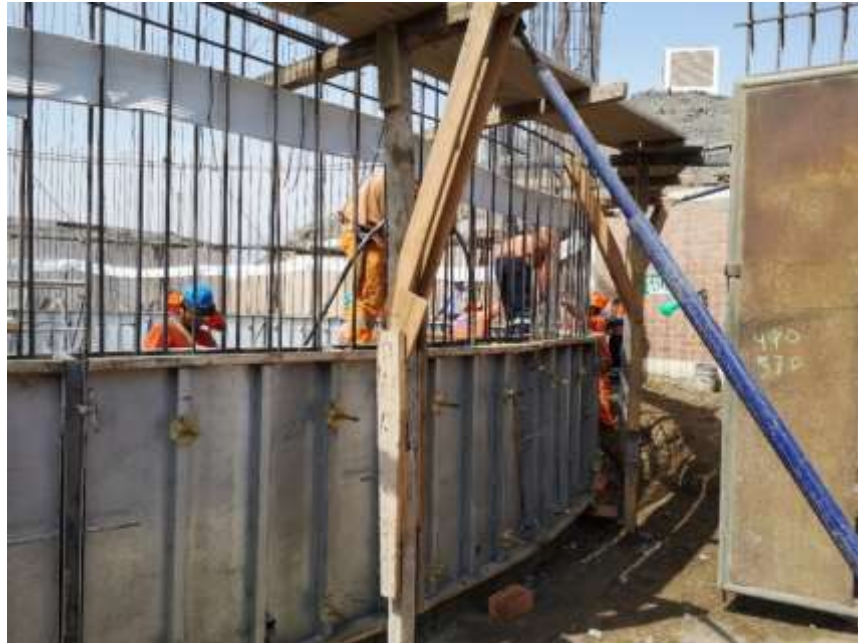
Figura 23 Vaciado de anillo 1
