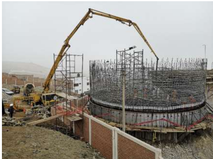
Figura 32 Vaciado del anillo 3
