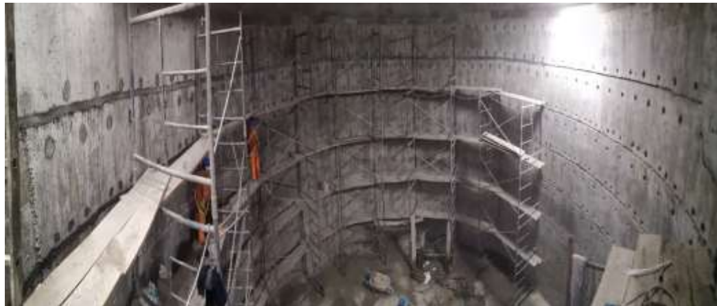
Figura 64 Colocación del Per Grout Mortar
