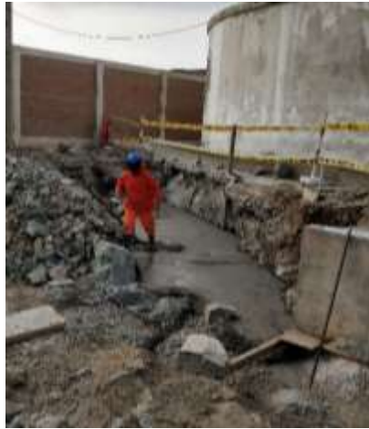
Figura 7 Vaciado de solado
