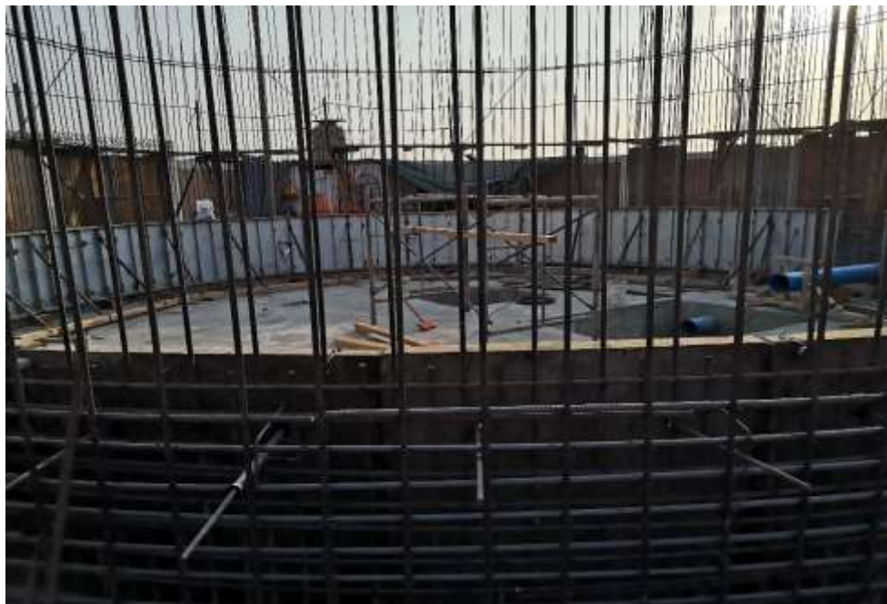
Figura 22 Encofrado de anillo 1
