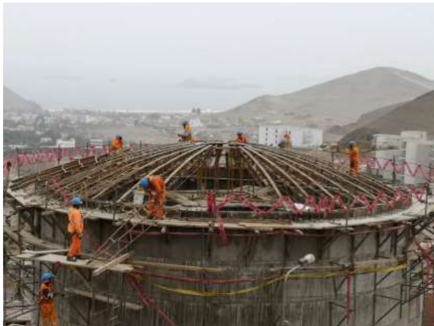
Figura 36 Colocación de puntales
