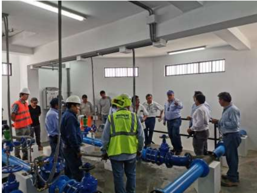
Figura 93 Verificación del funcionamiento para recepción de obra
