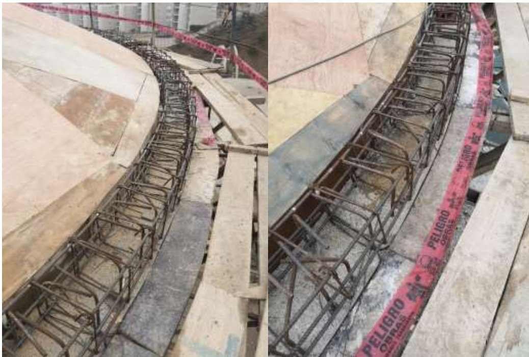
Figura 38 Colocación armadura de refuerzo en viga collarín
