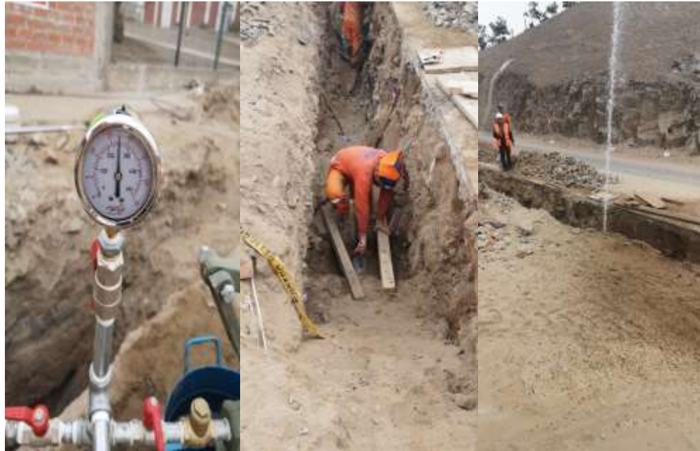
Figura 81 Prueba hidráulica a 333 ml
