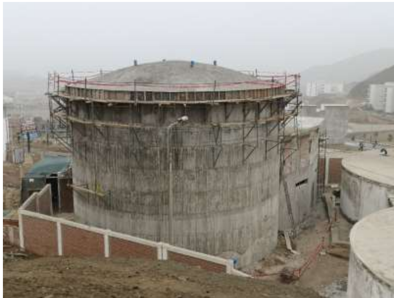
Figura 44 Ultimo vaciado con concreto premezclado
