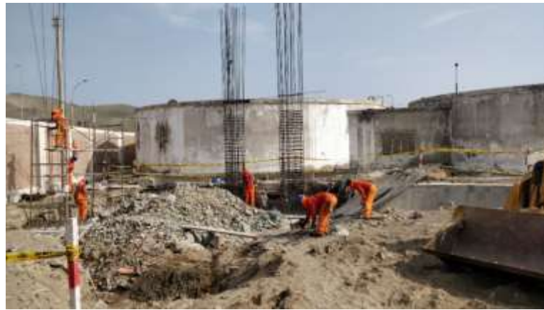
Figura 48 Colocación de acero de la zapata aislada
