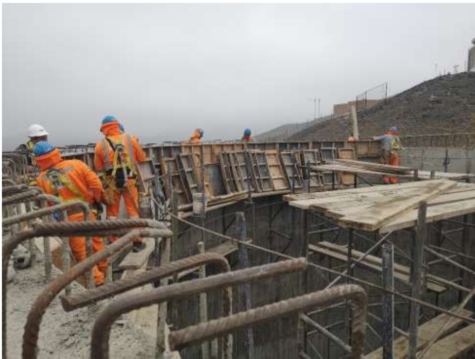
Figura 34 Encofrado viga collarín
