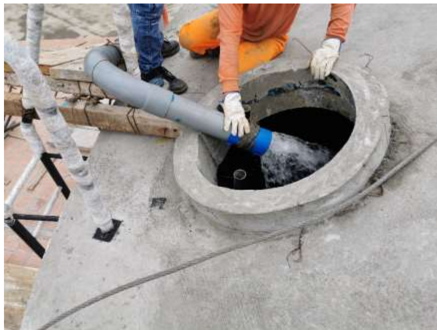
Figura 68 Llenado del reservorio
