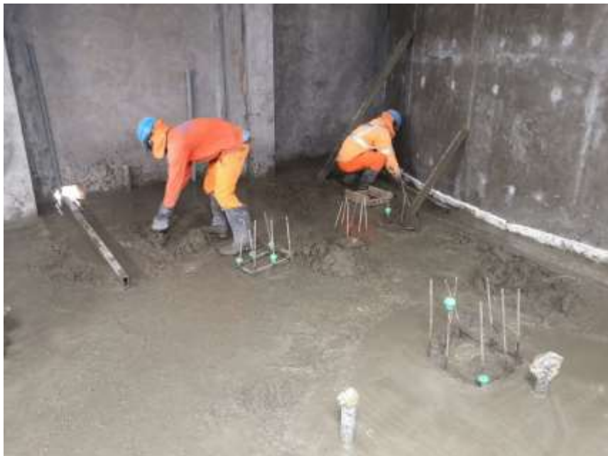
Figura 59 Acabado de piso en caseta de válvulas
