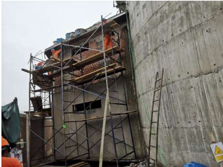
Figura 57 Tarrajeo exterior de la caseta de válvulas
