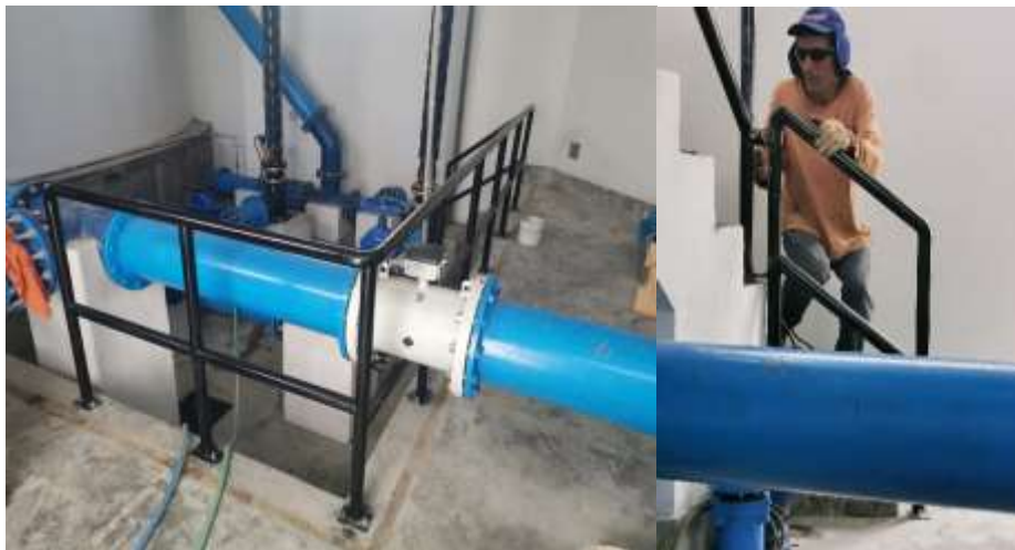
Figura 90 Instalación de baranda
