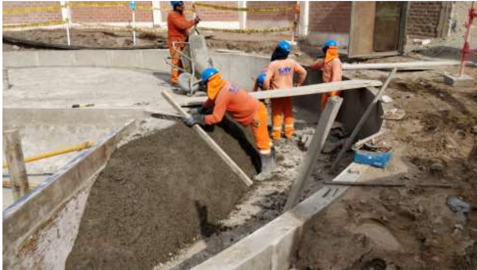
Figura 14 Vaciado del solado de reservorio
