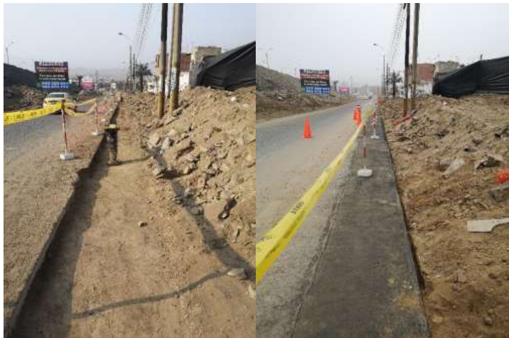
Figura 82 Tapado y reposición de asfalto 333 ml
