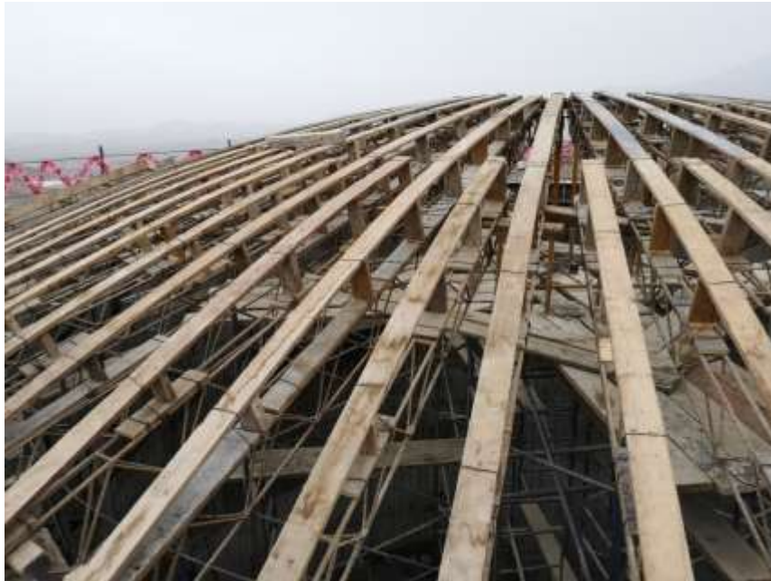
Figura 35 Colocación de soleras
