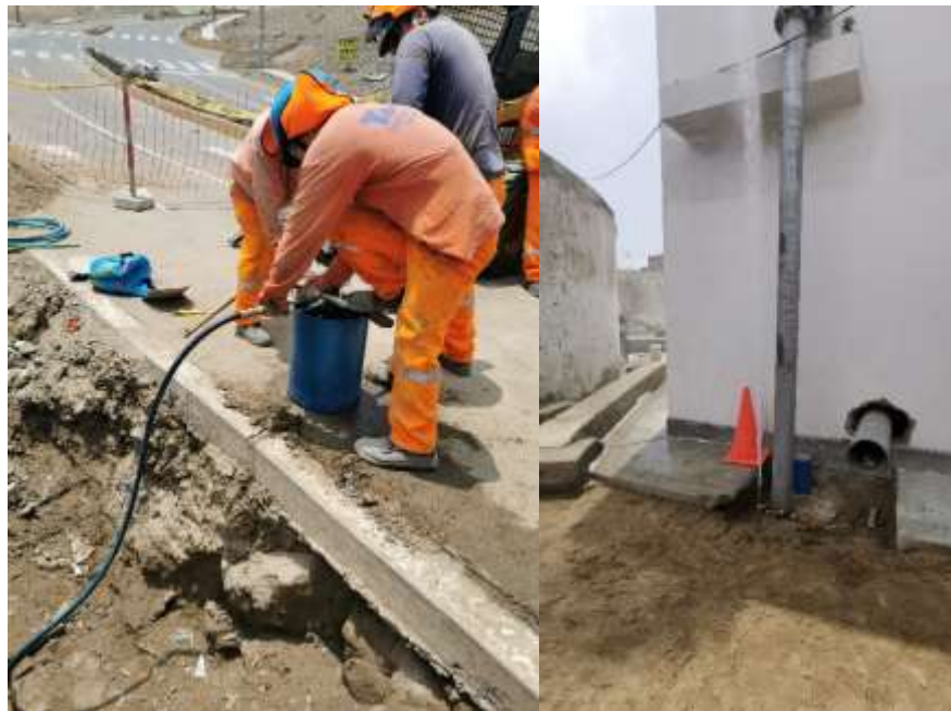
Figura 84 Prueba hidráulica total del tramo 532 ml
