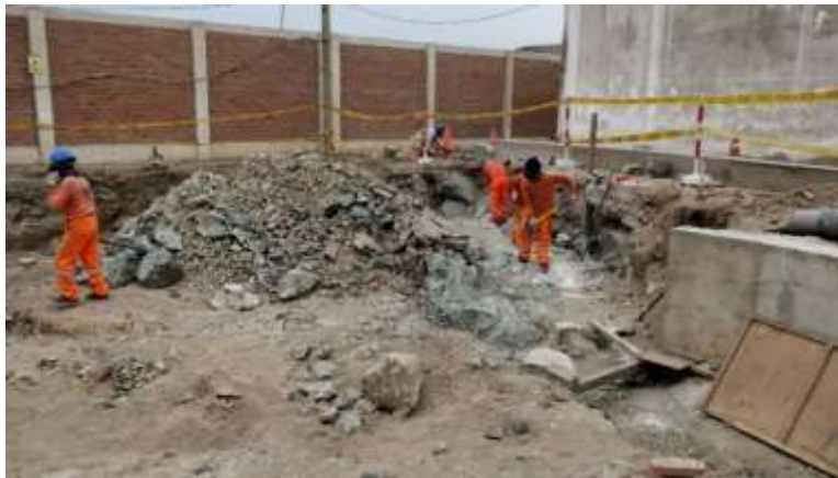
Figura 46 Excavación para caseta de válvulas
