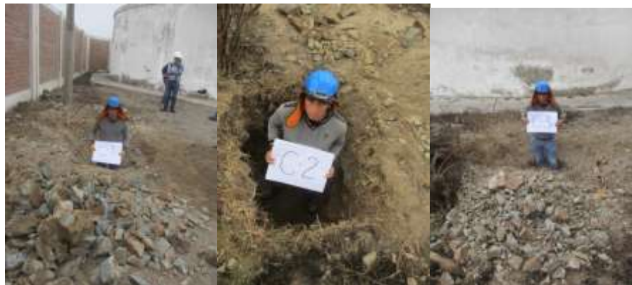
Figura 4 Excavación de calicatas para ensayos de suelo
