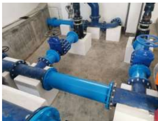
Figura 91 Cajuela acabada diseñada por el cambio de cotas
