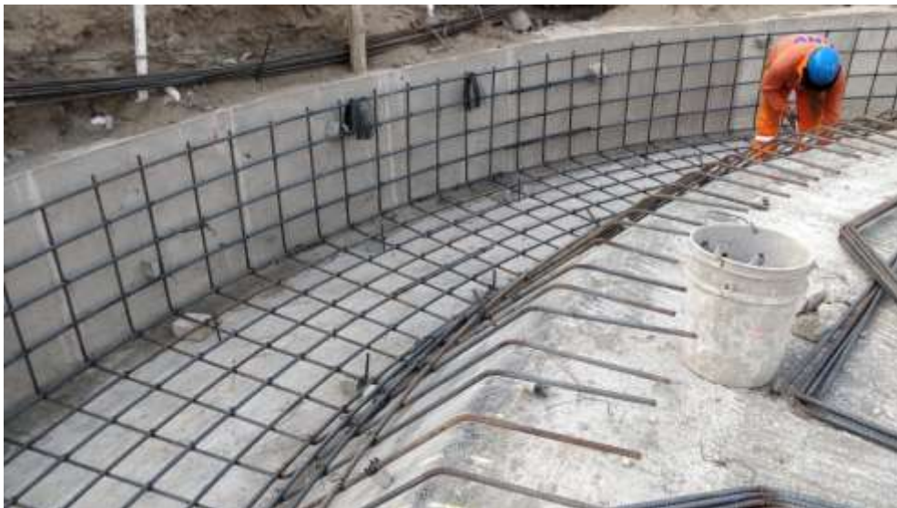
Figura 15 Enmallado del cimiento
