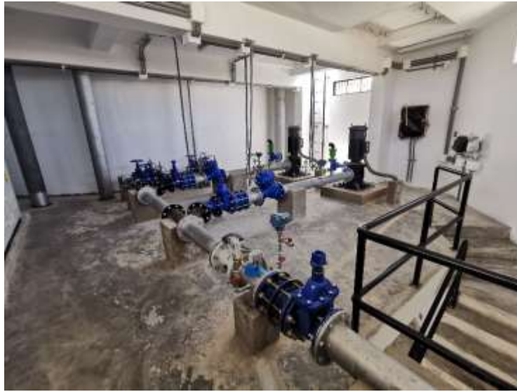
Figura 76 Árbol hidráulico segundo piso
