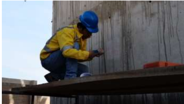
Figura 26 Ensayo de esclerometría
