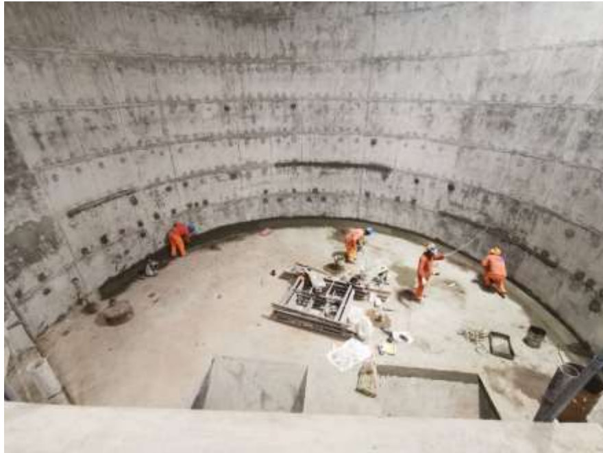
Figura 71 Resane de filtraciones
