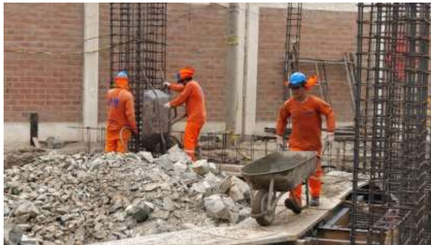
Figura 50 Vaciado de la zapata aislada
