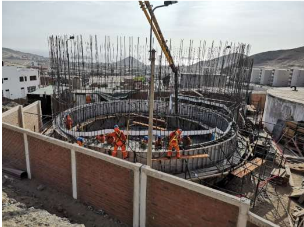
Figura 25 Vaciado Anillo 2
