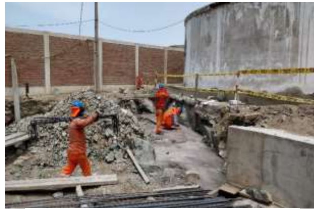
Figura 6 Trazo de zapatas aisladas
