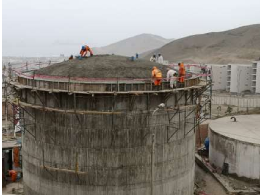
Figura 43 Nivelación y pulido de lo vaciado
