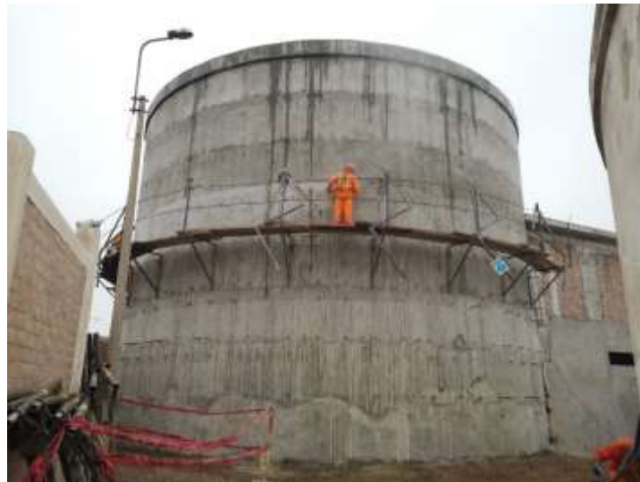
Figura 66 Solaqueo de la parte externa del reservorio
