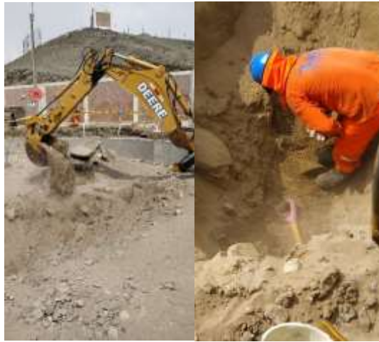
Figura 8 Excavación para la cimentación del reservorio
