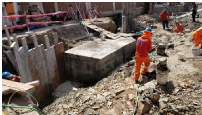
Figura 10 Construcción falsa zapata
