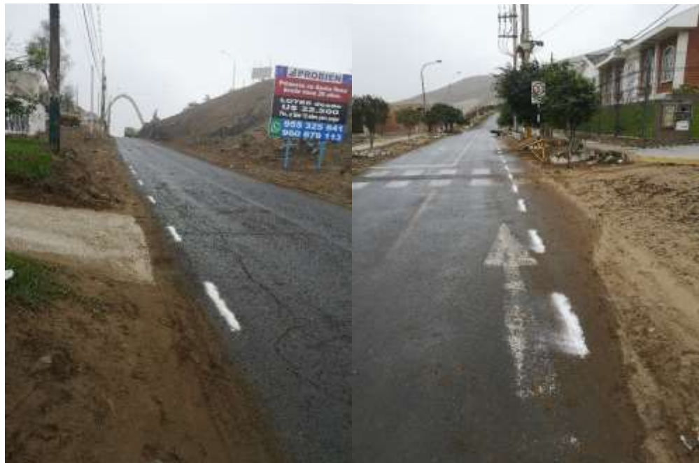
Figura 78 Trazo para excavación de línea de impulsión
