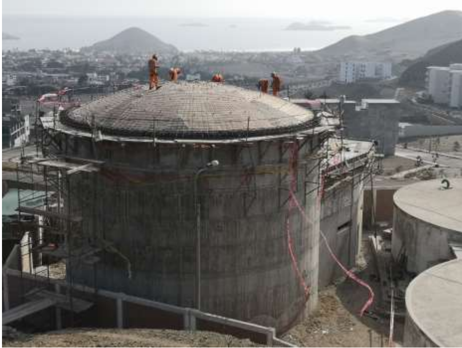
Figura 39 Colocación de acero de refuerzo para losa de cúpula
