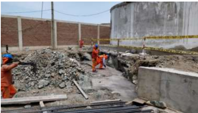
Figura 47 Trazo para colocación de zapatas
