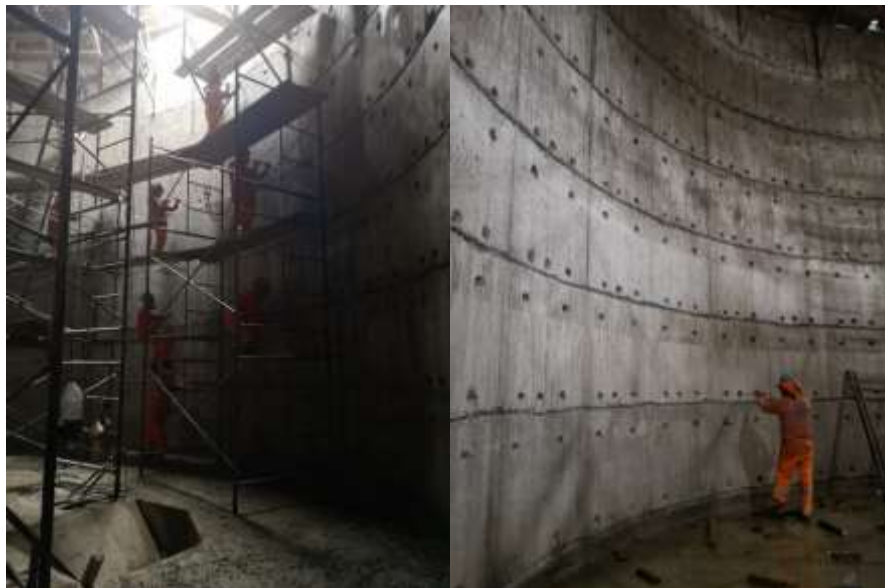
Figura 62 Picado de las juntas y acceso de separadores para reparación con PERGROUT MORTAR
