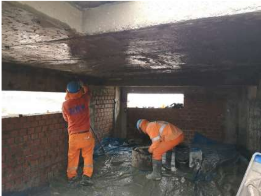
Figura 58 Tarrajeo interior de la caseta de válvulas
