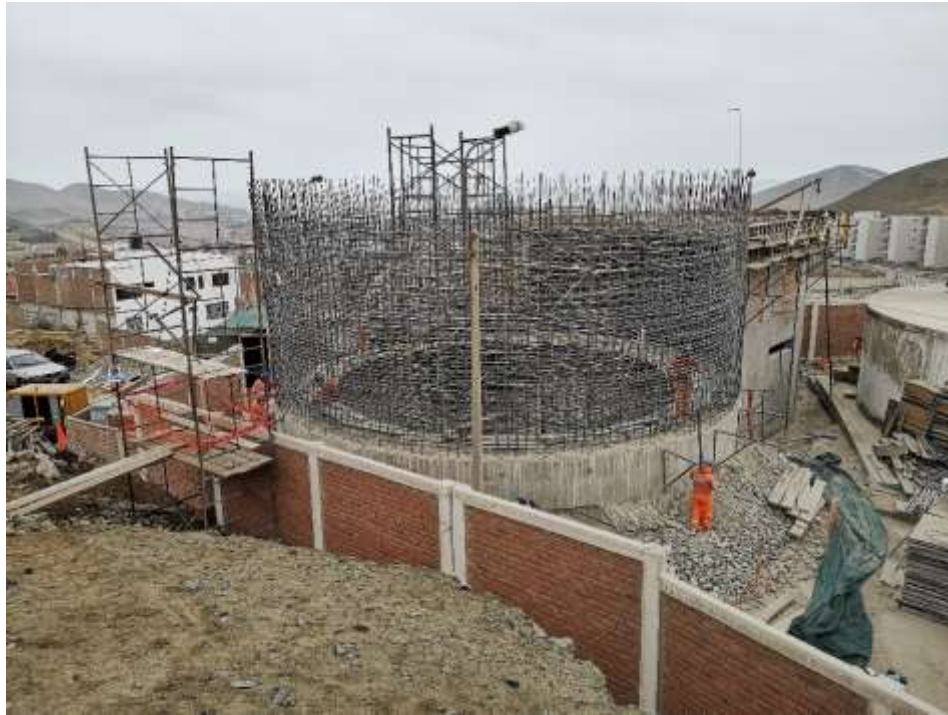
Figura 30 Culminación de la demolición, anillo 3
