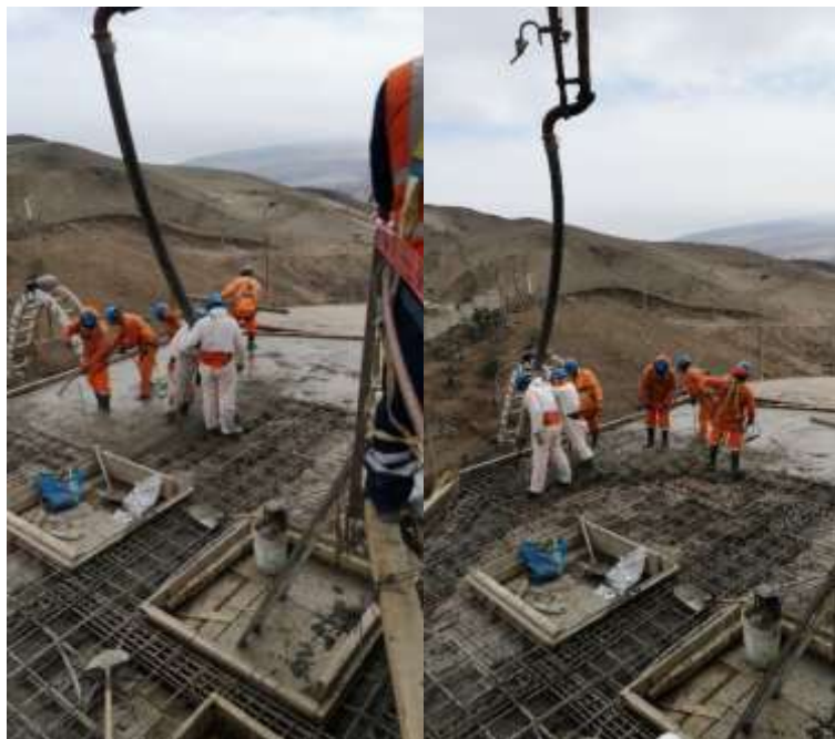
Figura 56 Vaciado de losa maciza
