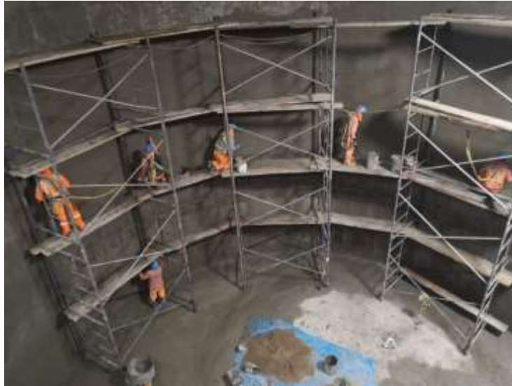
Figura 65 Solaqueo de la parte interior del reservorio
