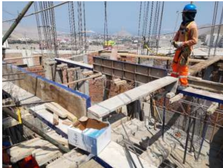
Figura 54 Colocación de encofrado para losa maciza y vigas
