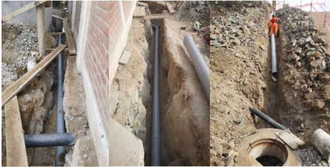
Figura 77 Instalación línea de rebose
