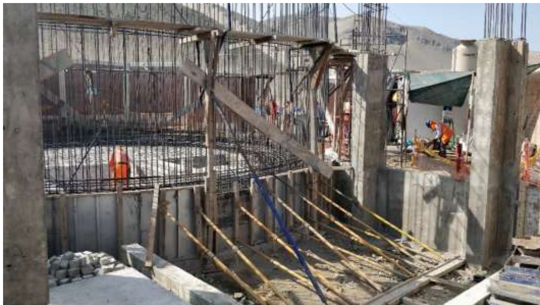
Figura 18 Encofrado del cimiento
