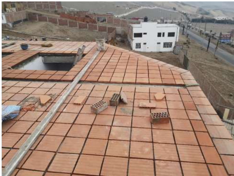
Figura 61 Colocación de ladrillos pasteleros en caseta de válvulas
