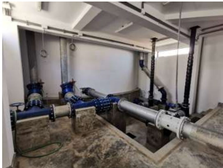
Figura 75 Árbol hidráulico primer piso
