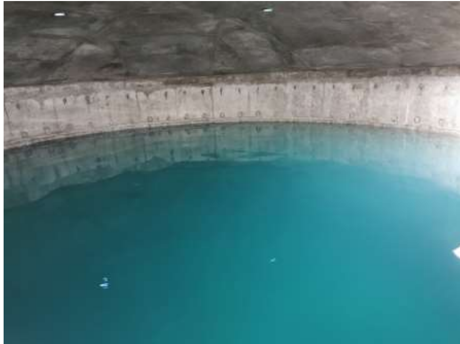
Figura 69 Culminación del llenado de reservorio
