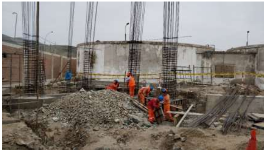
Figura 51 Desencofrado de la zapata aislada
