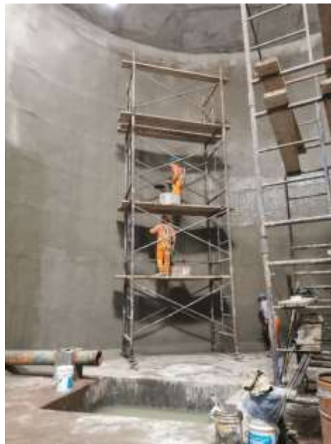
Figura 72 Resane de filtraciones
