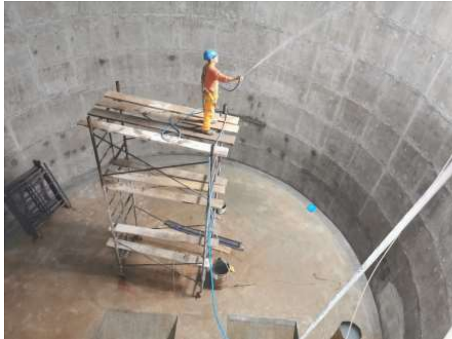
Figura 67 Curado y saturación del reservorio
