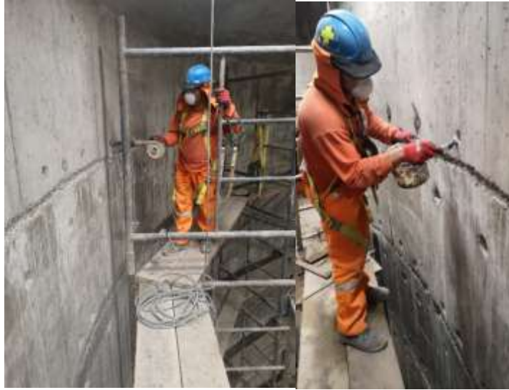
Figura 63 Limpieza y aplicación del Perpox 32
