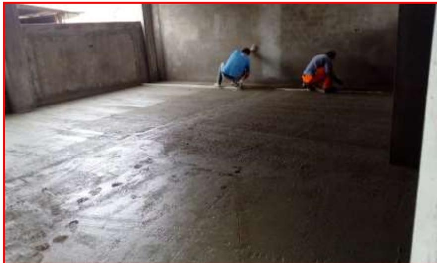
**Imagen 9.** Toma de datos, partida contrapiso frotachado, muestra N°2.
