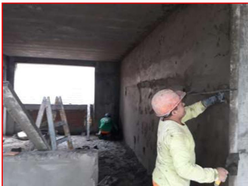
**Imagen 8.** Toma de datos, partida tarrajeo de muros, muestra N°2.
