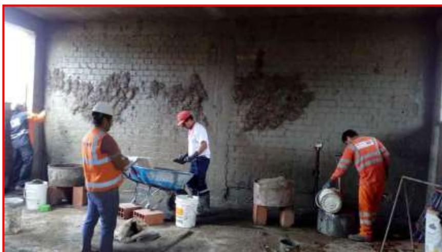
**Imagen 4.** Toma de datos, partida tarrajeo de muros, muestra N°1.
